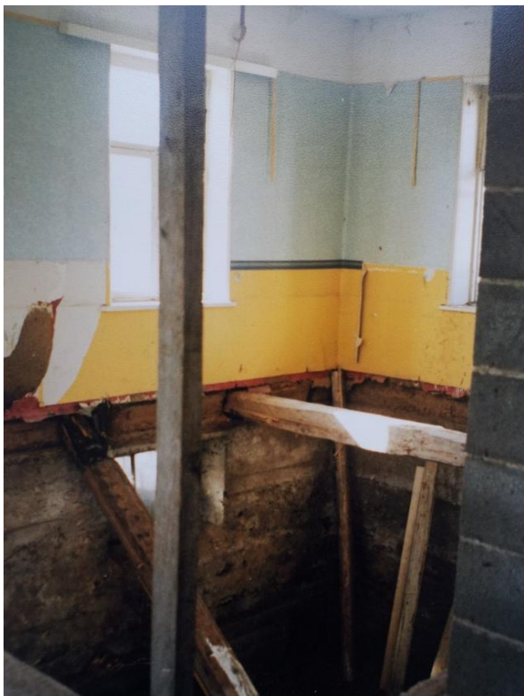
Pilt 8. Vaade esimese korruse kandekonstruktsioonidele. ( Allikas R. Jõgi erakogu )
