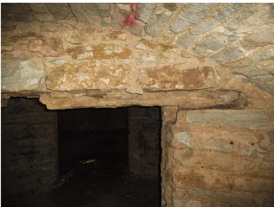
Foto 22. Põhjapoolse keldri esimene ja teise ruumi vahelise ukseava varisenud sillus
