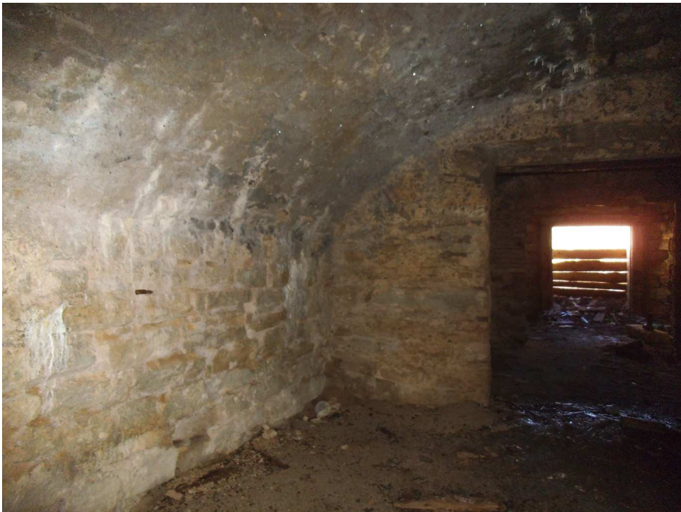
Foto 26. Väljasooldusmised põhjapoolse keldri seintel
