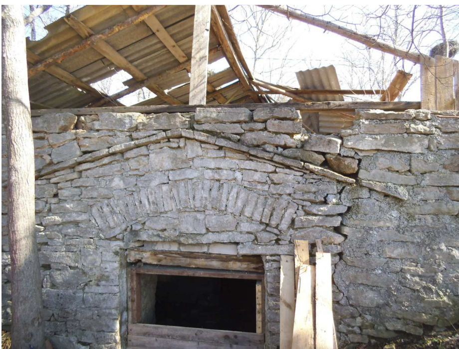
Foto 7. Hoone läänepoolne esifassaad.
