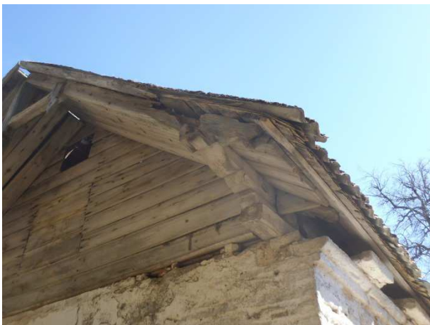
Foto30. Puitdekoor põhjapoolse viilu all
