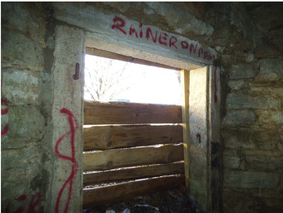
Foto 14. Põhjapoolse keldri välisukse piirded
