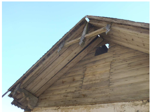
Foto31. Puitdekoor põhjapoolse viilu all
