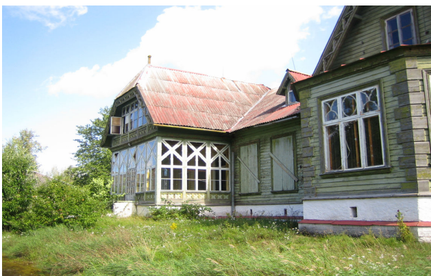
Foto 6.1. Hoone läänekülj enne restaureerimist
