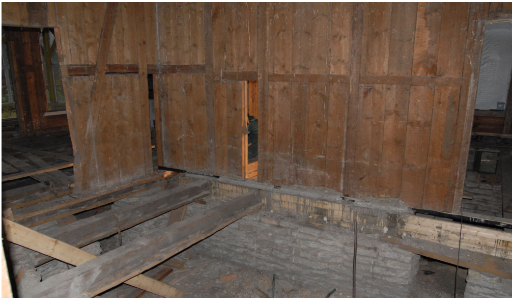
Foto 4. Vundamentide tugevdamine ja katmine hüdroisolatsiooniga.
