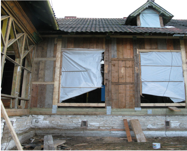
Foto 7. Ilma laudise ja akendeta fassaad hoone lääneküljel.
