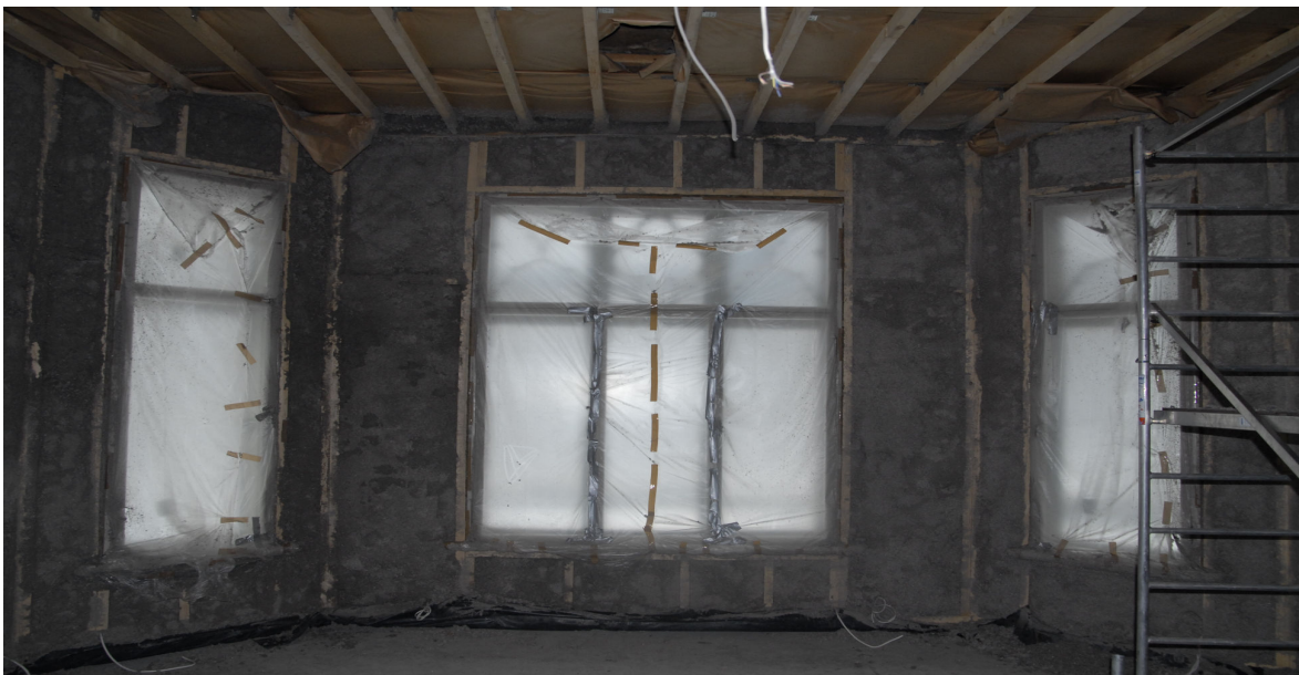
Foto 7.1. Välisseina soojustamine tselluvillaga.
