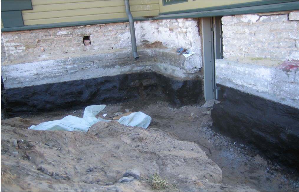
Foto 3. Vundamendi puhastamine ja katmine hüdroisolatsiooniga.
