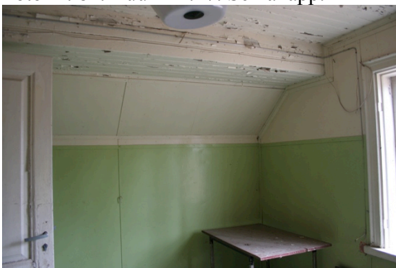
Foto nr. 82. Ruum nr.16. Algne lae konstruktsioon.
