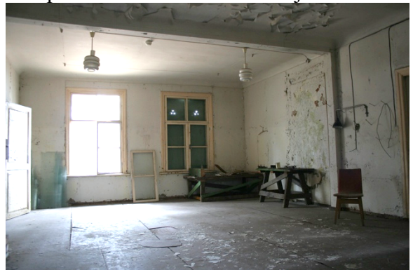
Foto nr. 47. Vaade elutoas põhja poole. Pildil puidust pilaster (parempoolne) ja horisontaalne laetala, soemüür ja ruumi nr.6 uks SU6 (vasakul).
