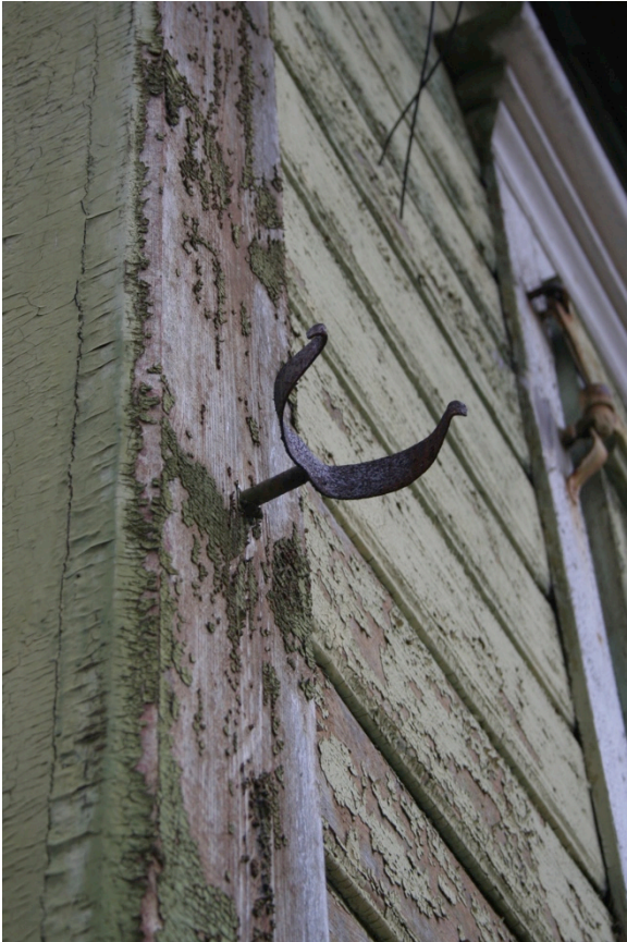
Foto nr. 23. Vihmavee toru kinnitusdetail (edela nurk).
