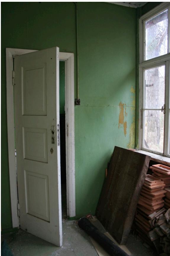
Foto nr. 61. Veranda uks SU1 seest poolt.
