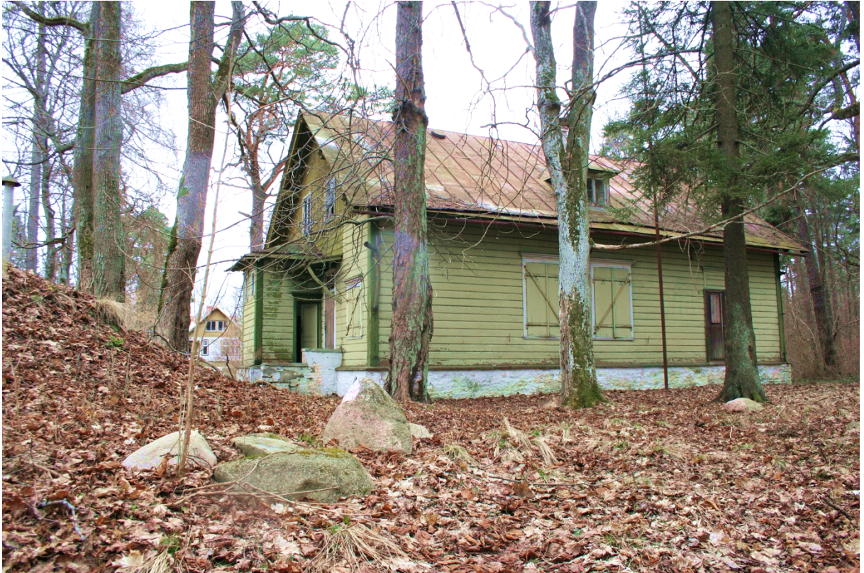
Foto nr.3. Hoone vaade põhjast 1.
