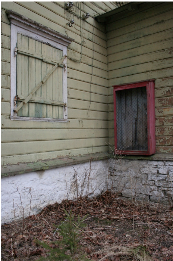
Foto nr. 12. Tuletõrjevooliku kast.
