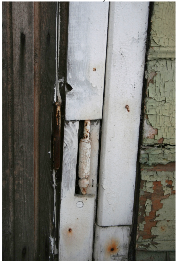
Foto nr. 34. Köögi ukse VU2 originaalleng hingega.
