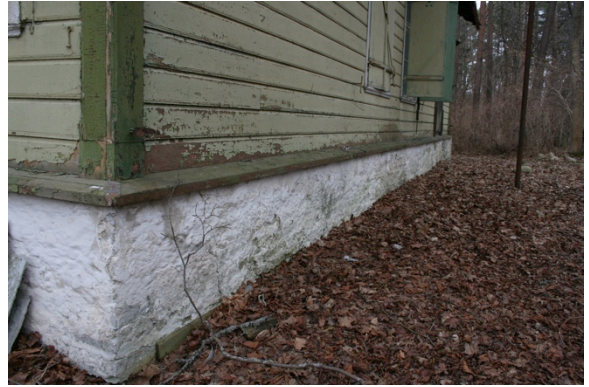
Foto nr. 17. Sokli vaade põhjafasaadil.
