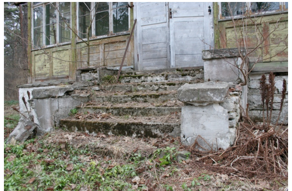
Foto nr.8. Peasissepääsu trepp.
