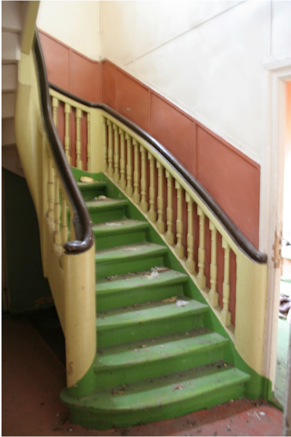
Foto nr. 72. Sisetrepp.
