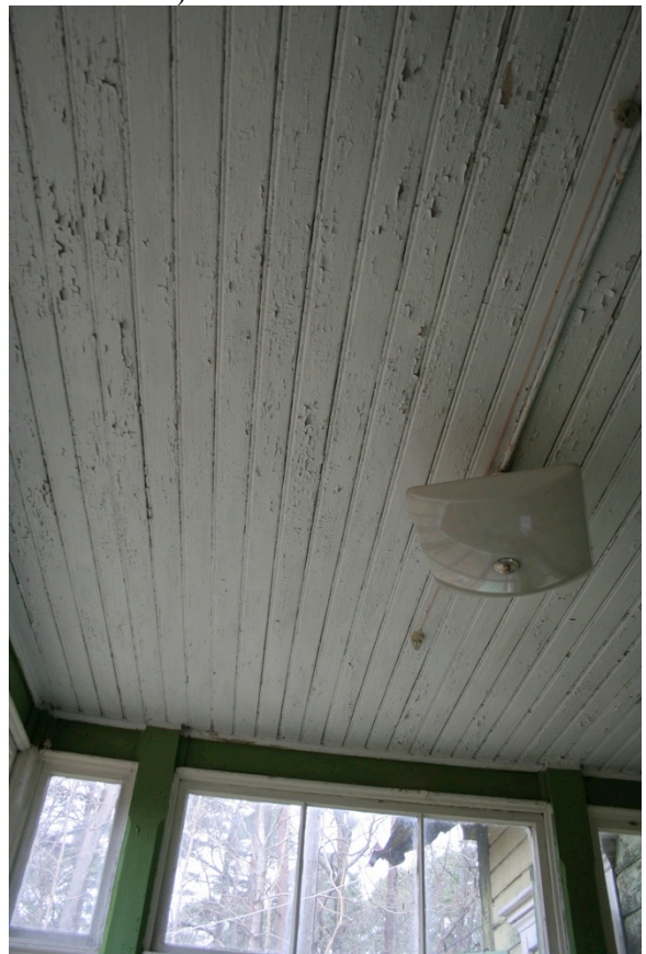
Foto nr. 63. Lagi ruumis nr.2.
