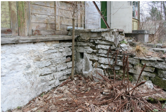
Foto nr.6. Veranda sokkel ja sissepäästrepid vasak külj.
