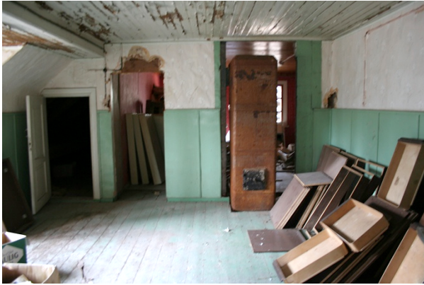
Foto nr. 76. Ruum nr.13. Katusealune panipaik, uks SU13, vahesein ruumiga nr.14 ja hilisem plekkahi.
