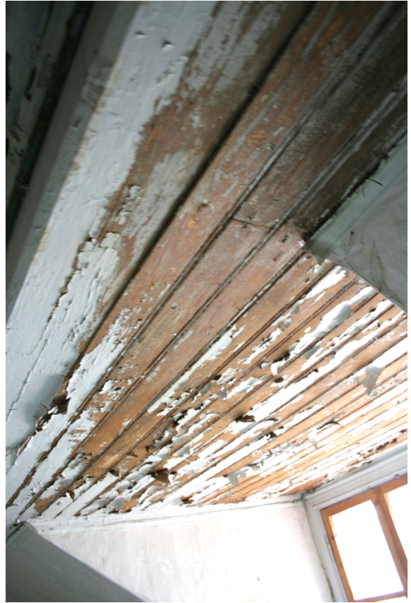
Foto nr. 74. Lagi ruumis nr.13.
