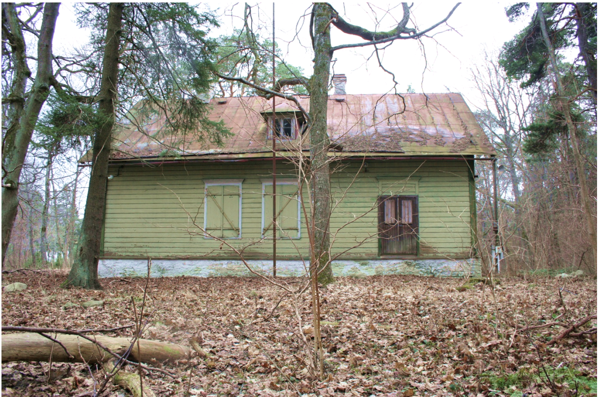
Foto nr.4. Hoone vaade põhjast 2.
