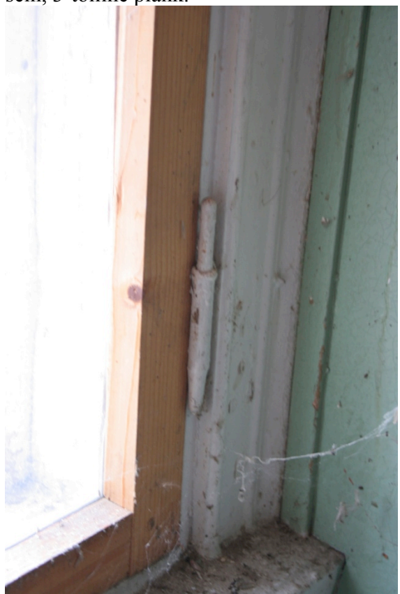
Foto nr. 88. Aken A13 – hilisem siseraam, originaalleng ja hinge osa.
