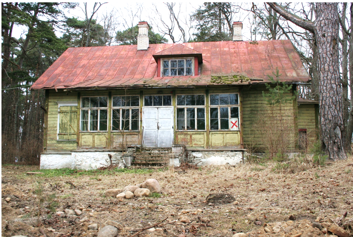
Foto nr. 1. Hoone vaade lõunast.
