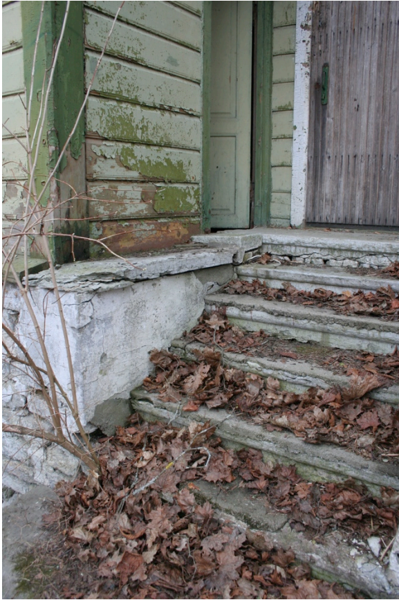
Foto nr. 15. Köögi trepp.
