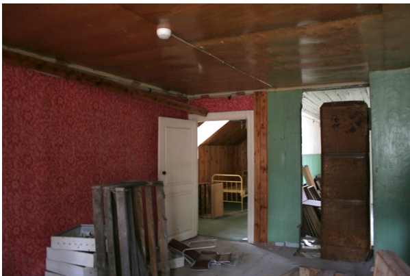
Foto nr. 78. Ruum nr.14. Uks SU14, vineerlagi. Paremäl plekkahi ja algne korstnälalg.
