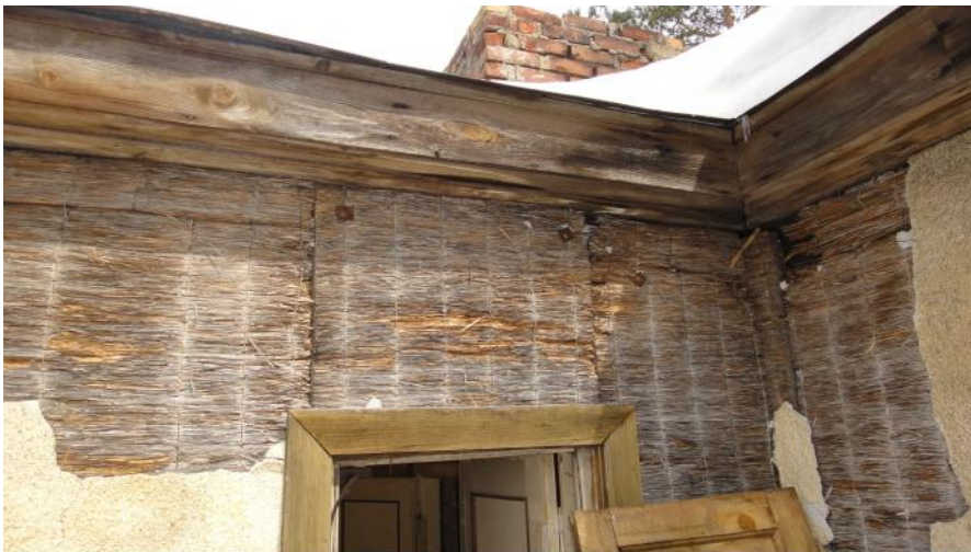
Foto 9. Eemaldunud krohv rõdu seinal
