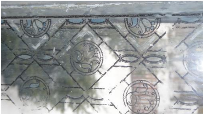
Foto 22. Mustriga klaas II korruse pesuruumis
