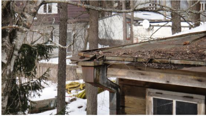
Foto 19. Säilinud sadeveesüsteem
