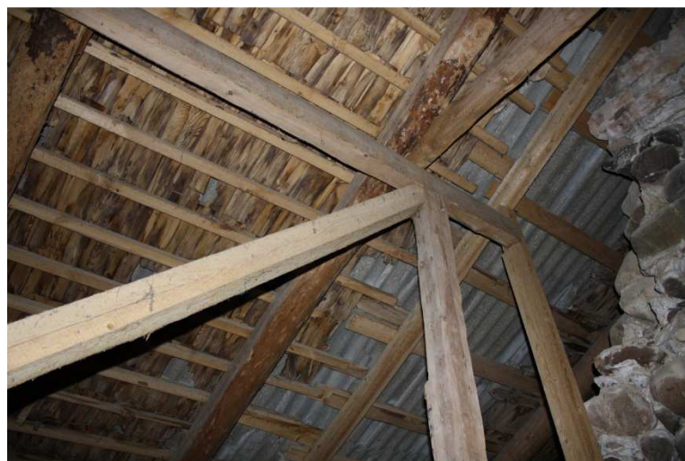
Foto 13. Pööning. Hoonetevaheline lammutatud viiluosa ja eterniit katusekate selle kohal.
