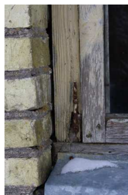
Foto 12. Akna A2 detail- sepishinge kandur.
