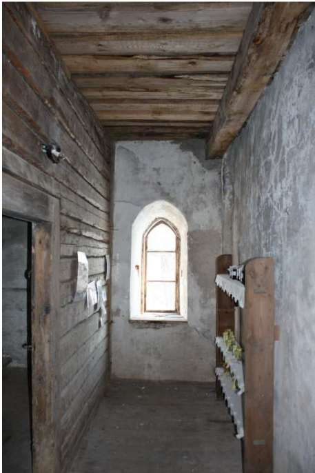
Foto 30. Ruum 3: plankudest sein, lubikrohvitud seinad, gootilik aken A8;
