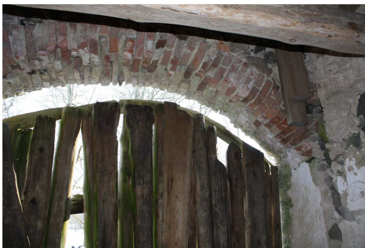
Foto 10. Varisemisohklik kaarsillus ruumis 9, seestpoolt punane tellis, väljast paekivi, sille 3,35m.
