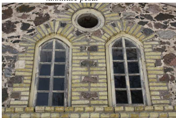
Foto 11. Aknad A3-A5, algupäraste lengide ja raamidega.
