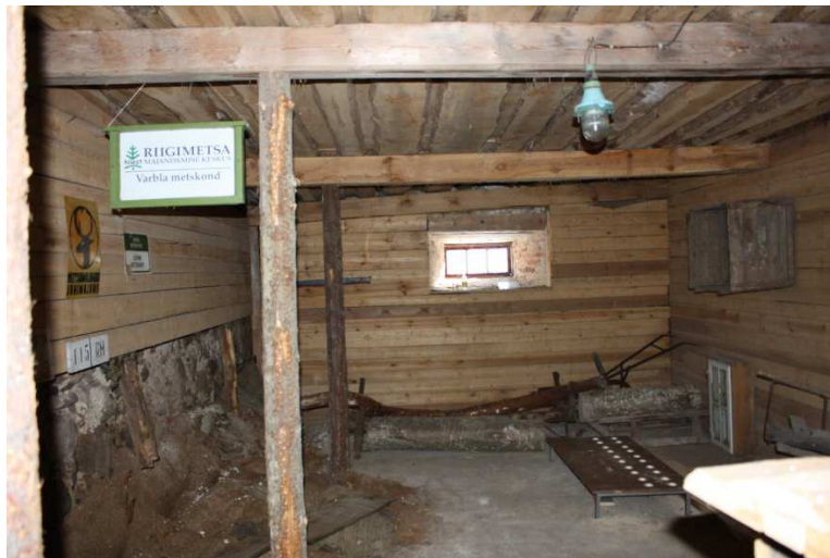
Foto 12. Ruum 7: vahelagi toepostidega, betoonpõrand.
