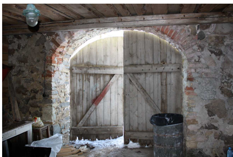
Foto 9. Kaarsillus ruumis 7, seestpoolt punane tellis, välimine osa paekivi, sille 2,67m.
