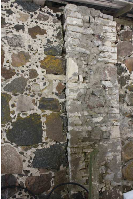
Foto 14. Tsementmördi tarandustega pilaster. Autori foto.
