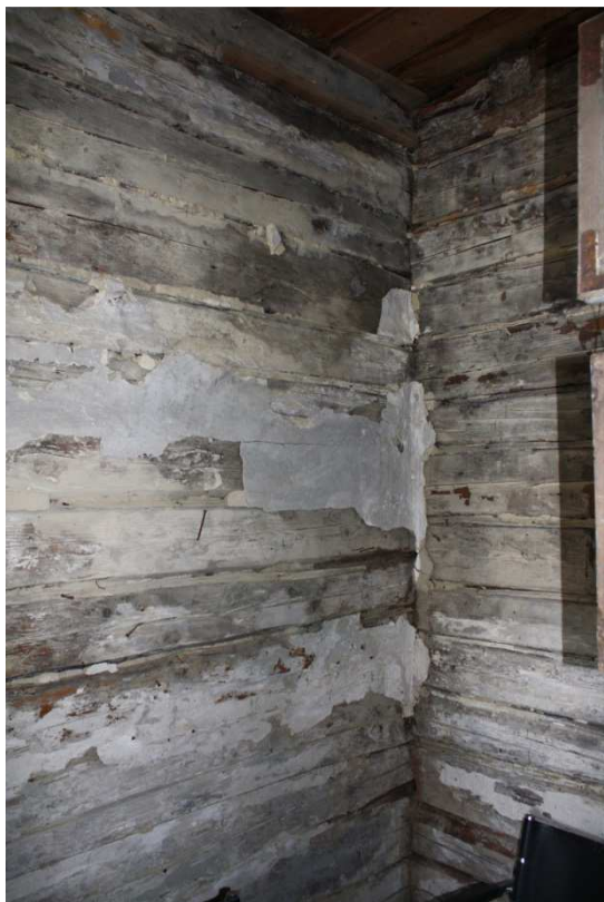
Foto19. Lubjatud (ja lubikrohvitud) tahatud palkidest vaheseinad.
