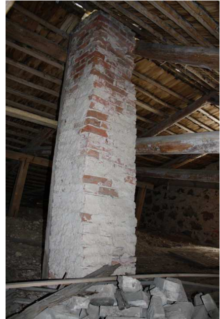
Foto 27. Korstnajaalg ja lammut.korsten r.10. Autori foto
