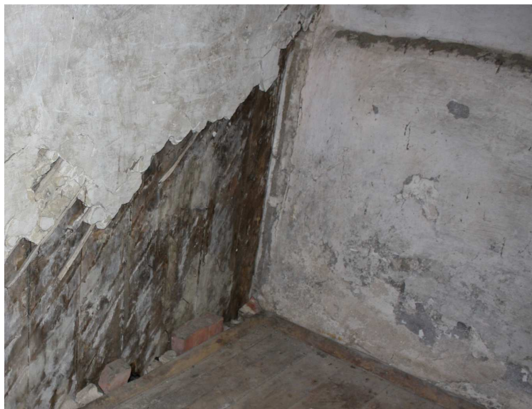
Foto 7. Peerumatil lubikrohvitud planksein, lubikrohvitud ja lubjatud välissein ja põranda nurk ruumis 2.
