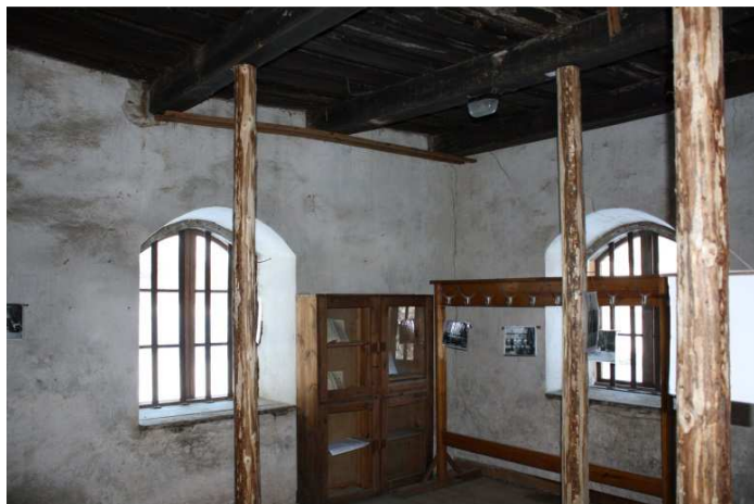
Foto 14. Aknad A2 ja A12 sepisvõred ruumis 5.
