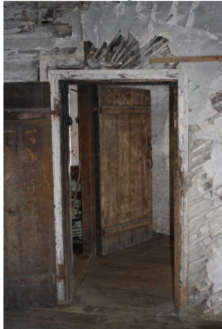
Foto 32. Ruum 2: Uksed U3 ja U1, puitmatil krohv. Autori foto.
