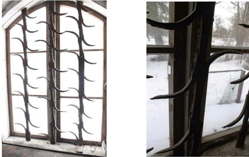
Foto 8. Sepisvõred aknal A13 ja detaili suurendus. Autori fotod
