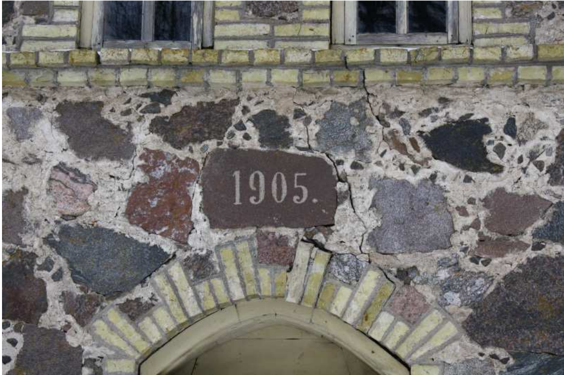
Foto3. Pragu otsafassaadis ja välja nihkunud tellissilluse lukukivid.
