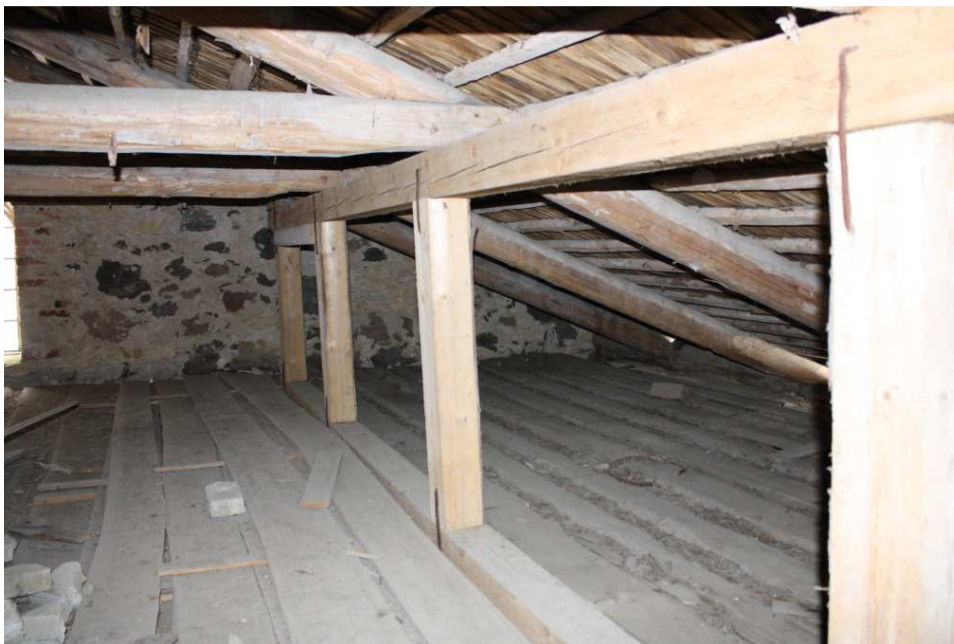
Foto 14. Ruum 10- Pööning. Toolvark ja selle kinnitused riiskadega.
