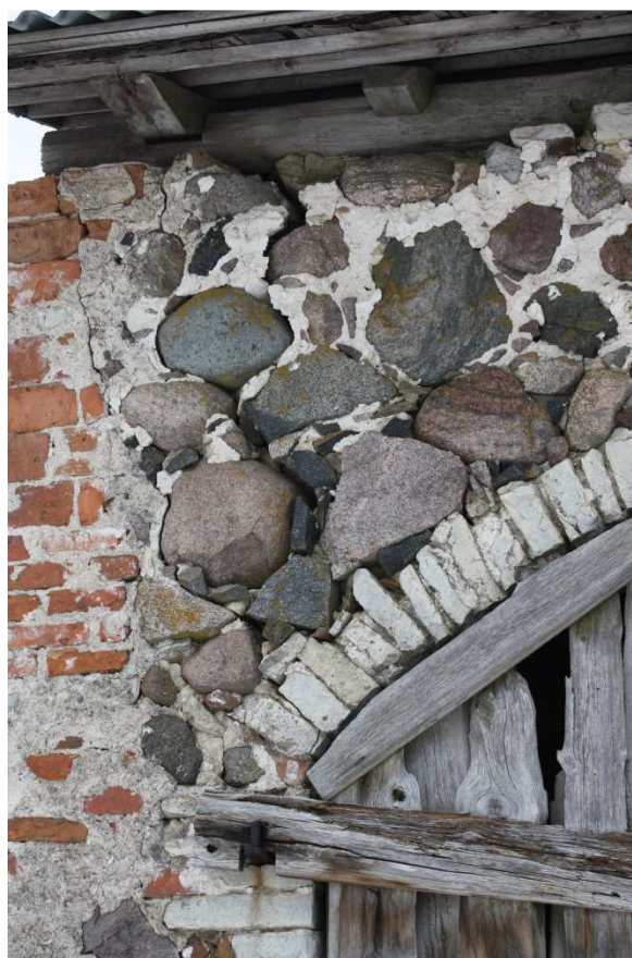
Foto 6 . Müüritise ja nurgapilastri vaheline prao kulgemine. Kõrval sillus S-1.
