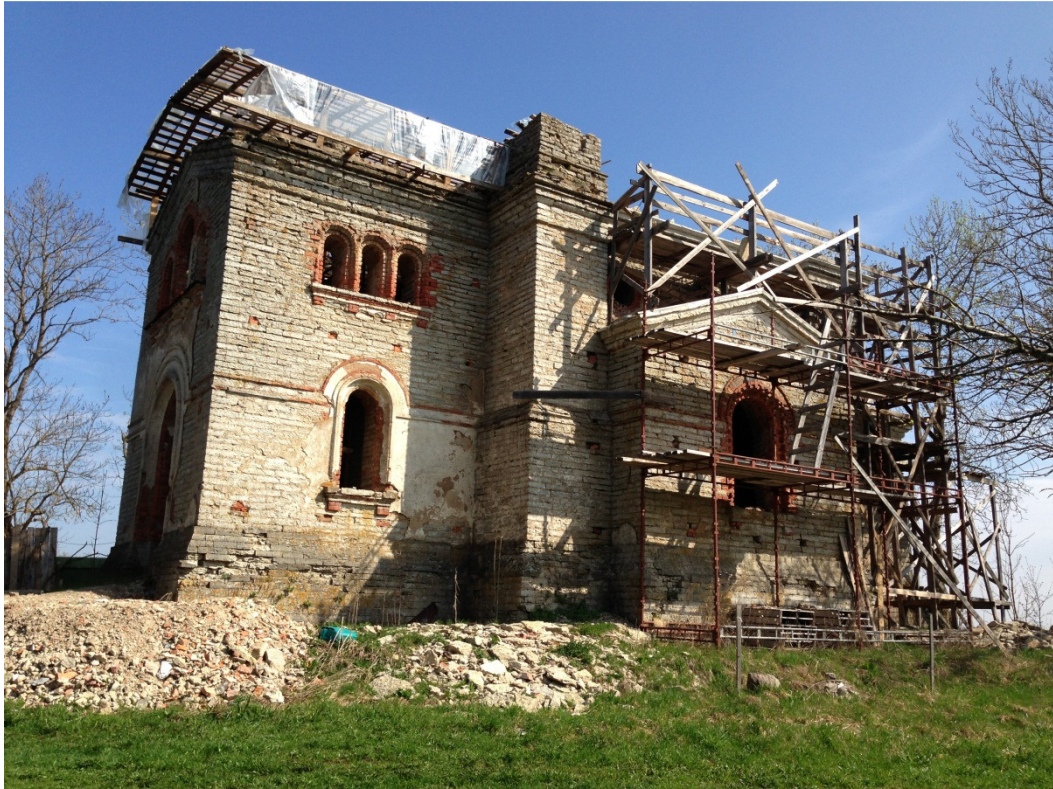
11. Vaade kirikule lõunast
