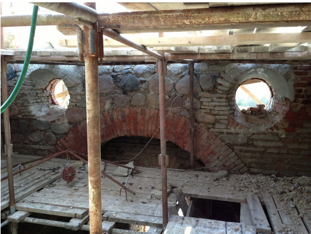
18. Pikiruumi põhjamüür ümarakendega. Aknasillused on kindlustamist betooniga.
