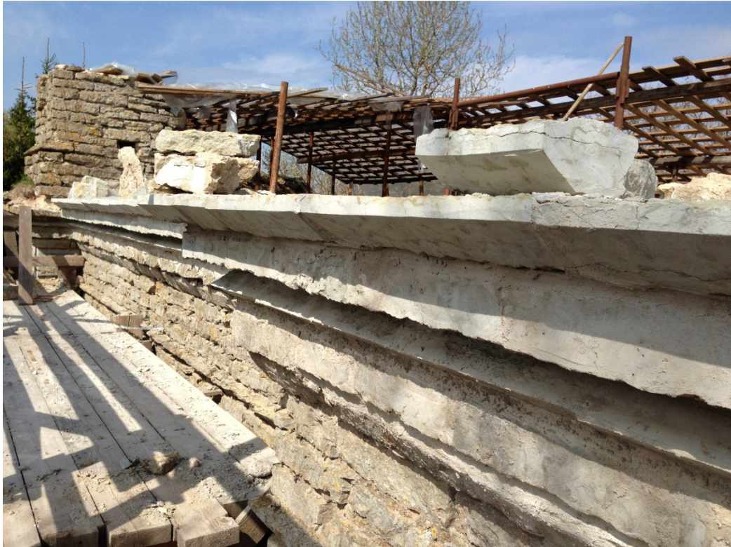
15. Pikihoone lõunamüüri taastatud karniisid. Taamal paistab üks kahest säilinud nurgatornist.
