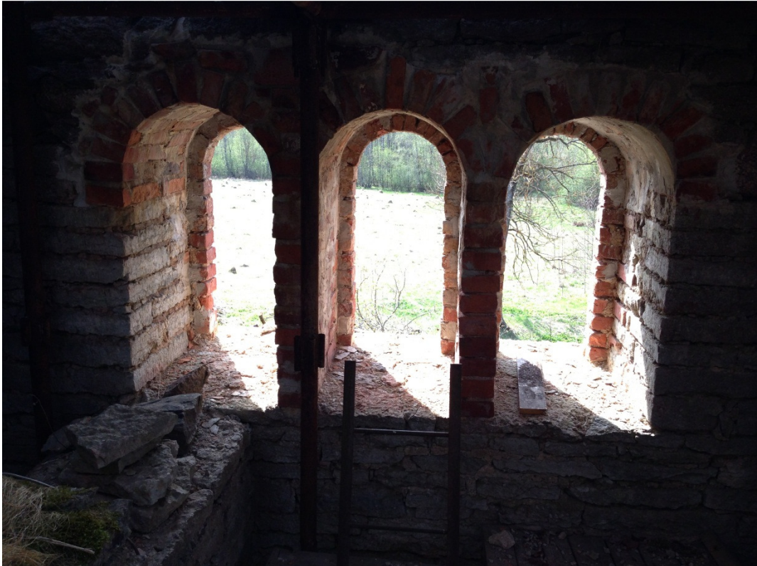
17. Taastatud kellatorni kolmikaknad lõunaküljel
