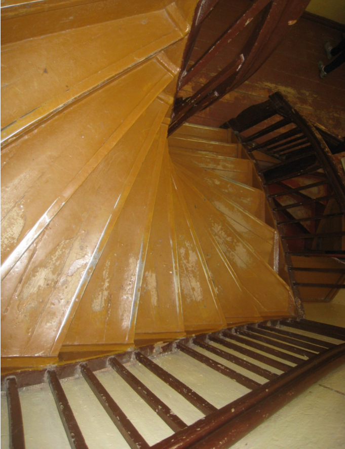
Foto 11. U- kujuline puittrepp põhikorruse ja katusekorruse vahel (autori foto)
