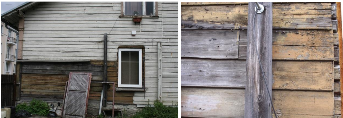
(Pilt 5; 6) Läänekülje vasak nurk- lammutatud kuuriosa vana profiillaudis. (autori foto)
