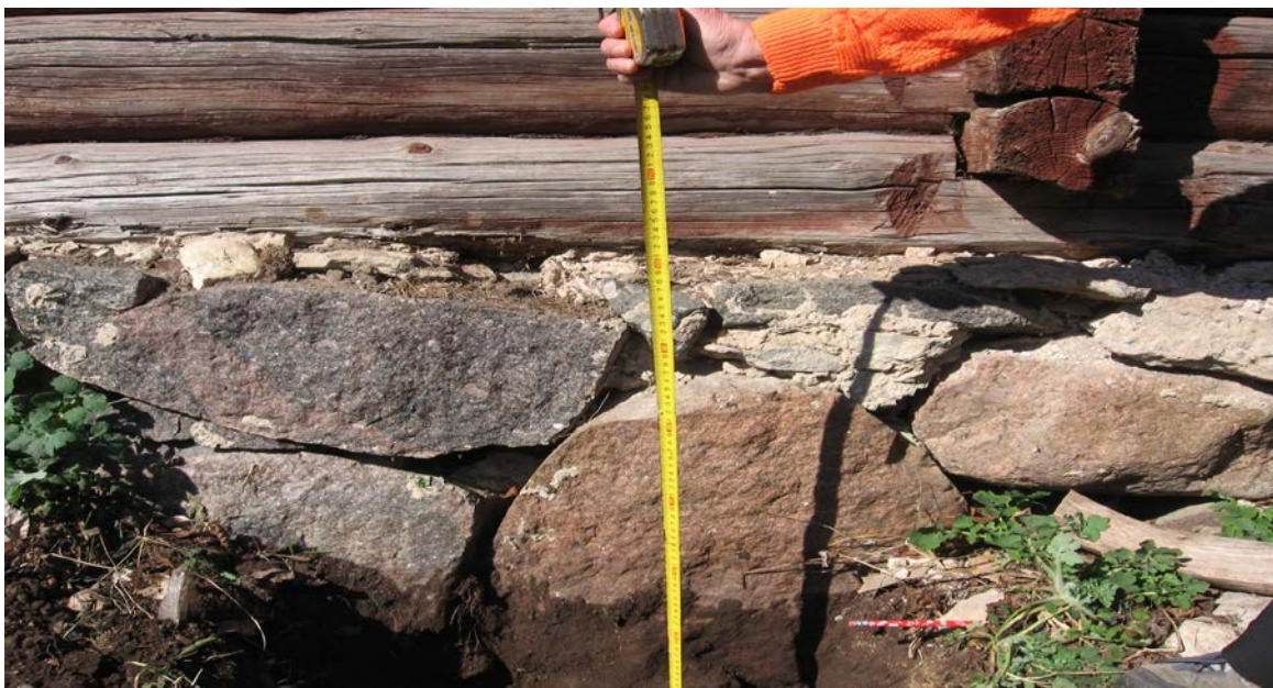
Foto 10. Vundament. (Autori foto)
