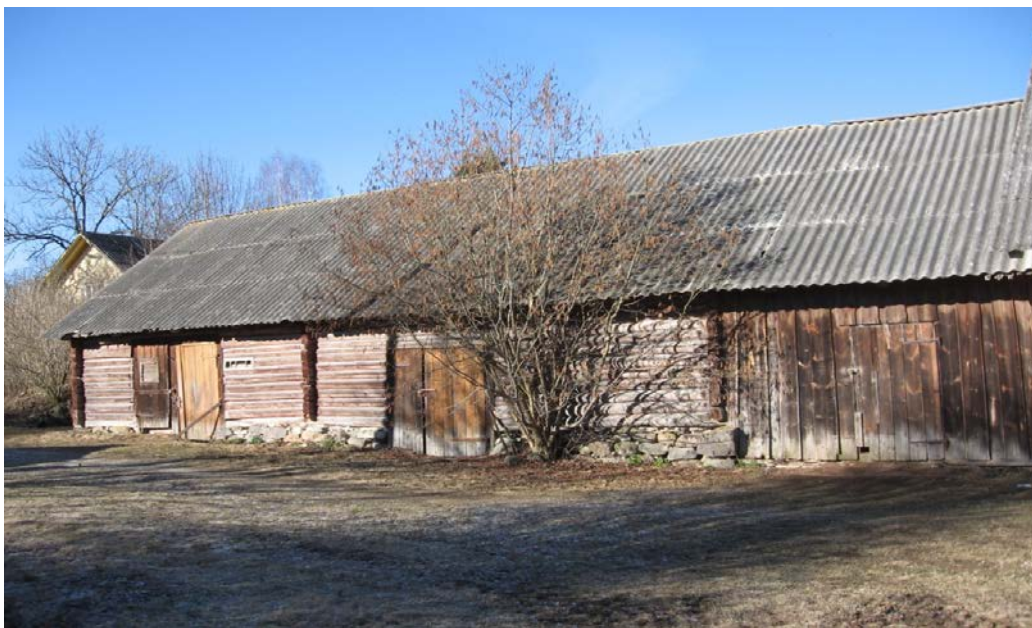
Foto 8. Tall-tõllakuur esifassaad ( Autori foto)
