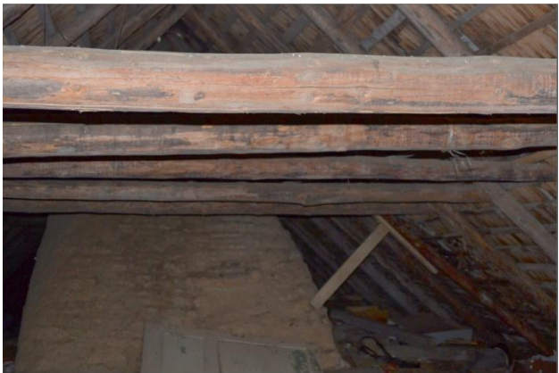
10. Mantelkorsten ja katusekonstruktsioon
