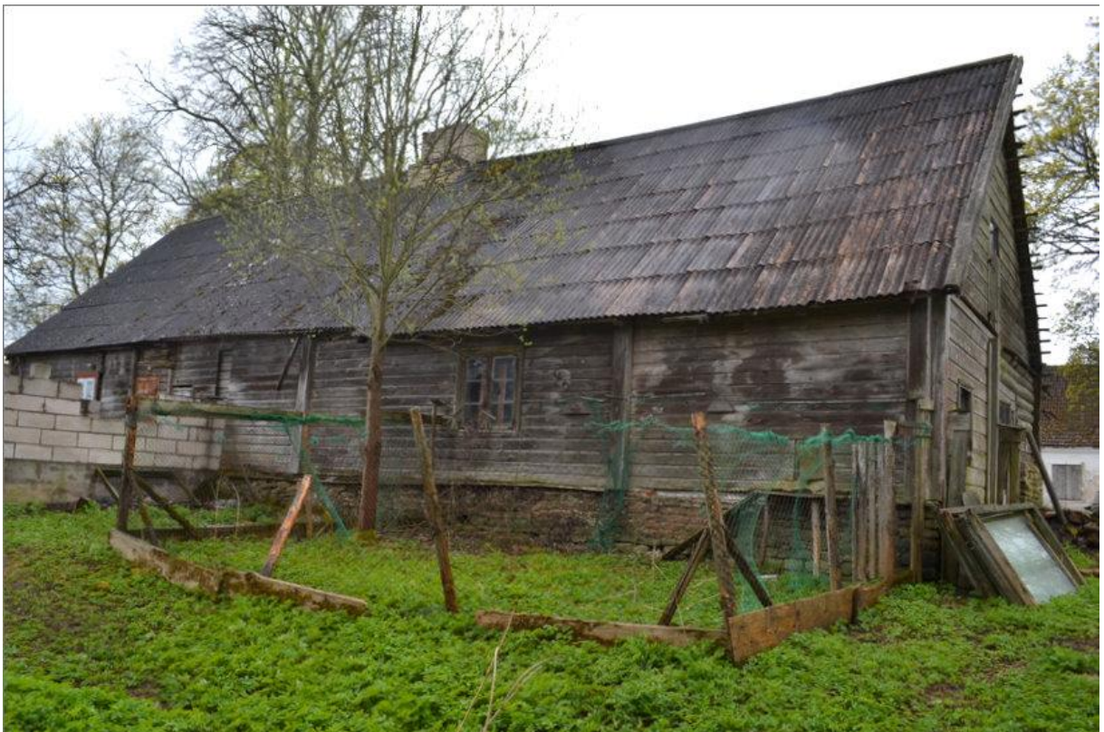
7. Hoone tagafassaad, vaade kirdest
