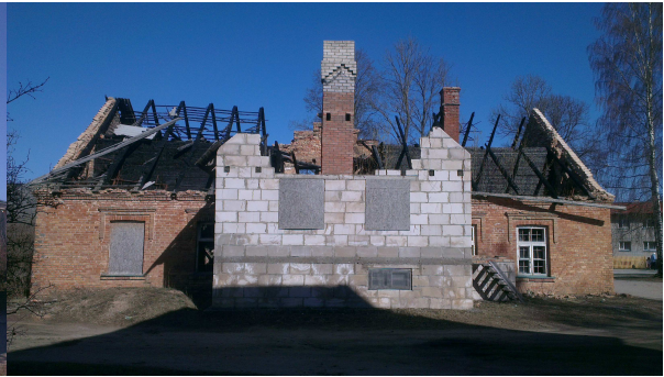
Foto nr 8. Hoone vaade lõunast.
