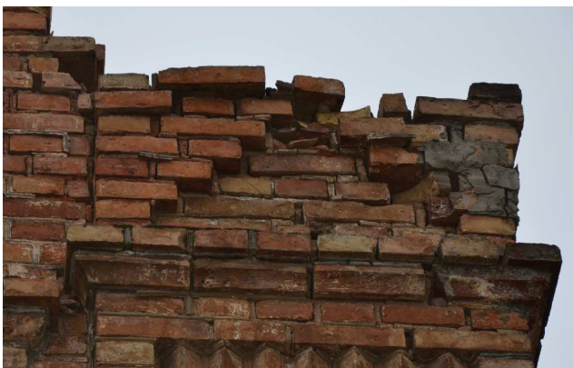
Foto nr 20. Karniis. Põhjakülg.
