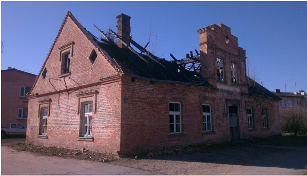
Foto nr 7. Hoone vaade kirdest.
