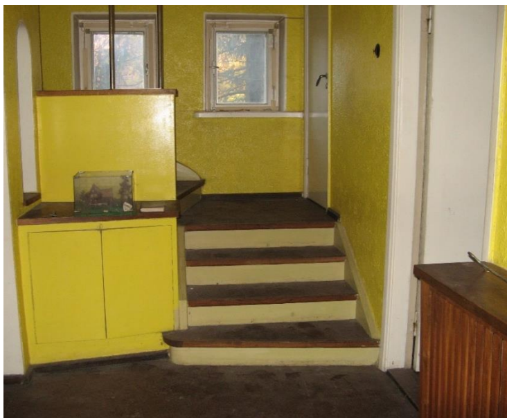
34. Sisetrepp, esiku kapp. Fotod TKVA, 2011.
