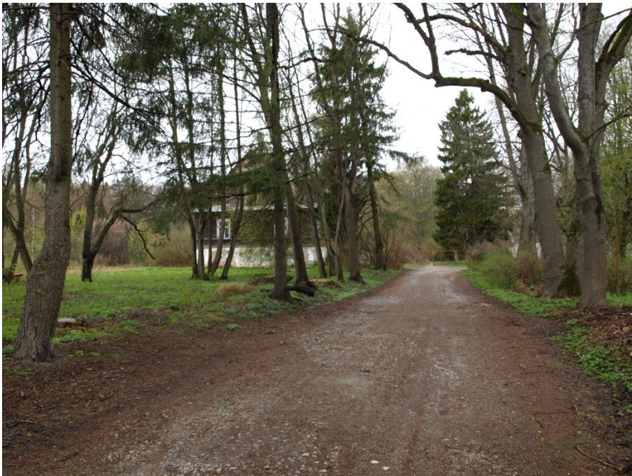
4.Foto 3. Vaade hoone ida küljele. Tehtud aastal 2014
