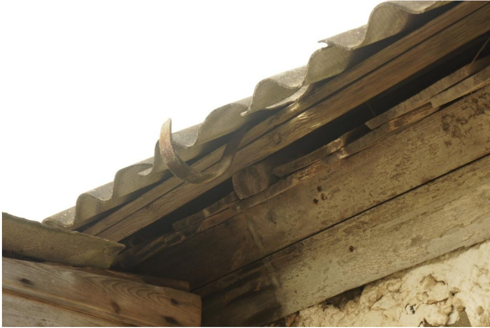
Foto 29 Põhiosa ja juurdeehituse räästa ühenduskoht ja vihmaveerenni hoidja
