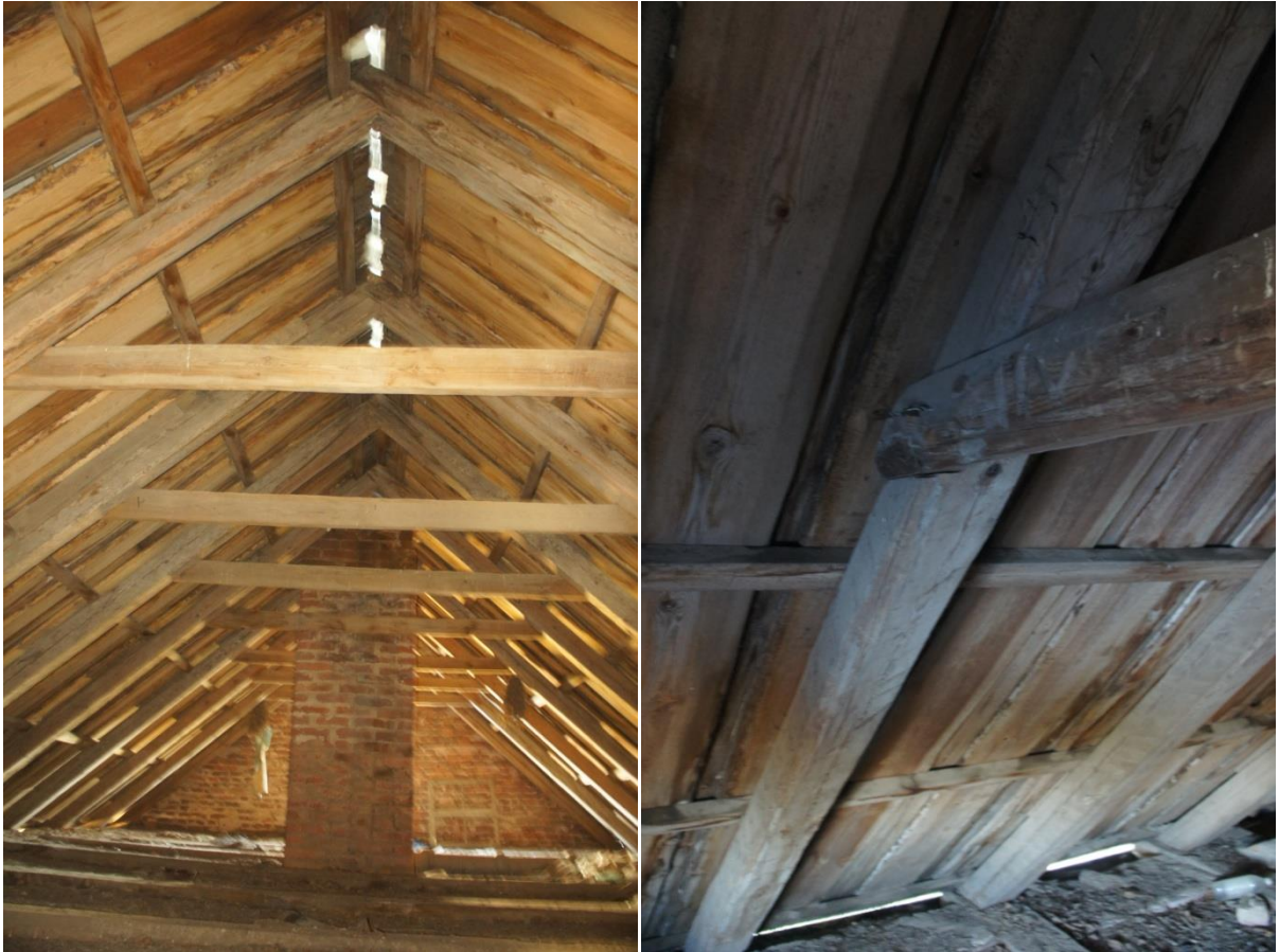
Foto 24 Põhiosa katusekonstruktsioon (laetalad, sarikad, pennid, roovid, poola laudis)
