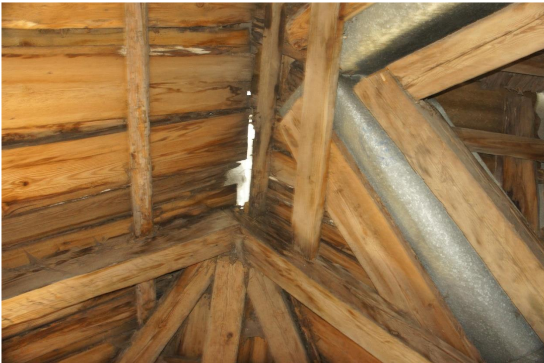
Foto 25 Põhiosa ja juurdeehituse sarikate sõlmelahendus ja neelu sisevaade.
