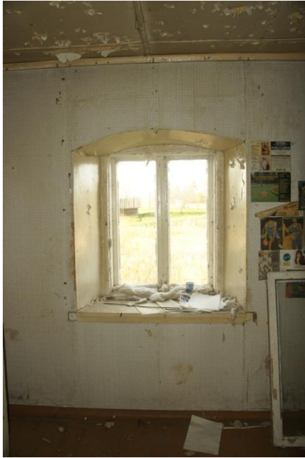
Foto 38 Ruumide lagi on kaetud vineeriga ja seinad tapeediga.
