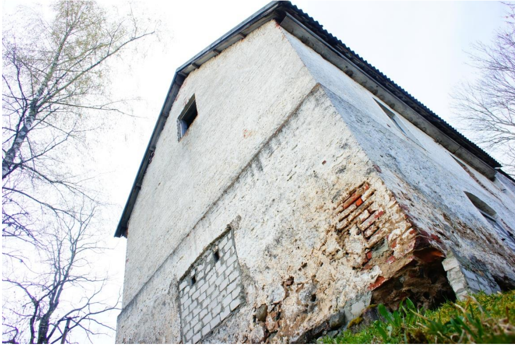
Foto 18 Valitsemaja juurehituse vundamendi ja sokliosas on tekkinud tõsine avariihohtlikkus
