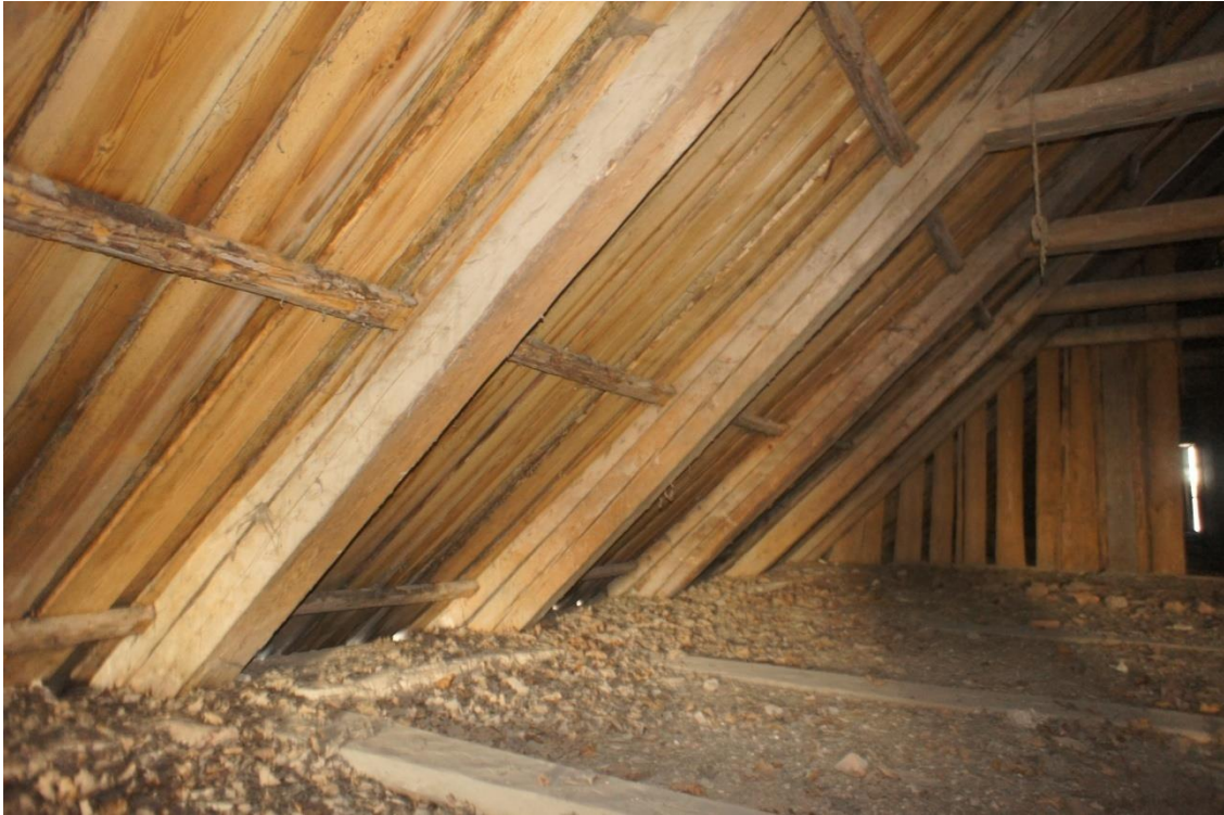
Foto 26 Tähelepanelikul vaatlusel võib märgata sarikate peal kolmnurkset lisaprussi.
