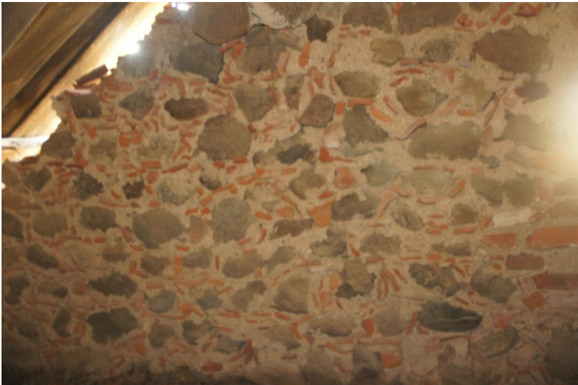
Foto 23 Põhiosa pööningu ülemise seina stiilinäide ehitusmeistri tööst ja materjali taaskasutamisest
