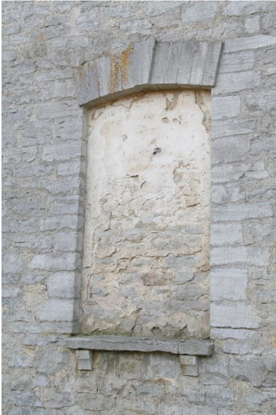
III 12. Völvitud ja lukukiviga kinnitatud silluse ning konsoolidele toetuva paekivist veelauaga petikaken.
