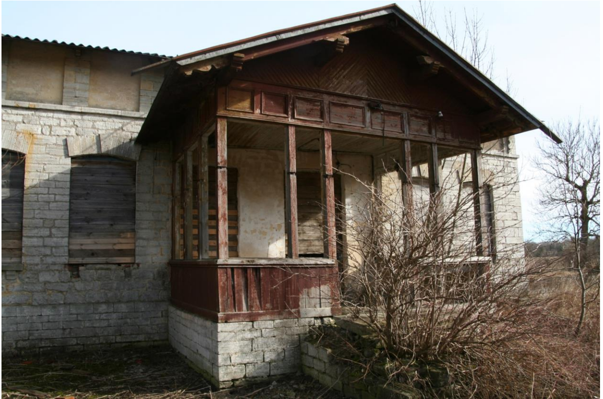
III 10. Paekivivundamendil puidust veranda.
