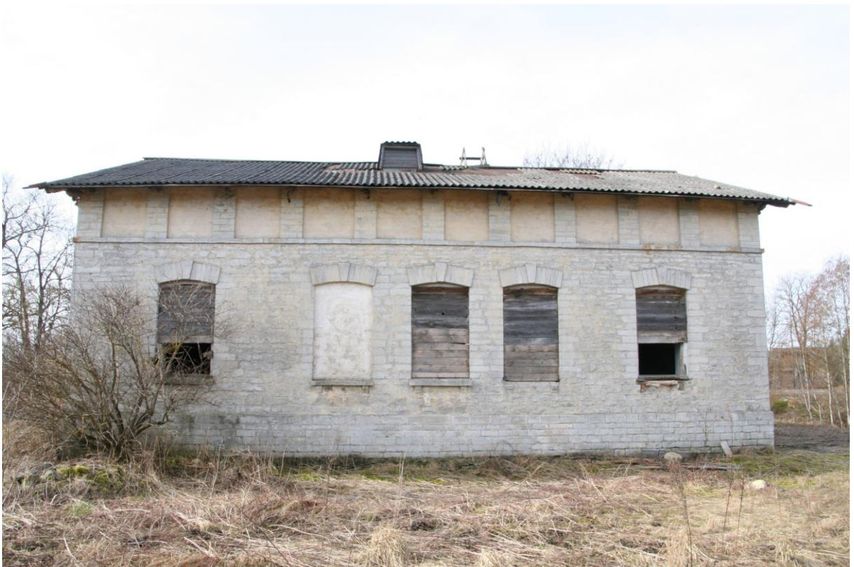
III 13. Hoone idafassaadi aknajaotus ja teise poolkorruse krohvitud tahveldised.
