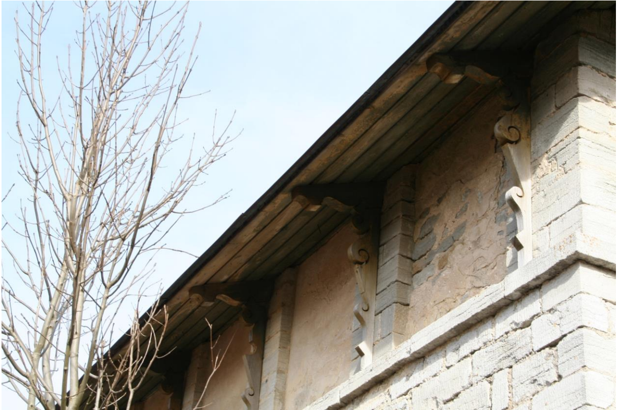
III 8. Puidust dekoratiivsed konsolid välisfassaadil.
