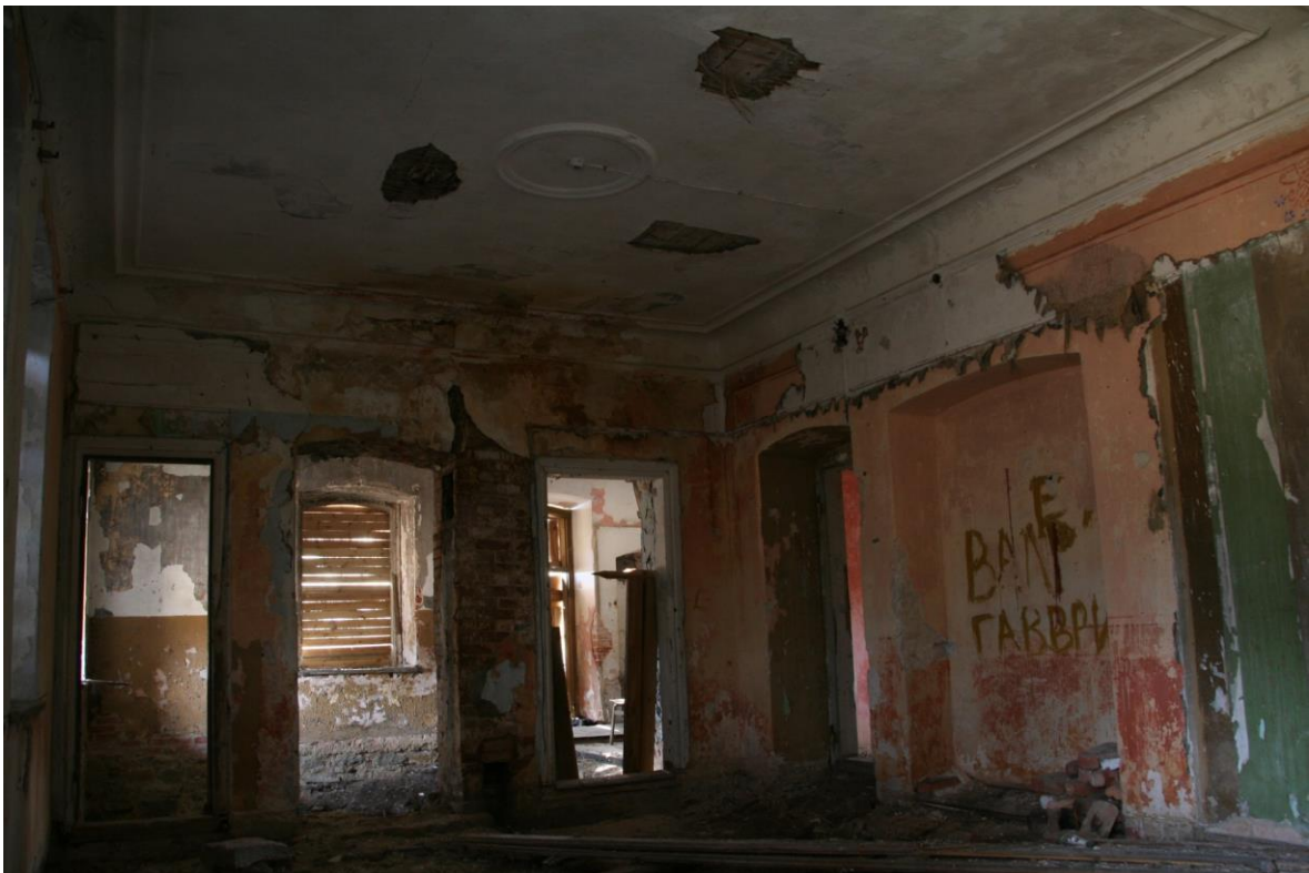
III 19. Peegelvõlvitud ja tagasihoidliku stukkdekooriga kaunistatud lagi ruumis nr 3.
