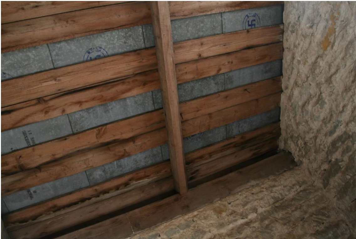
Ill 6. Katusekattematerjalina on kasutatud Inglismaal Brand Swastika kaubamärgi all toodetud tsingitud raudplekki.
