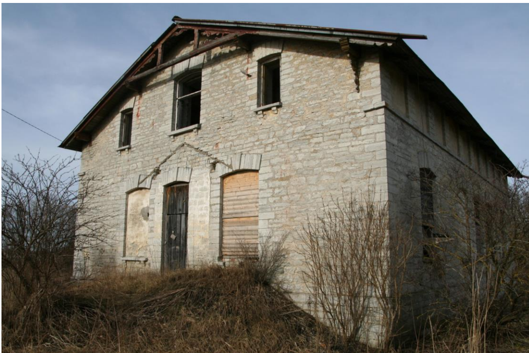
III 11. Hoone lõunakülg viitab ukse kohal olnud varikatusele või väikesele verandale.
