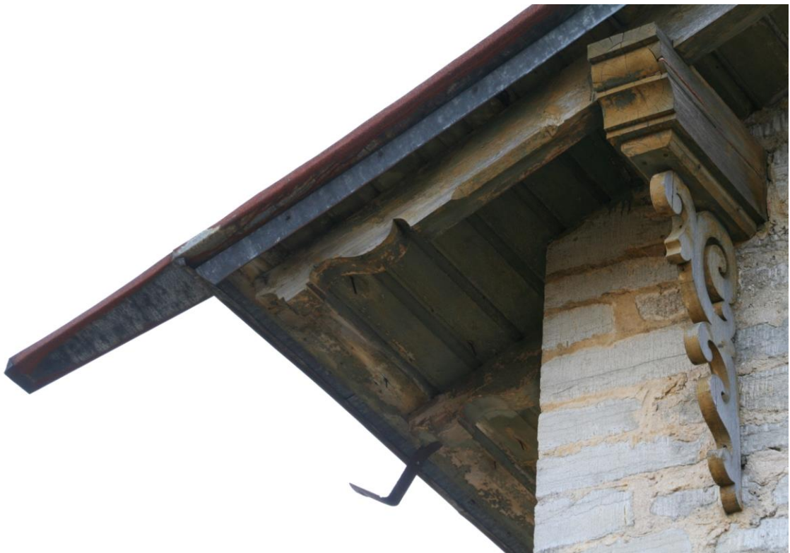
III 9. Sarikate tahatud otsad, laetalade konsool otsaviilul ning detailid säilinud vihmavee ärajuhtimise süsteemist.
