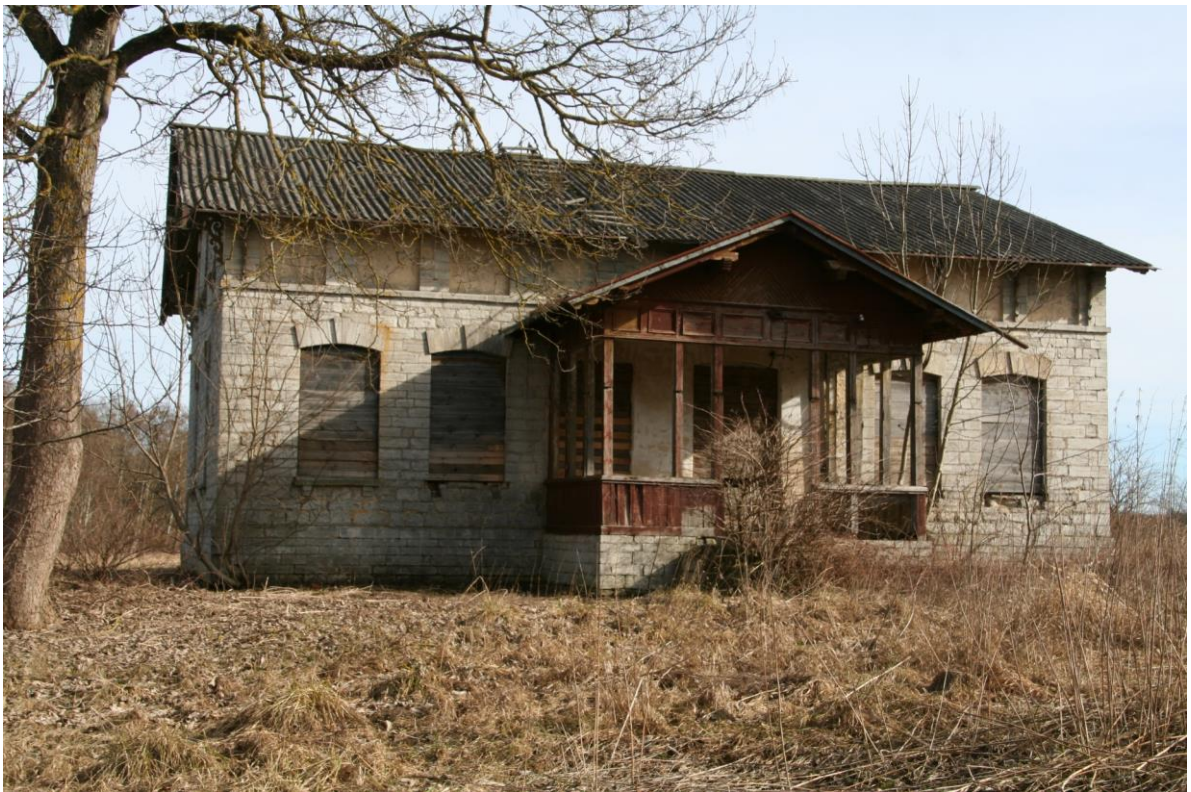
Ill 5. Hoone teise poolkorruse fassaadi ilmestab horisontaalne rida lubikrohvitud tahveldisi.
