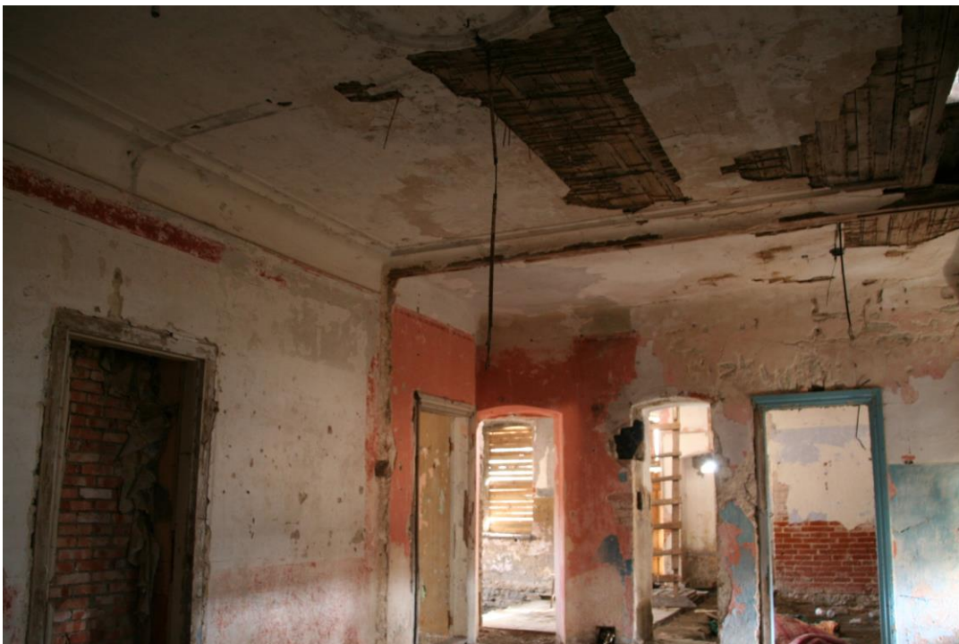
Ill 17. Ruumid nr 1 ja nr 2 on vaheseina lammutamise läbi ühendatud. Ruumis nr 2 on näha olemasolevate seinaviimistluskihtide alt kumamas punakat tooni originaalviimistlust. Nišš vasakus seinas on olnud tõenäoliselt seinakapp.
