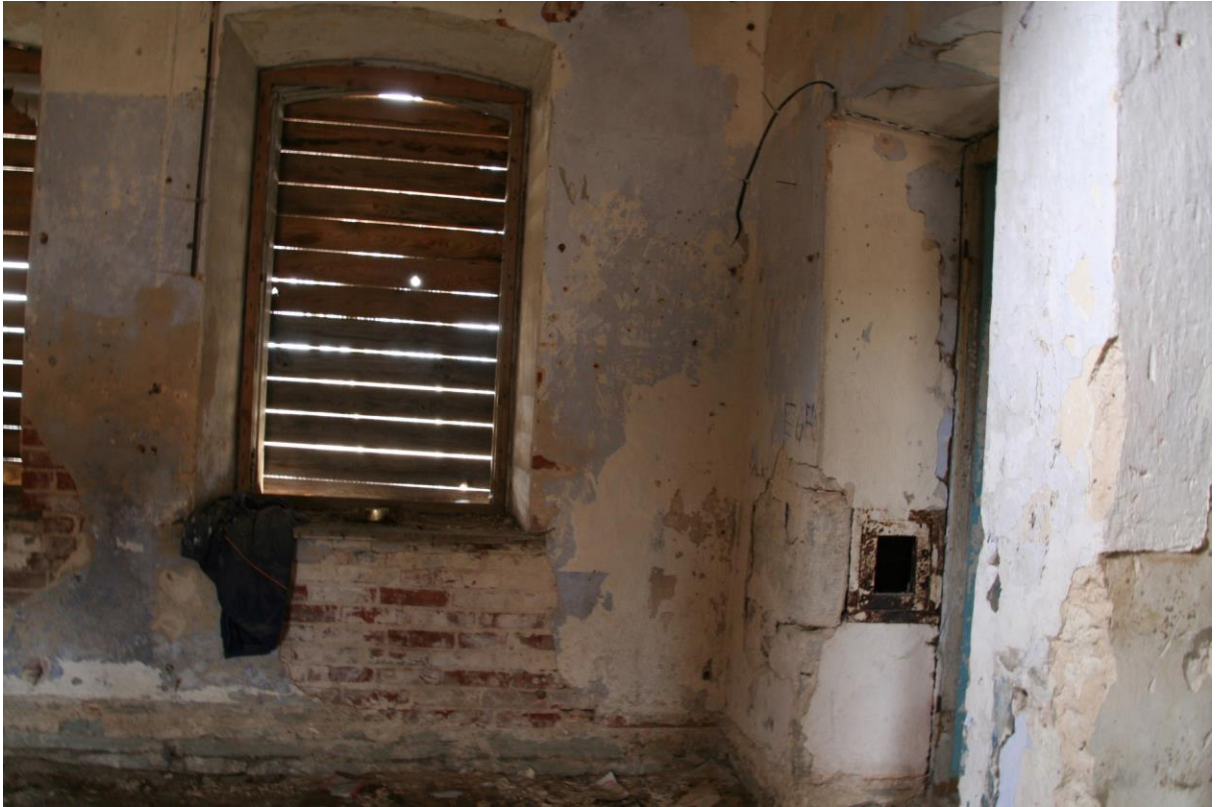
III 22. Ruum nr 5, ukse kõrval on seina sisse müüritud metallist kapp.
