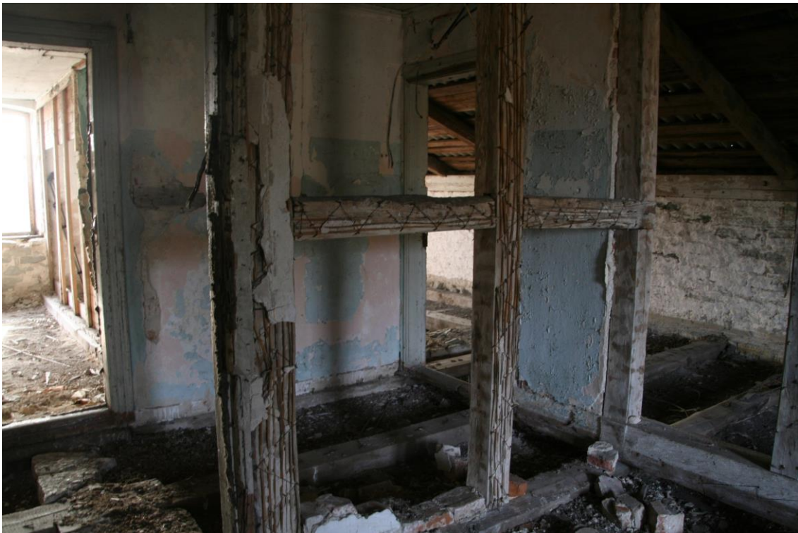
III 27. Hõreda pilliroomatiga kaetud vaheseinte puitsõrestik II korrusel.
