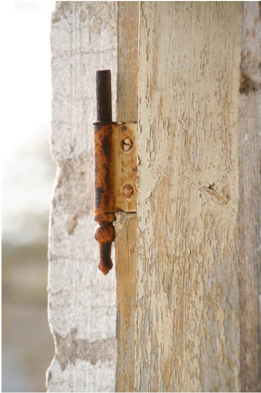
III 14. Originaalne poolik aknahing.
