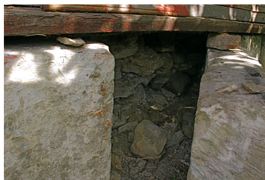
18. Vasakul: tsementkrohviga krohvitud vundament hoone loodeküljel.
