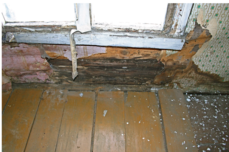
58. Mädanikkahjustustega tänavapoolne sein interjööriist vaadatuna.
