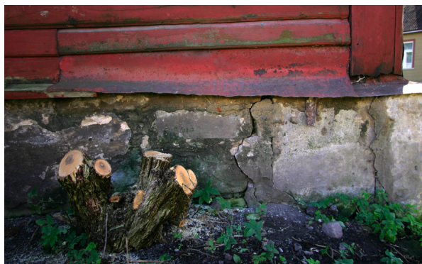
18. Vasakul: tsementkrohviga krohvitud vundament hoone loodeküljel.
