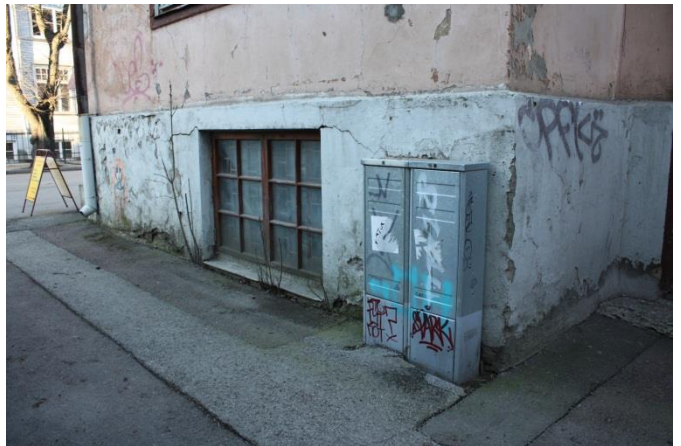
Illustratsioon 9. Vaated Raua tn 18 sisehoovile soklikorruse uksega; Põhjapoolsele nurgale, kus taustaks Raua tn 20 hoone ja vaade edelafassaadi väljaastele mõranenud soklikorruse akna sillusega. veebruar 2014. Fotod: Märt Maripuu
