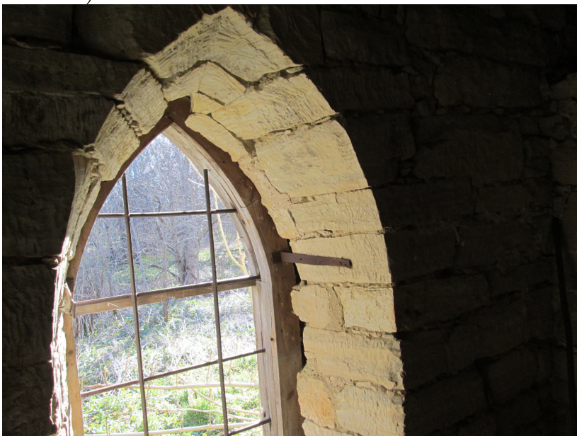
Joonis 16. Raidkivist aknapõsed ja osaliselt säilinud akna puitraam (autori foto 2014)
