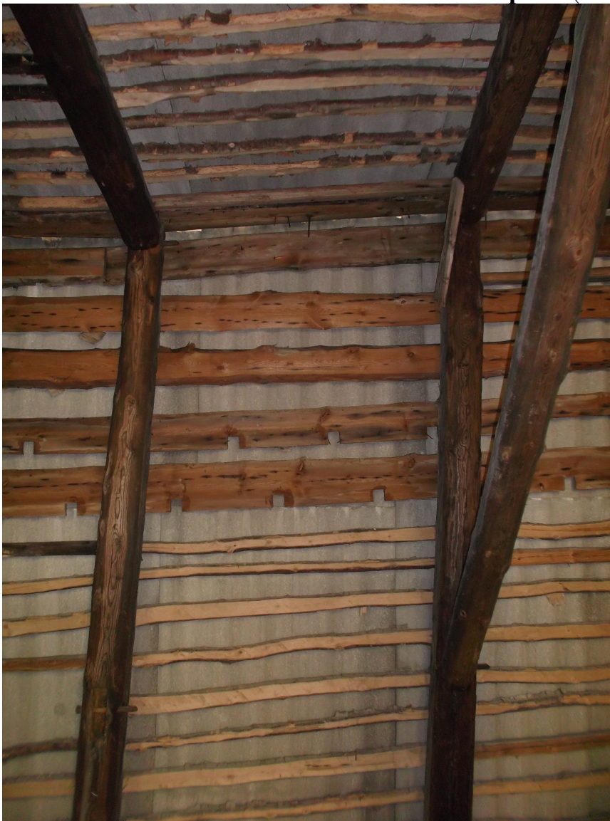
Joonis 19. Katuse kandekonstruktsioon seestpoolt (autori foto 2014)
