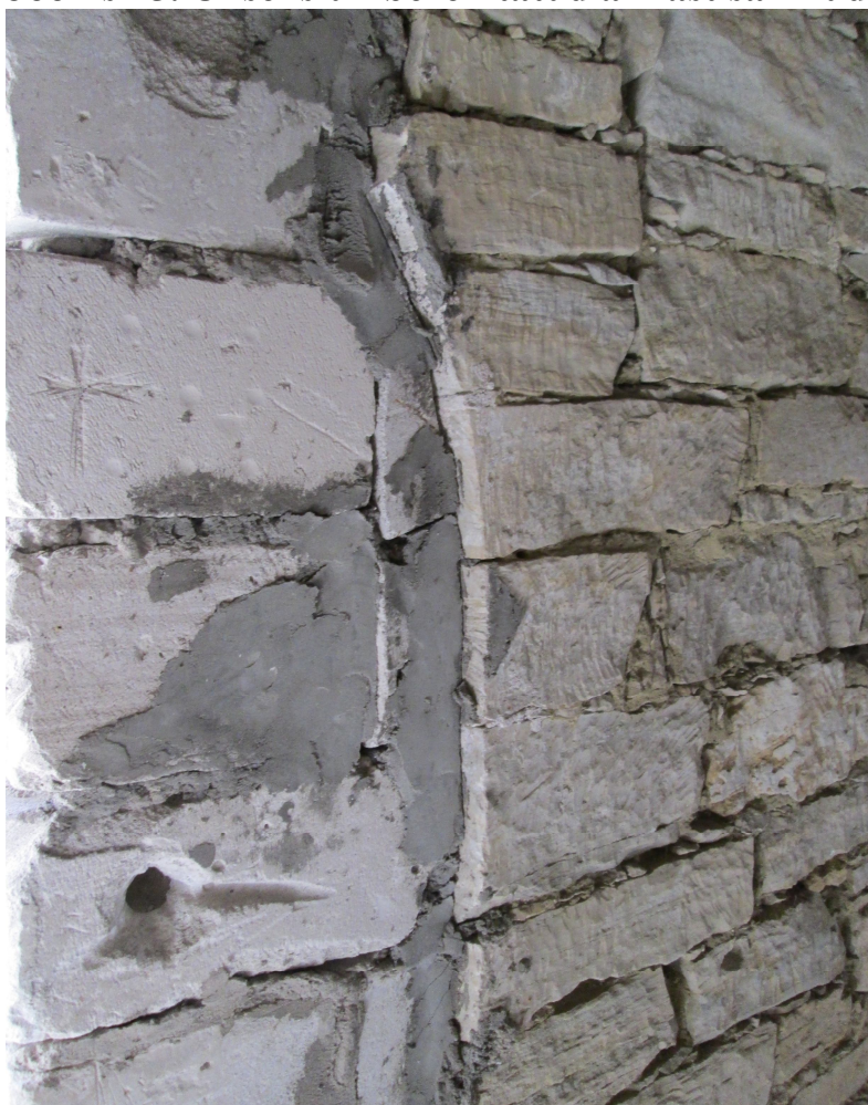
Joonis 15. Ukseks ümberehitatud aknast säilinud põseserv. (autori foto 2014)
