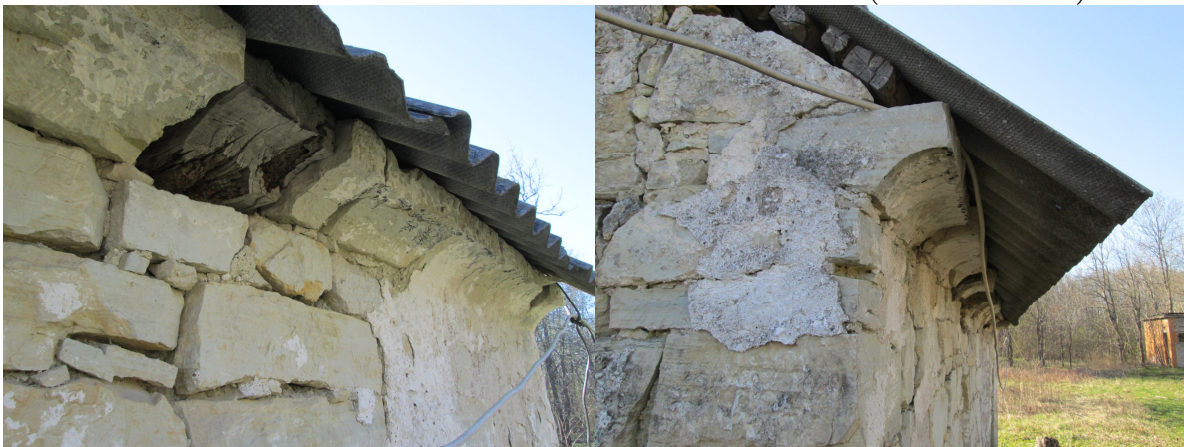
Joonis 18. Kumeraks tahatud kividest räästakarniisid (autori foto 2014)
