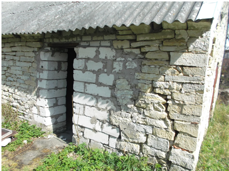
Joonis 14. 1970-ndate aastate ümberehitus aknast ukseks (autori foto 2014)
