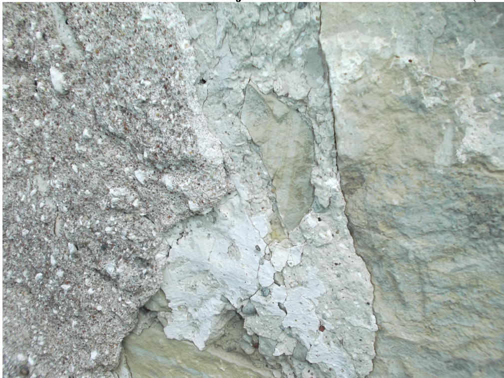
Joonis 10. Seintel on säilinud jäänused kahest krohvikihist (autori foto 2014)
