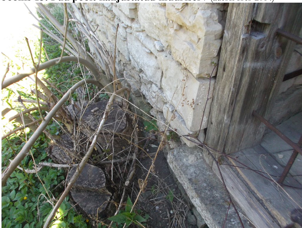
Joonis 13. Puu poolt kahjustatud müüriserv (autori foto 2014)
