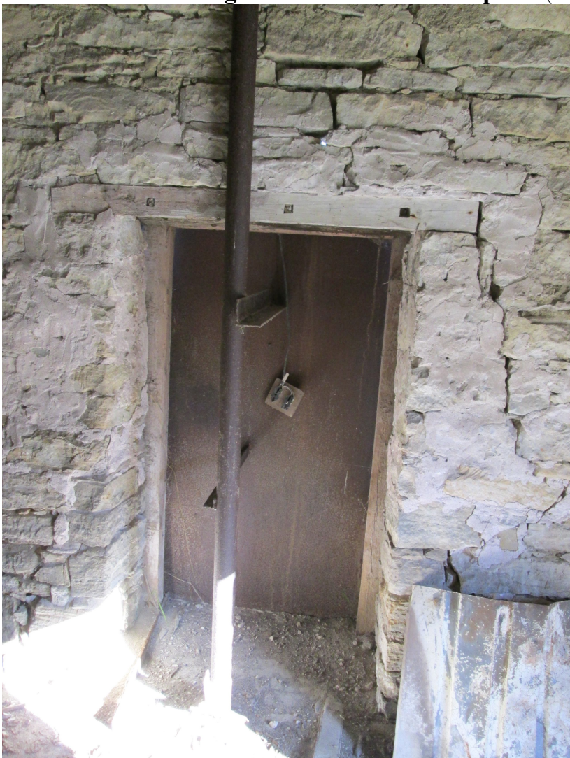
Joonis 17. Vaade kaguseina ukseavale seestpoolt (autori foto 2014)
