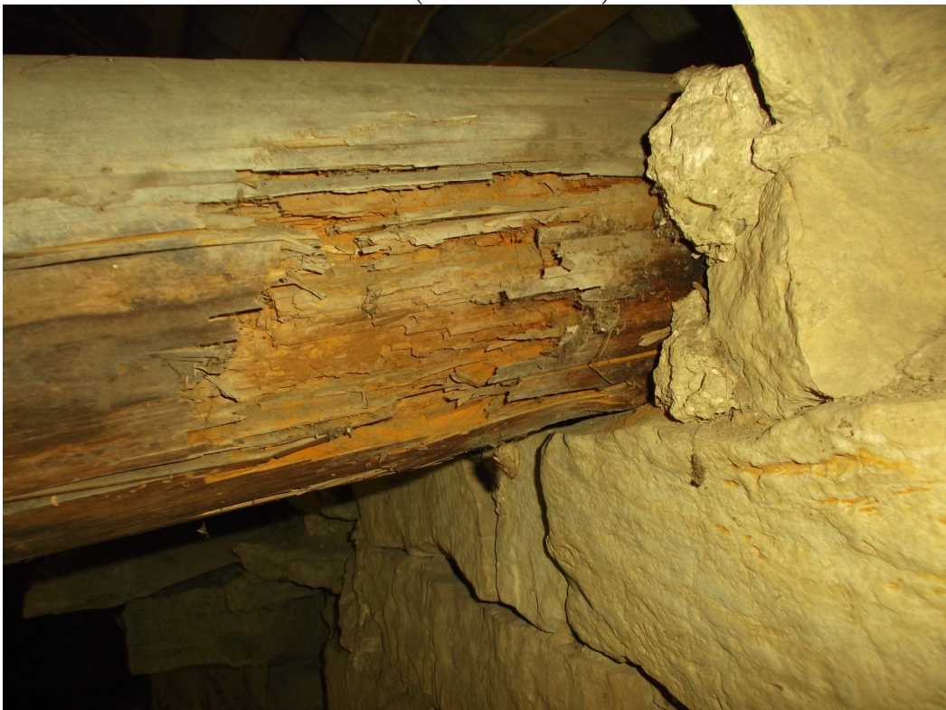
Joonis 20. Pehkinud talaots. (autori foto 2014)
