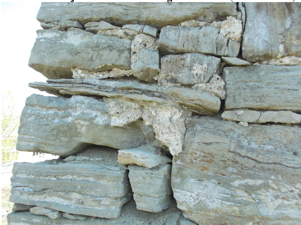
Joonis 11. Tühjaksuhitud vuukidega torninurk (autori foto 2014)
