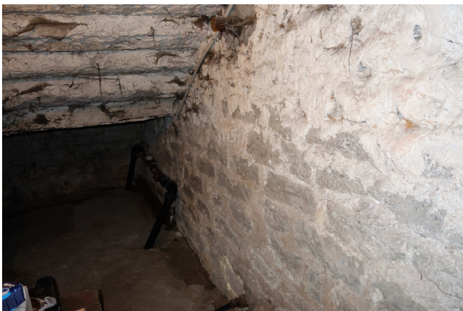
Pilt nr 6. Murtud paekivist vundamendi müüritis. Allikas: A-L.Lindeberg, aprill 2014.
