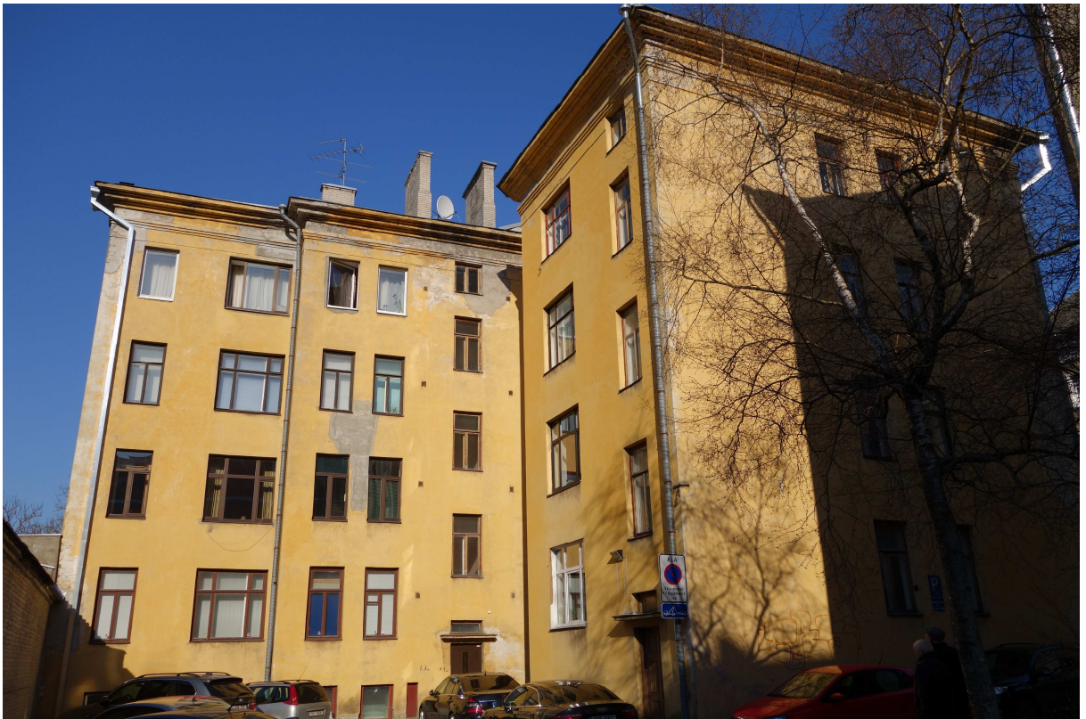
Pilt nr 8. Vaade peafassaadi terrasiitkrohvide ja sisehoovi lubikrohvide. Allikas: A-L. Lindeberg, aprill 2014.
