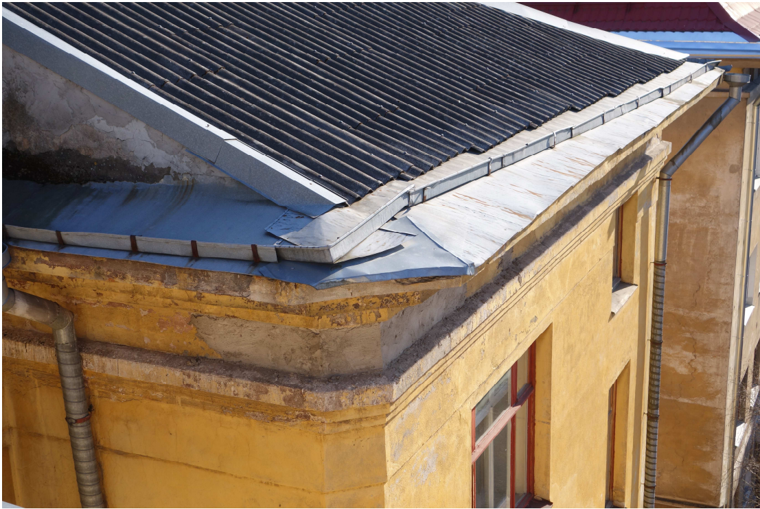
Lisa nr 7. Vaade katusele ja korstnatele (allikas: A-L.Lindeberg, aprill 2014).
