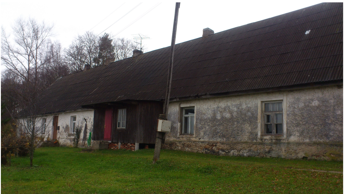
Foto 42. Vaade juurdeehitusele hoone edelafassaadil (2014)
