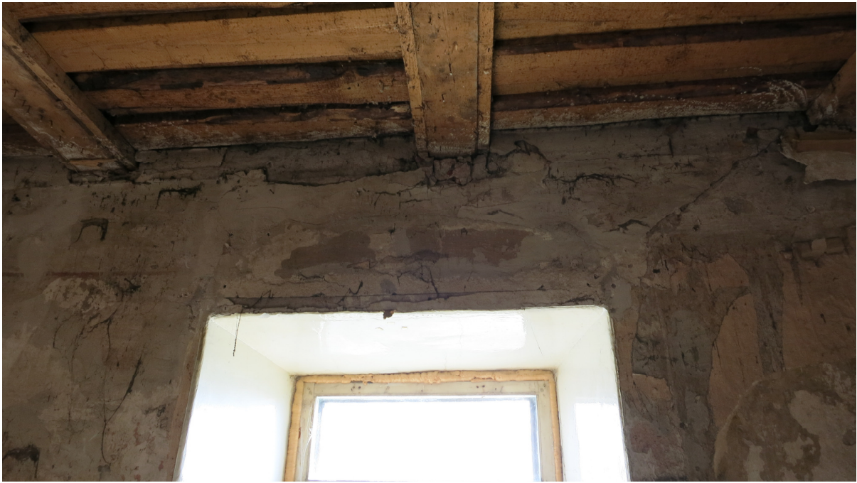
Foto 28. Korteris 4 seestpoolt kinnimüüritud kaares aknaava (2014)
