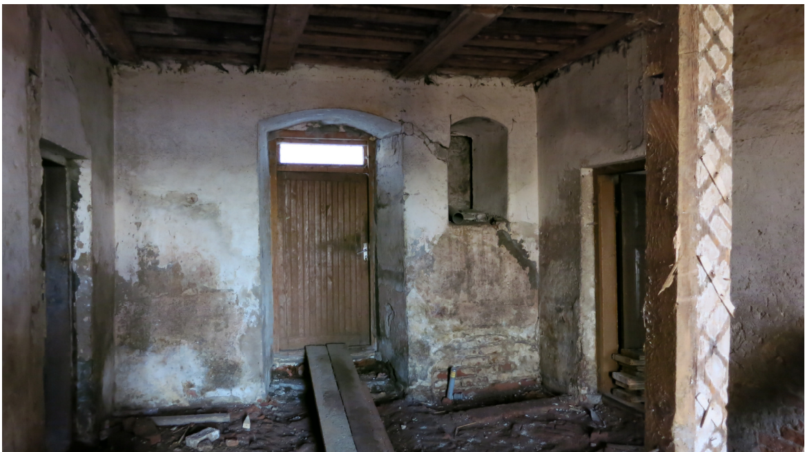
Foto 20. Vaade korterite 4 ja 5 välisuksele. Paremalt näha kinnimüüritud aken, praod ja hiljuti majja toodud veetoru (2014)
