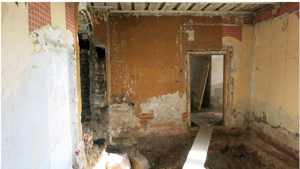
Foto 29. Vaade korteri 3 köögi uksele peale välja puhastamist, vasakul nišis on näha välja tulnud trafarettmaalingud (2014)
