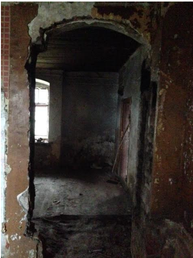
Foto 31. Korteris 3 ja 5 köökide vahelise nõukogude aegse ahju väljalõhkumisel välja tulnud endine ahjukaar (A. Teder, 2014)
