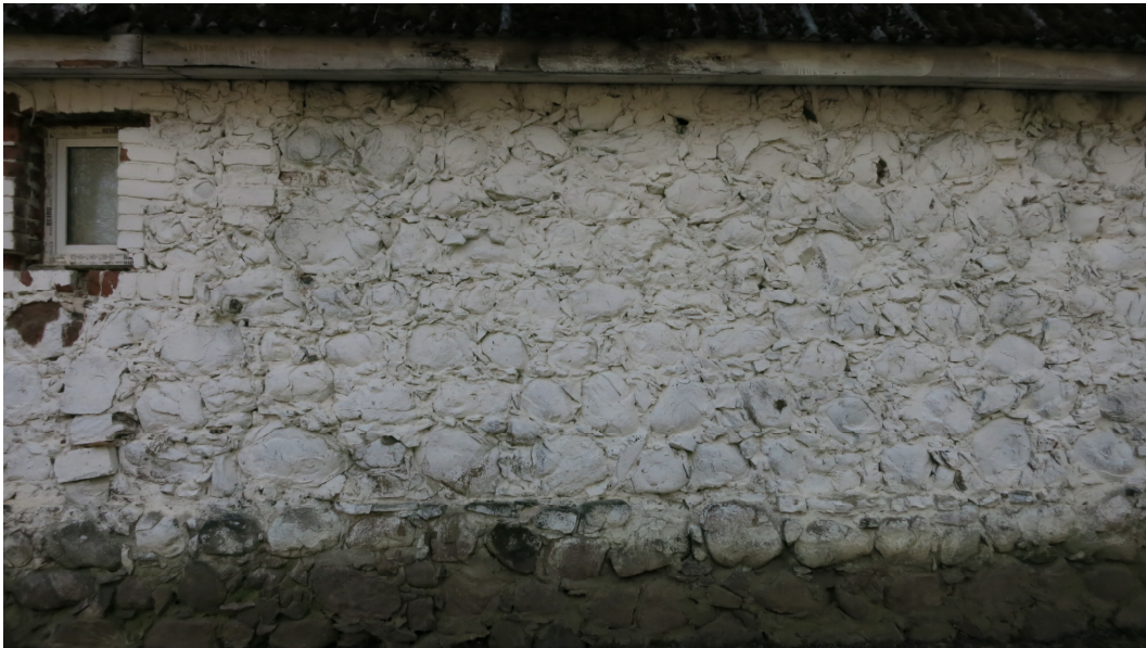
Foto 43. Vaade välisseinale hoone kirdefassaadil (2014)
