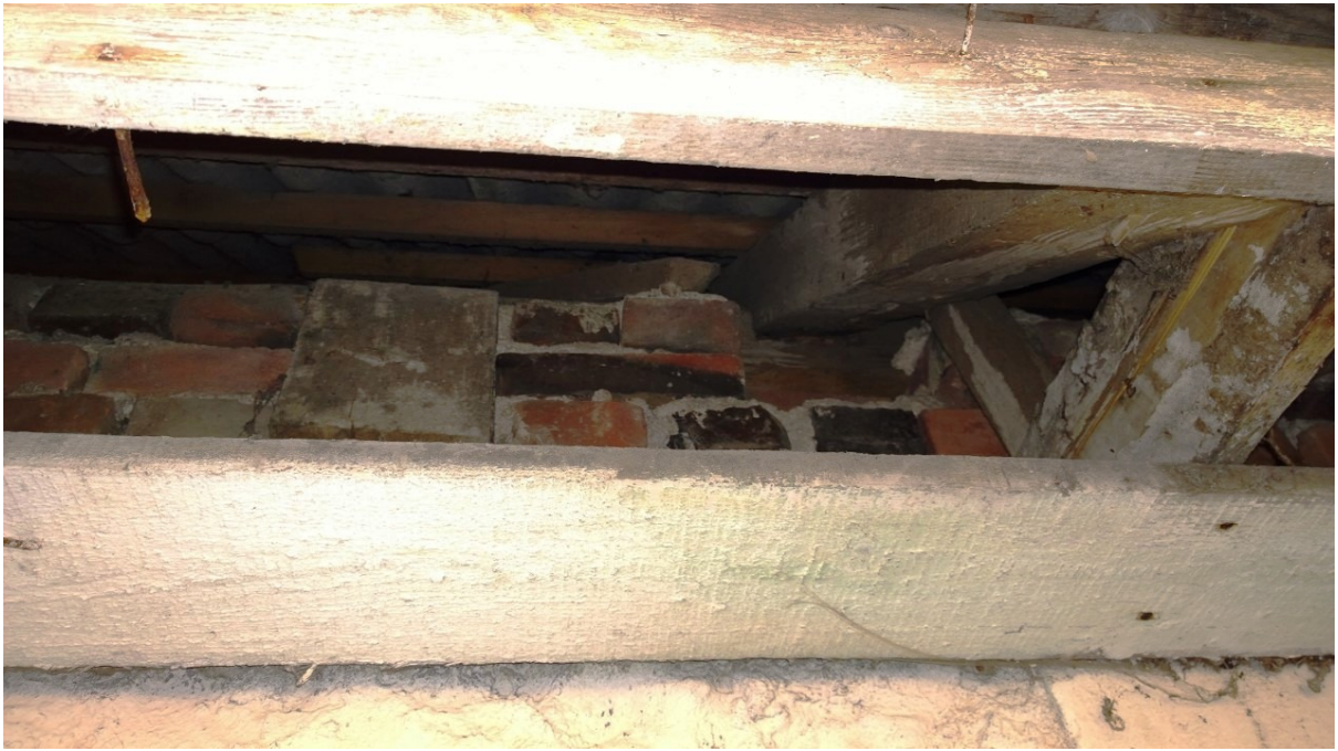
Foto 38. Vaade müürlatile ja sarikatele tuulekasti vahelt kirdefassaadil. (2014)
