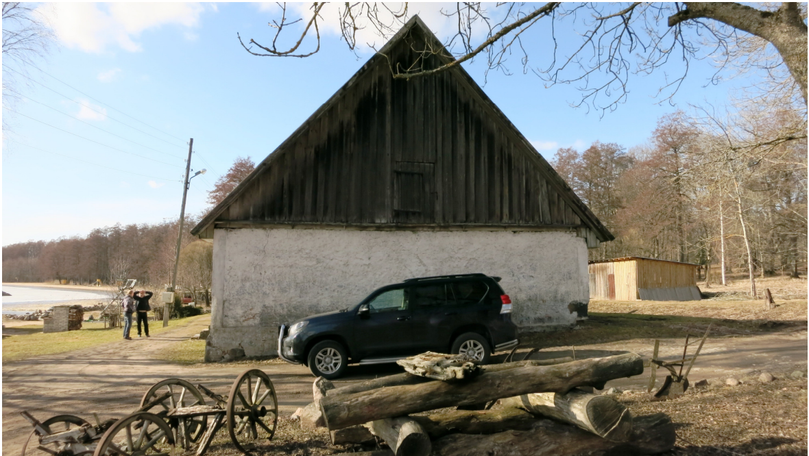
Foto 8. Vaade otsaseinale kagust (2014)
