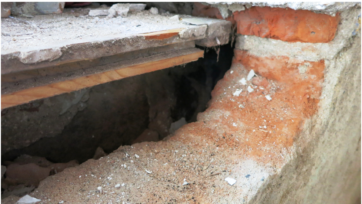
Foto 33. Korteri 3 aknalaua alt paistev õhuvahega topelt tellissein (2014)
