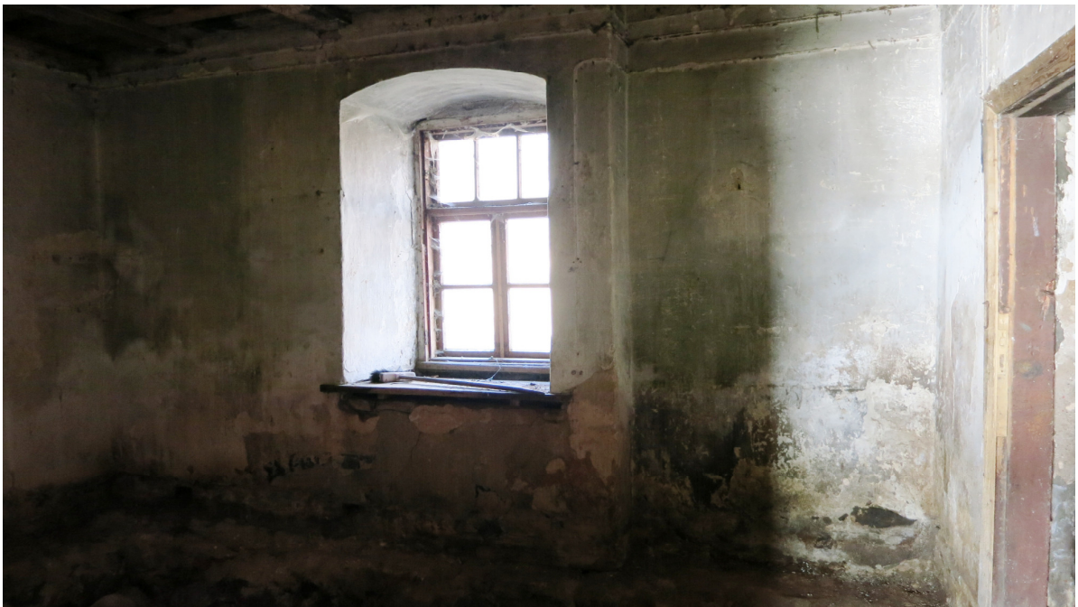
Foto 27. Vaade korteri 5 toale, paremal on läbi krohvi näha kinnimüüritud väike ümarkaarega aknaava (2014)
