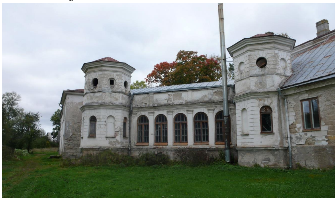
6. Sama vaade talveiaale ja tornidele septembris 2012.a.
