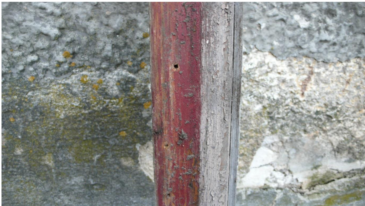
21. Algse värviga aken talveaia põhjaküljelt (aken oli ventilatsiooni jaoks kaetud puitraamis võrguga, mistõttu seda hilisemal ajal üle ei värvitud).
