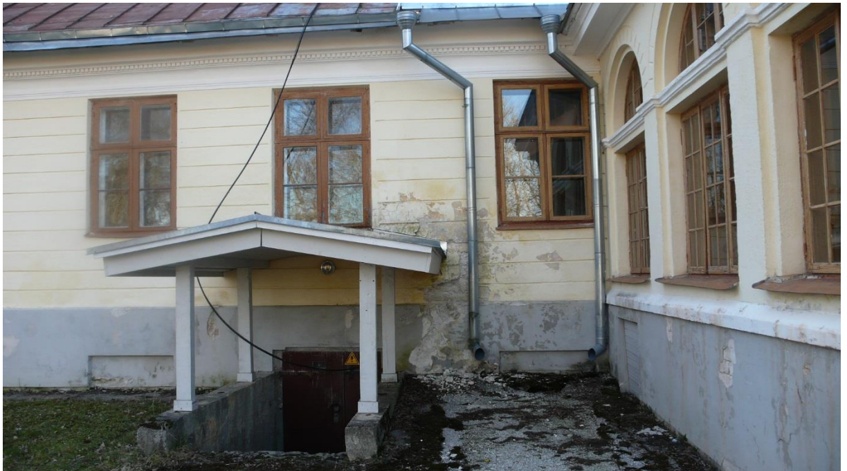
11. Peahoone esiküljel asuv sobimatu varikatus. Varikatuselt pritsinud vihmavesi on kahjustanud seina.
