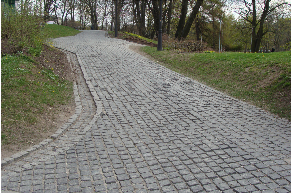
Foto 40 2011 aastal rekonstrueeritud kõnnitee koos sademevee ärajuhtimise renniga
