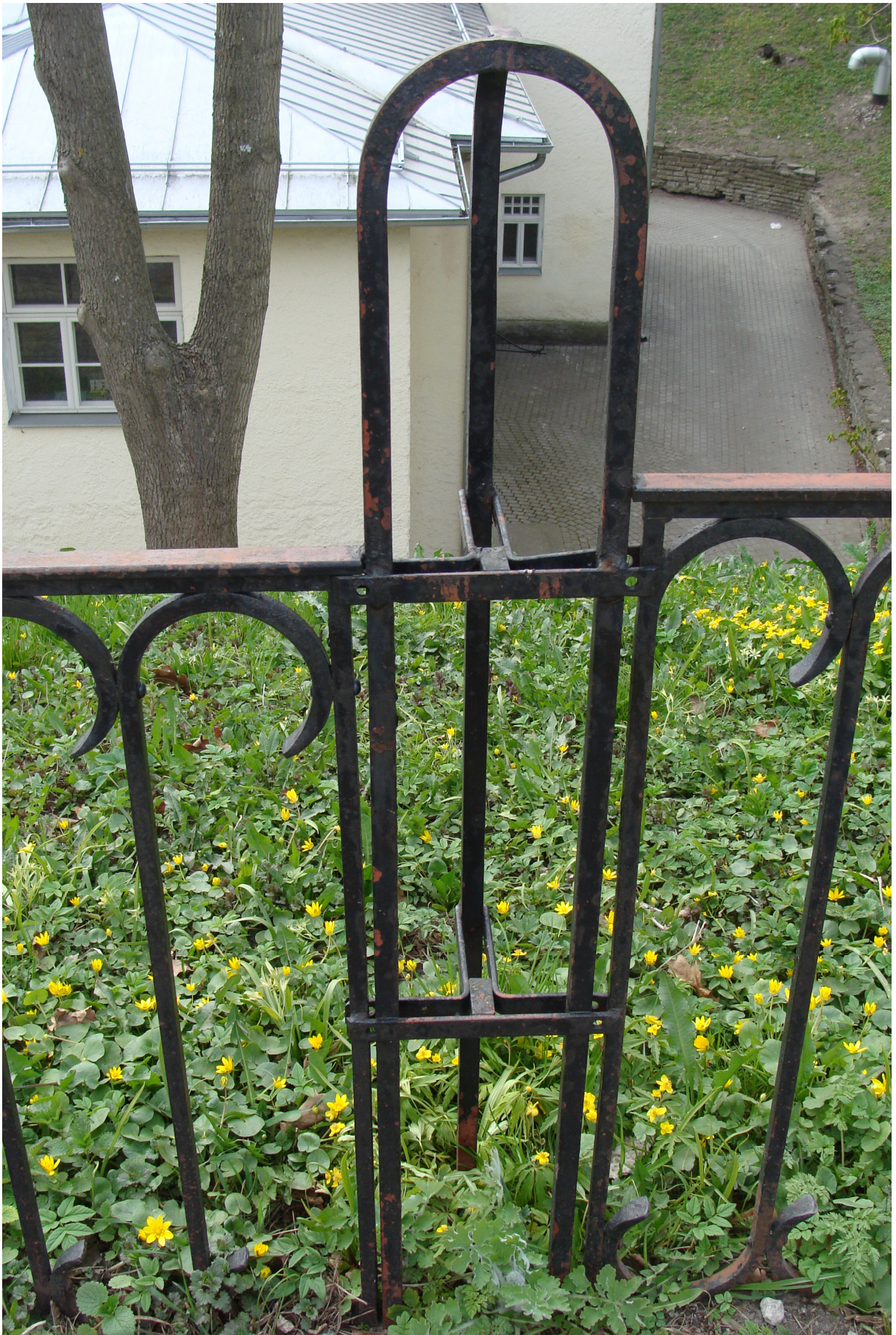
Foto 32 Eskarpmüüri äärne metallist piire, mille alumine osa on pinnasesse mattunud
