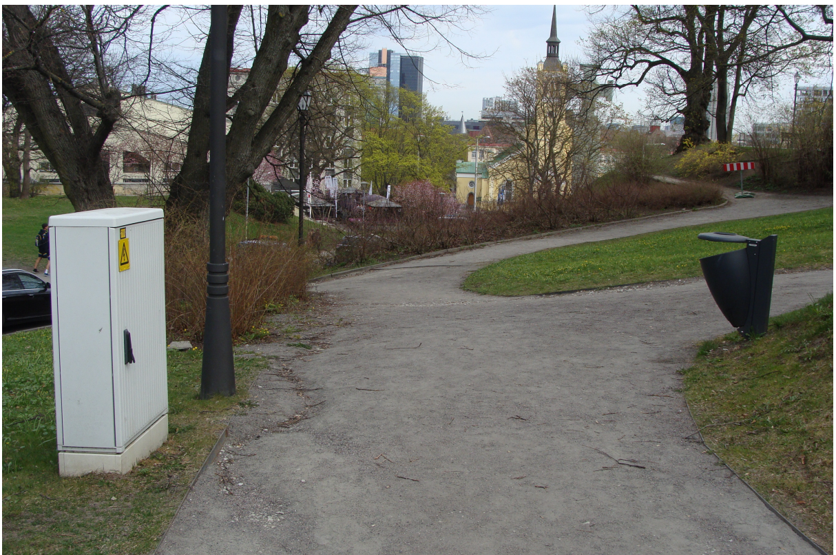
Foto 41 Sademeveest tingitud erosioon
