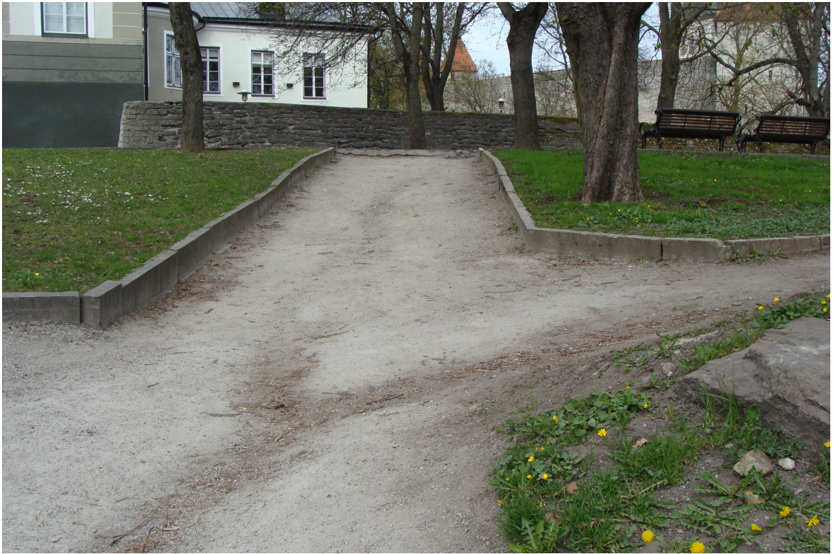
Foto 42 Sademeveest tingitud erosioon ja uue katendi vajadus
