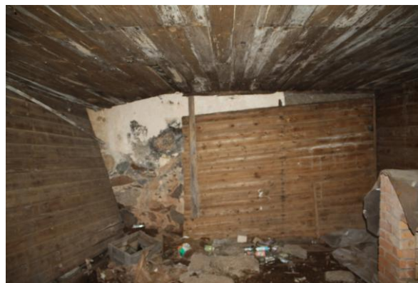
Ill. 10.–11. Puiduga vooderdatud seinad, milles paiknevad stiilile iseloomulikud ümaraknad (vasakul). Paremal pildil on täheldatav seina vajumine ja fragment maakivi vundamendist.
