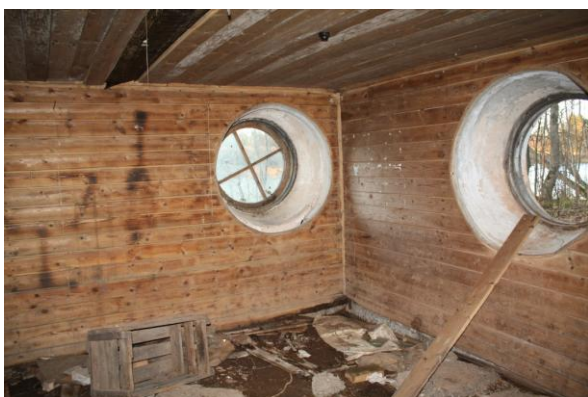
Ill. 10.–11. Puiduga vooderdatud seinad, milles paiknevad stiilile iseloomulikud ümaraknad (vasakul). Paremal pildil on täheldatav seina vajumine ja fragment maakivi vundamendist.
