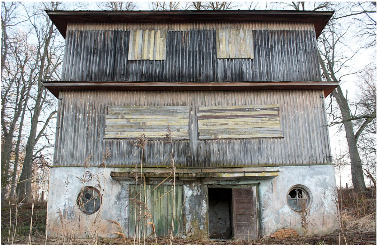
Ill. 3. Hoone läänesein. Teise korruse avatud osa on nüüdseks kinni ehitatud. Algselt oli seinata (vaid postide ja käetugedega piiratud) praegune tumedam puitlaudise osa.
