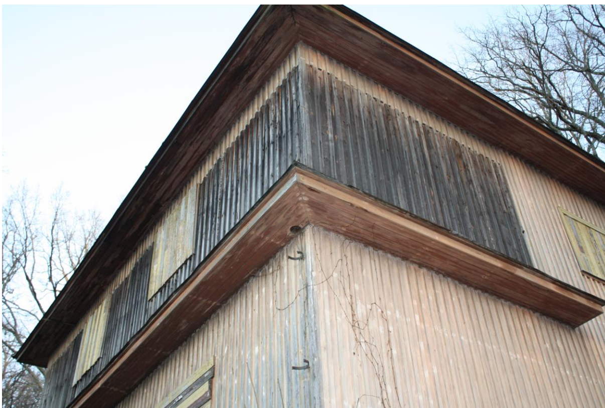
Ill. 15. Järve poolsel küljel on rennid kulgenud mitte ülalt katuselt, vaid esimese korruse räästamotiivilt. Maja teisel küljel on tavapärasem lahendus.
