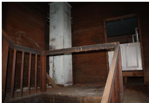
Ill. 20.–21. Vasakul pildil NL-perioodi ehitusviis keldriruumis. Paremäl pildil on näha krohviga kaetud korrektne korstnajaalg.
