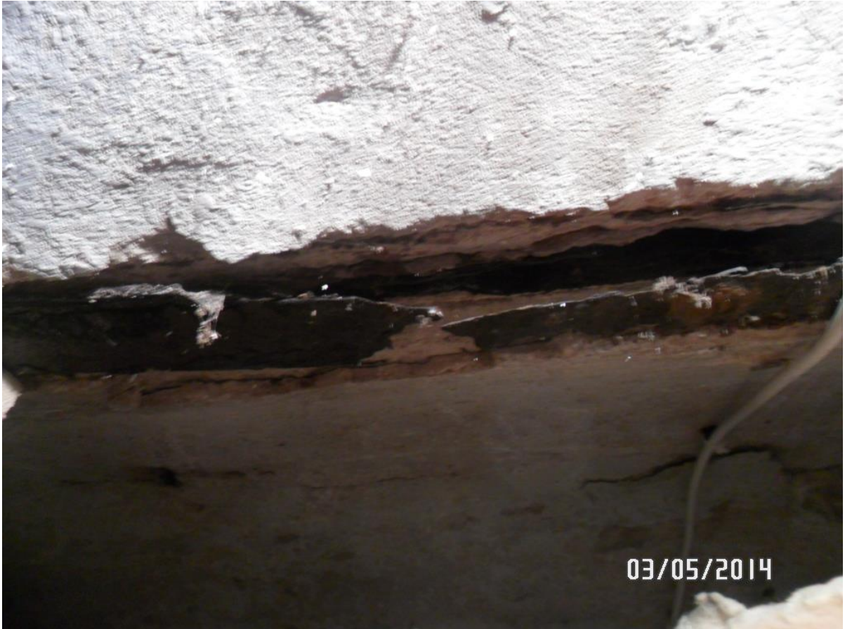
Foto 12. Tugevalt roostetanud lae kandetala
