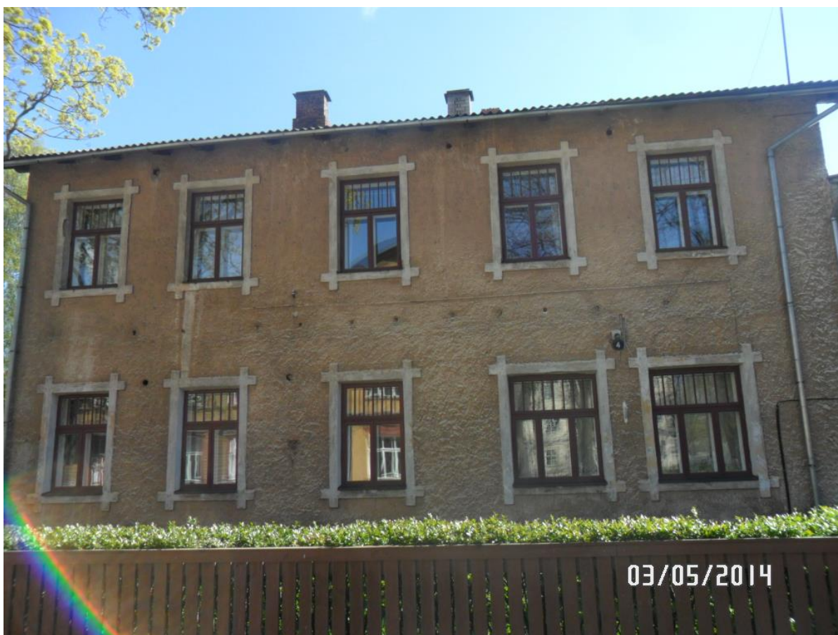
Foto 5. Hoone välisfassaad ja aknad
