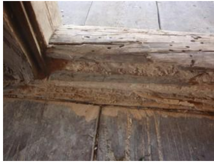
Joonis 40. Sikklaste söödud lävepakk S-ruumis (Foto: autori erakogust)
