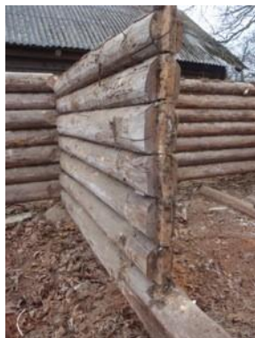
Joonis 26. Eemaldatud tendripost (Foto: autori erakogust)
