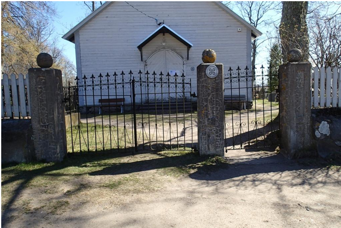
F8. Käsme kabeli peavärv, vaade läänest
