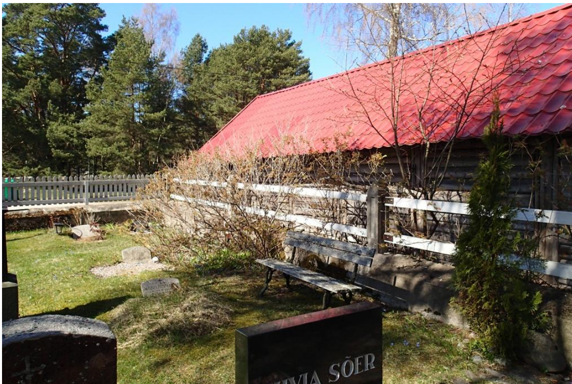
F6. Põhjapoolsel aialõigul puuduvad aialipid
