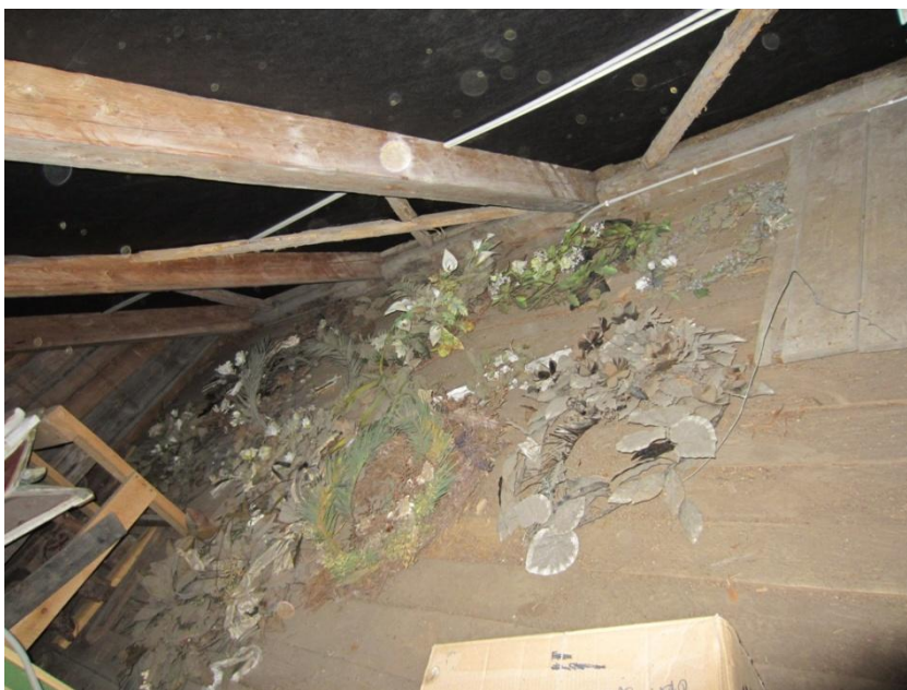
III.11 Käsmu kabeli pööningul olevad plekkpärjad
