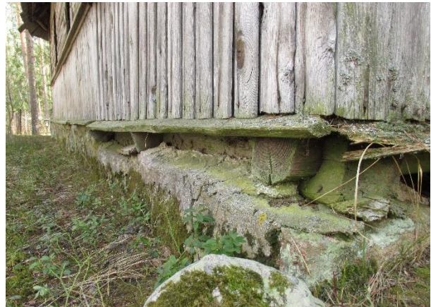
6. Vaade pikihoone vundamendile
