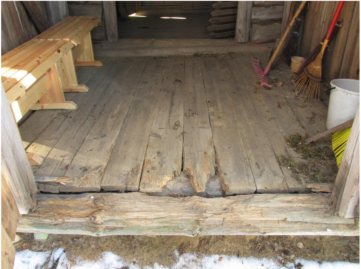
15. Kiriku torni põrandalaudis
