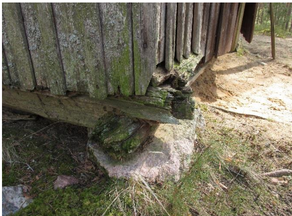
5. Vaade torni nurgakivile
