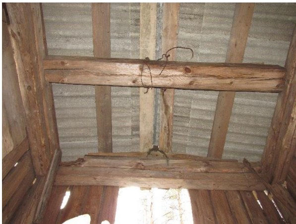
33. Torni katusekonstruktsioon ja tornikella tala
