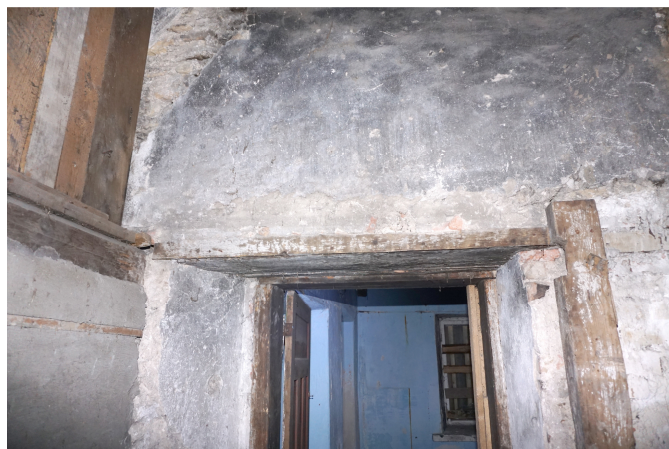
Illustratsioon 57 – Tahutud puitsillus, kaarsilluse all, trepimademe liistpunnlaud, vana uks koos lengiga ruumis 09
