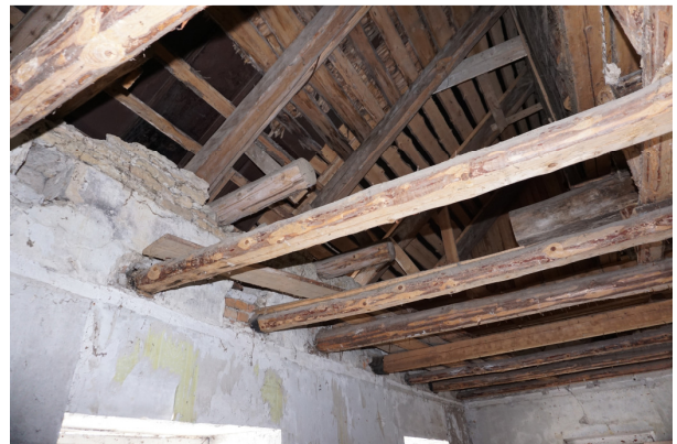
Illustratsioon 45 – Avatud konstr. ruumis 05
