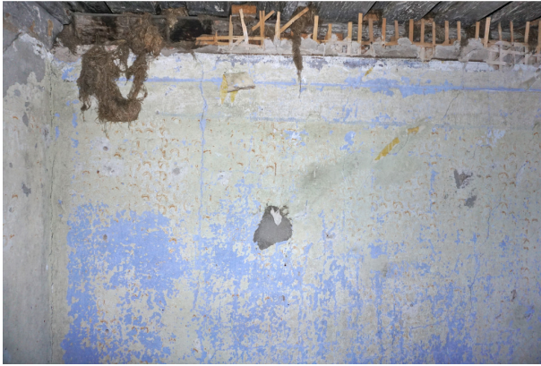
Illustratsioon 58 – Trafarettmaalingud lubikrohvil (naelutatud laastmatid), mansardkorruse ruumis 15
