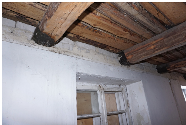
Illustratsioon 55 – Uus tellisein ja talad ruumis 11
