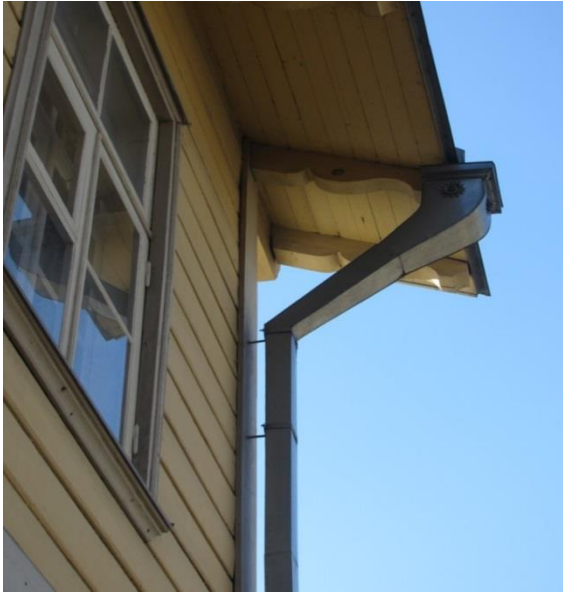
Foto 6. Vihmavee kogumiseks ja maja kaunistuseks sobib originaali järgi valmistatud kolu.
