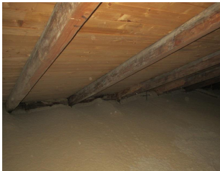
Foto 4. Originaalid ja hollandi tapiga restaureeritud sarikad kõrvuti.
