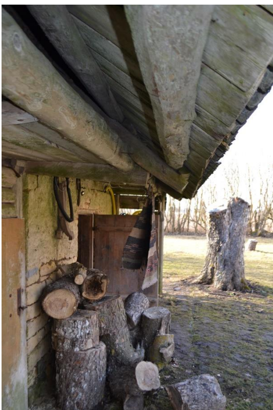
40. Aida olemasolev katuse konstruktsioon
