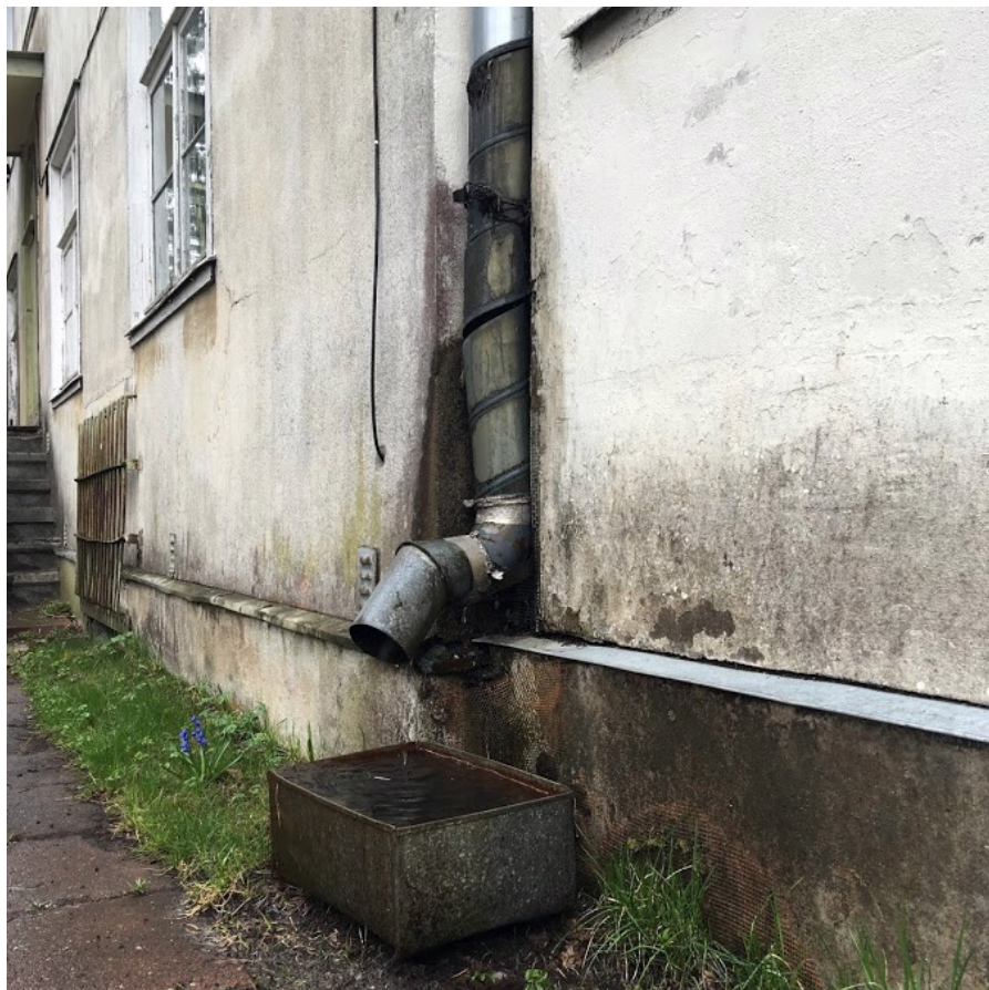
Illustratsioon 23: Sadeveetoru SVT3 on AH6 ehituse tõttu amortiseerunud ning kahjustab nii AH6 ja hoone SW nurka.
