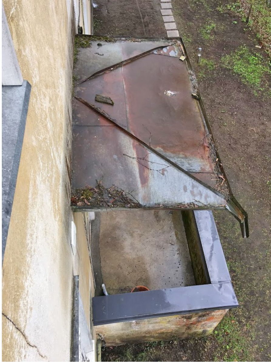
Illustratsioon 19: VK2 katus vajab puhastamist ja parandamist. Sülitit on pikendatud, pikendatud osa on alla vajunud. T2 trepiire on kaetud ilmetu plekiga.
