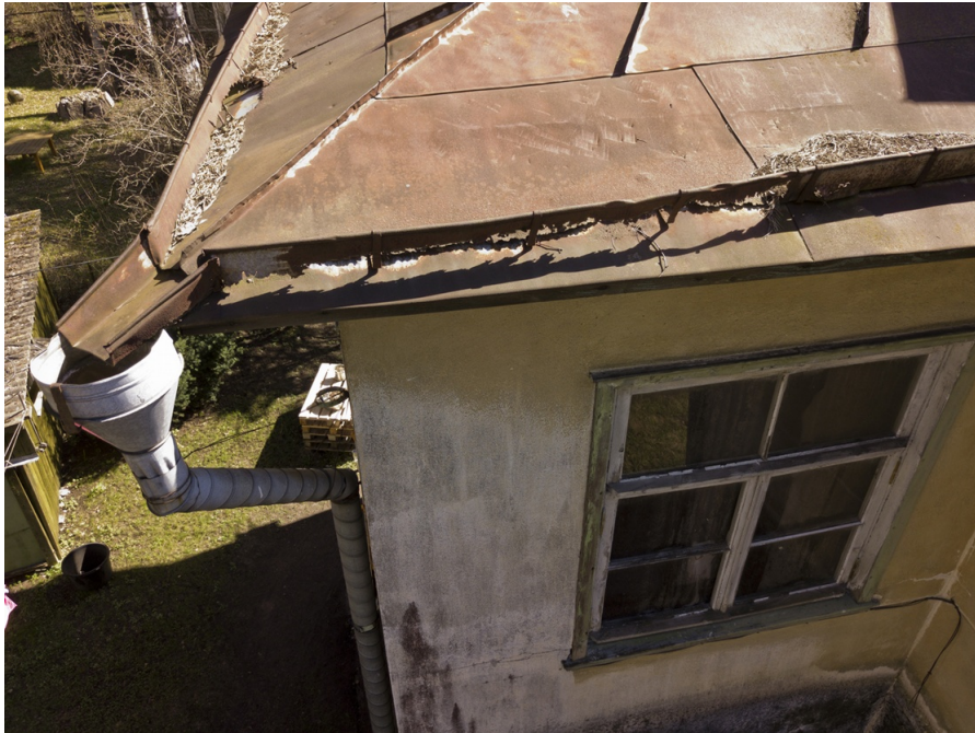
Illustratsioon 17: K1 amortiseerunud renn, mis tugevalt kahjustab VK1, hoone NW fassaade ja soklit.
