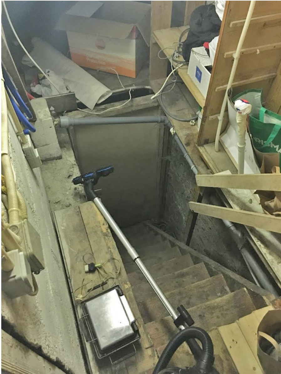
Illustratsioon 31: Sisetrepp ST4, mille kaudu pääseb krt 3 keldrisse.
