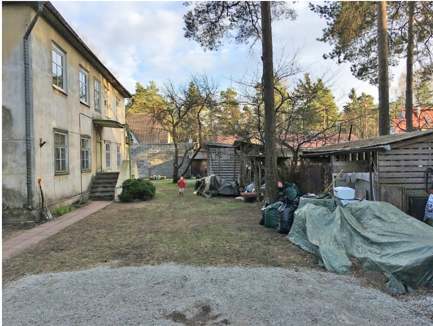
Illustratsioon 5. Vaade hoovi S-poolse prügi, kahe puukuuri ja pergolaga (AH5). Taustal paistab kuur (AH1) ja naaberkrundi tulemüür.
