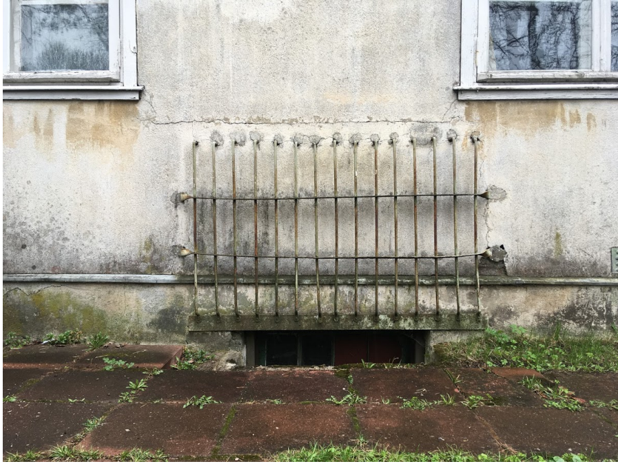
Illustratsioon 27: S-poolse keldriakna kohal on algupärane metallist fassaadikaitse.
