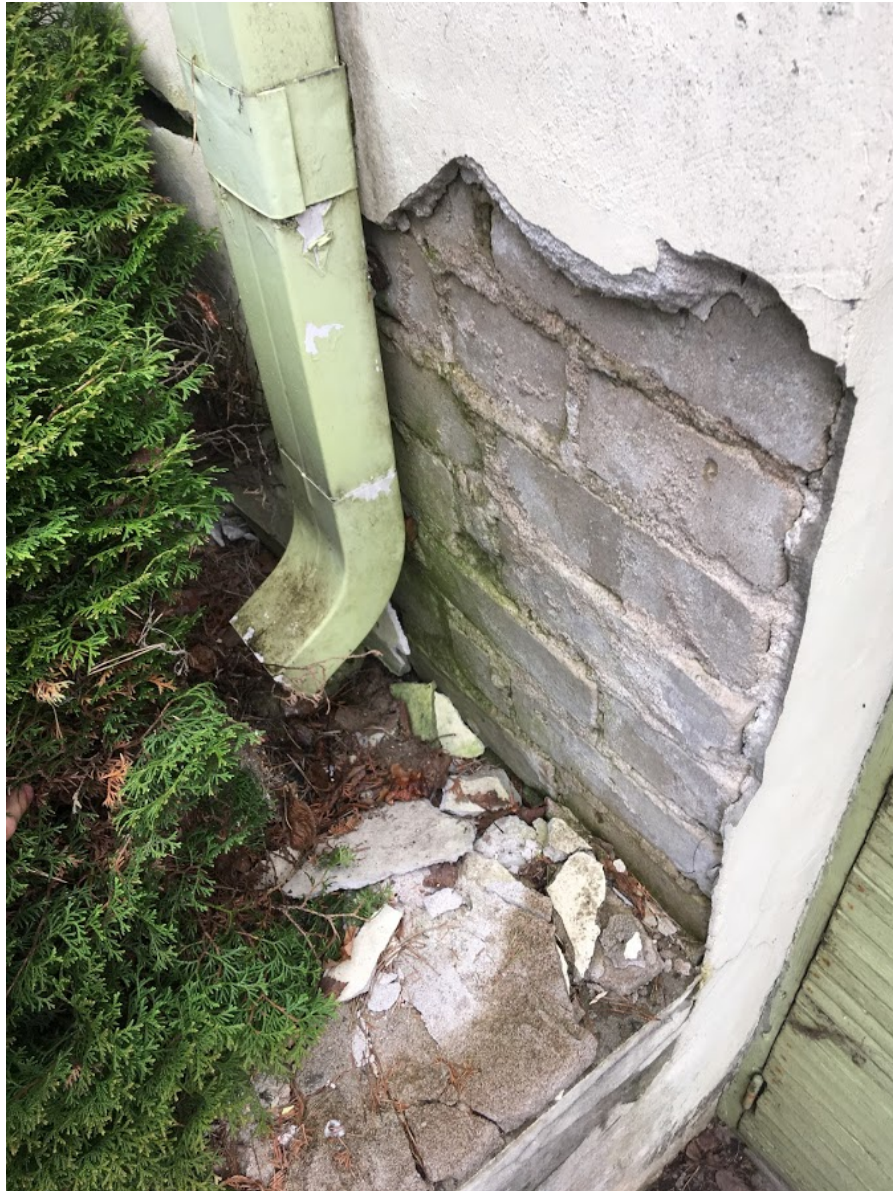
Illustratsioon 43: T4 piirde krohv on lahti ja varisenud.
