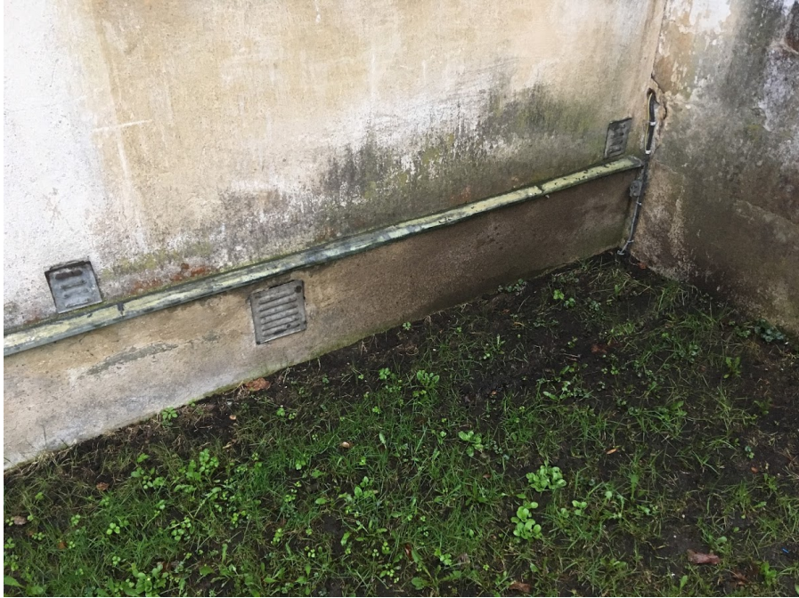
Illustratsioon 26: Sokli ja fassaadi algupäraseid tuulutused.
