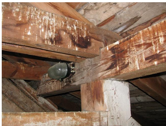
28. W-tiiva kandekonstruktsiooni nurgasõlm.
