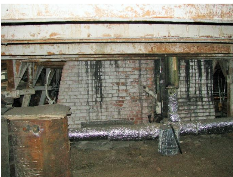
39. Ehitusaegne keskkütte korstnajak O-tiiva pööningul.
