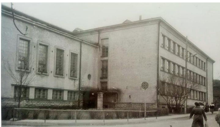
3. Vaade S-fassaadile, 1980. aastate lõpp.
