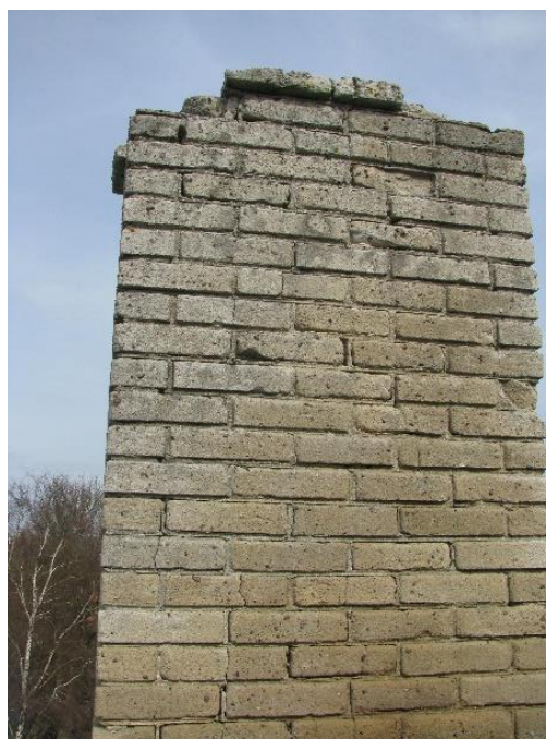
38. W-tiiva korstnapits lähivaates.
