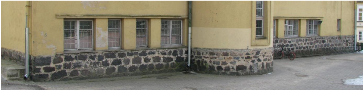
42. Õuepoolne sokkel alates O-tiiva etteulatava osa N-küljest ja W-tiiva N-külg on kohalikest maakividest.
