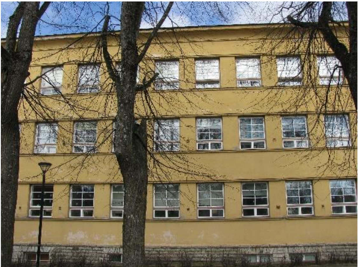
47. O-tiiva S-fassaad. Lintakna stiil.
