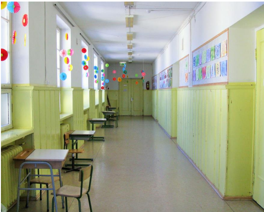
94. PP-2. Iluliistuga poolpaneel klassides ja koridorides.
