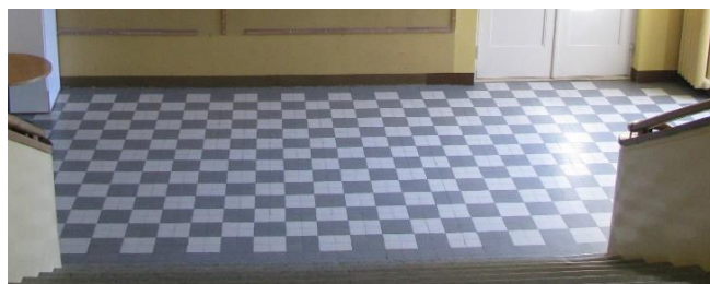
104. 2. ja 3. korruse trepimademe plaadilao muster.
