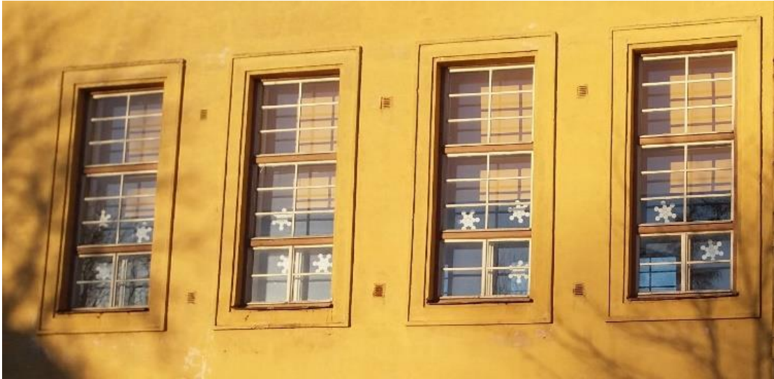
48. W-tiiva S-fassaad. Saali akende traditsionalistlik krohvraamistus.
