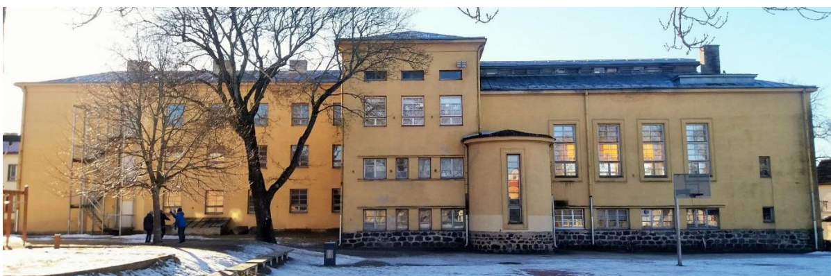
12. N-fassaad. Vaade siseõuelt.
