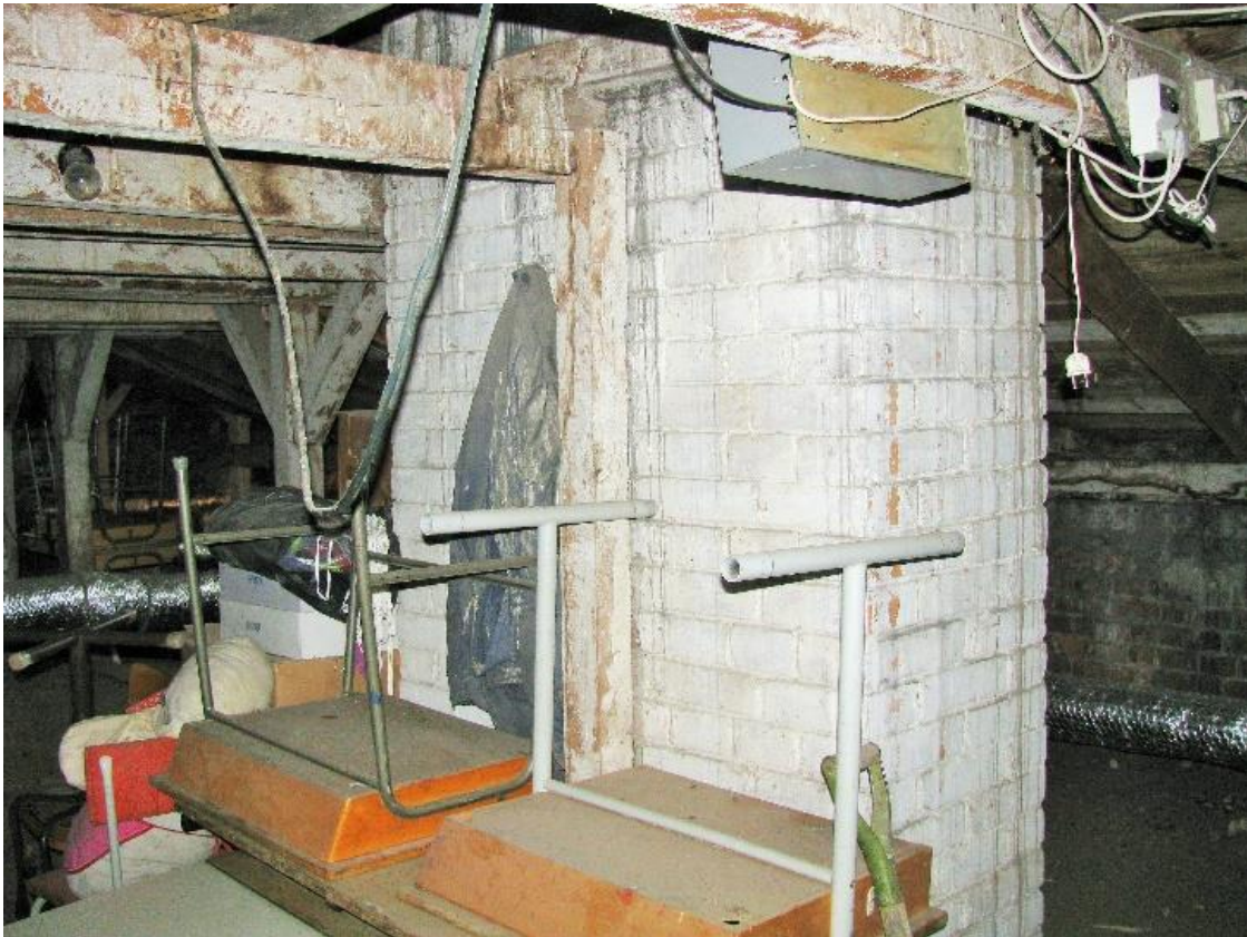
40. Korstnajak ja katuse kandekonstruktsioon O-tiivas.
