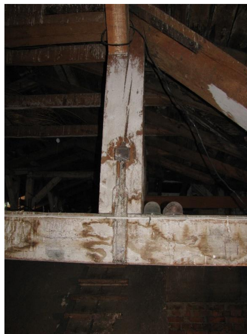
26. Metallist tõmbits peatrepi betoonkarkassi kohal oleva katusetala küljes.
