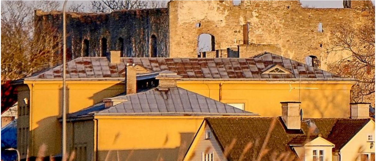
16. Vaade W-poolt hoone katusele. Esiplaanil madalam W-tiib, tagaplaanil kõrgem O-tiib.
