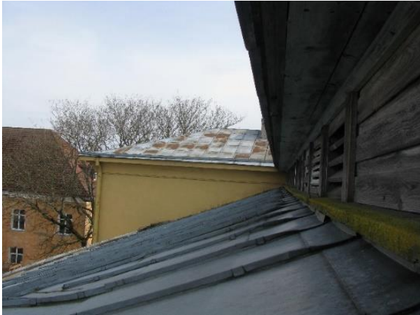
20. Vaade õhukollektori ja katuse N-küljele.
