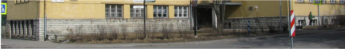
41. Hoone tänavapoolne sokkel on klombitud Lasnamäe paest.
