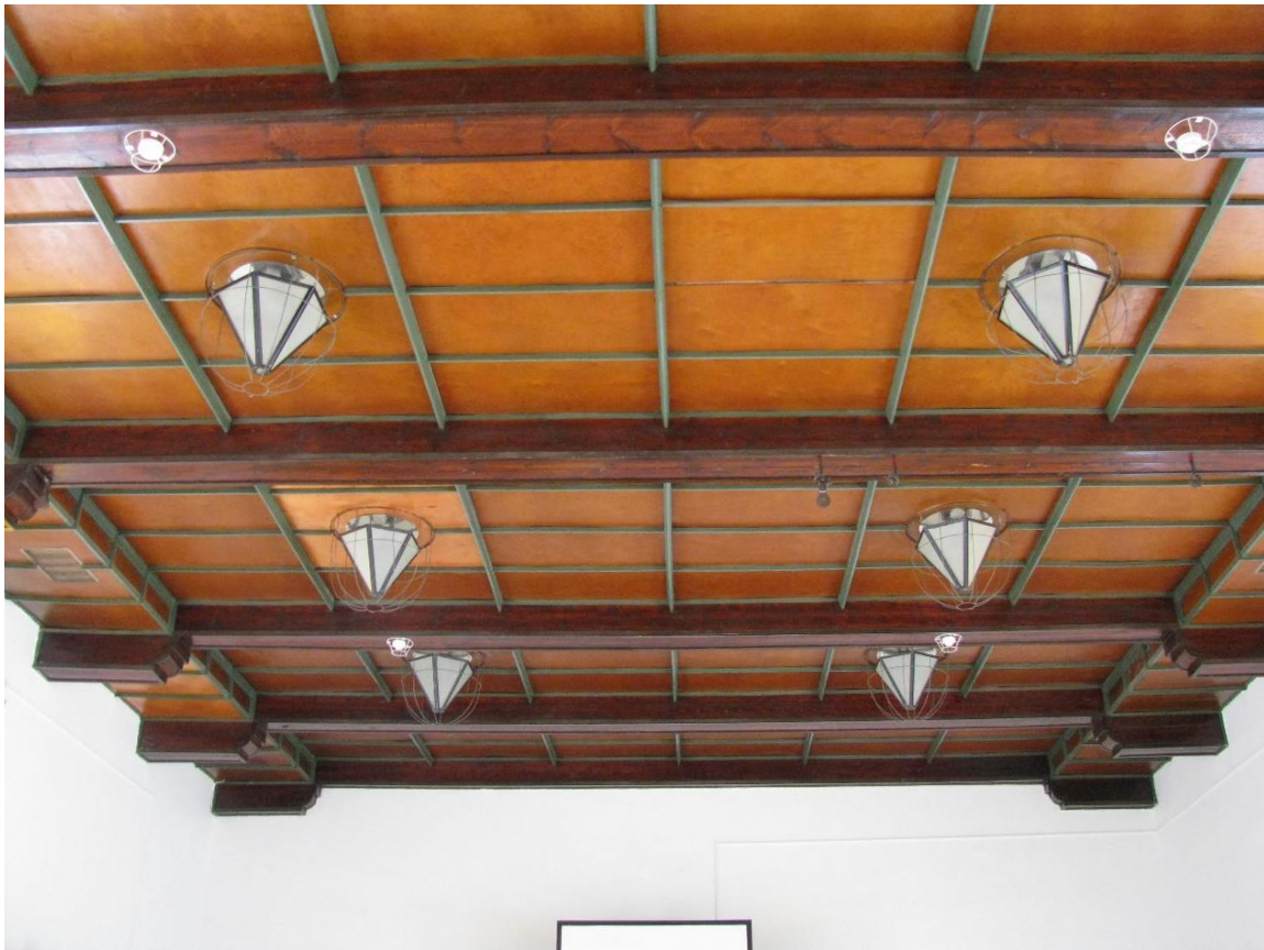
86. Kandetalad on liistudega stiliseeritud, neid toetavad profileeritud konsoolid. Talade vahel on vineerplaadid, mis on kitsa liistuga tahveldatud kassettideks.
