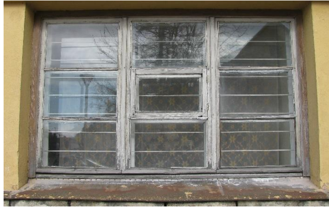
63. A-7. Keskel tuulutusaken.
