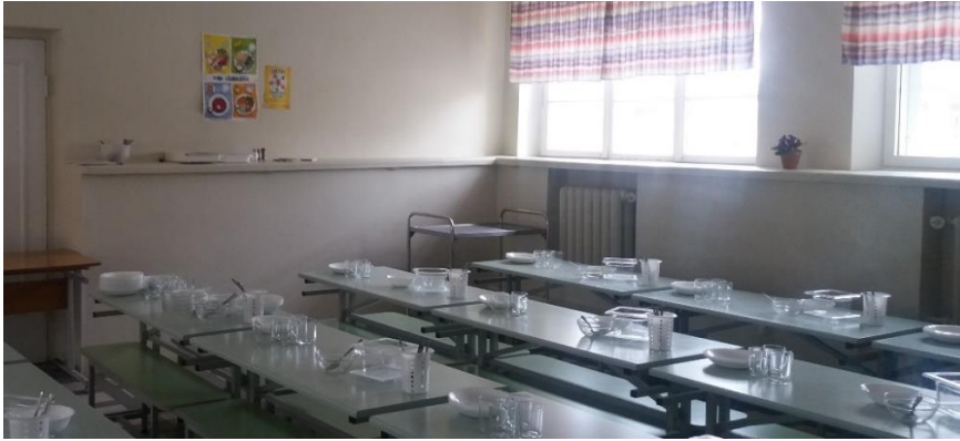
93. PP-1. Poolpaneel sööklas. Krohvitud ja värvitud.
