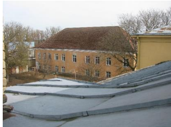
21. Vaade W-ja O-tiiva N-poolsele katusele.
