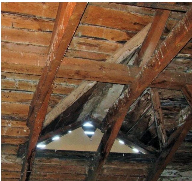
25. Uuk O-tiiva katusel.
