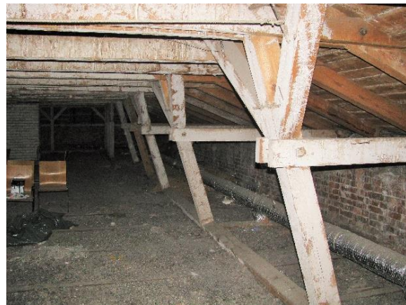
24. O-tiiva katuse kandekonstruktsioon.
