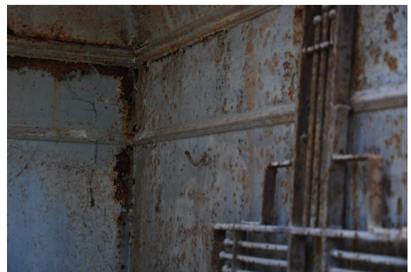
15. Kabeli sisevaade. Risti ülemine osa põhjaseinas.
