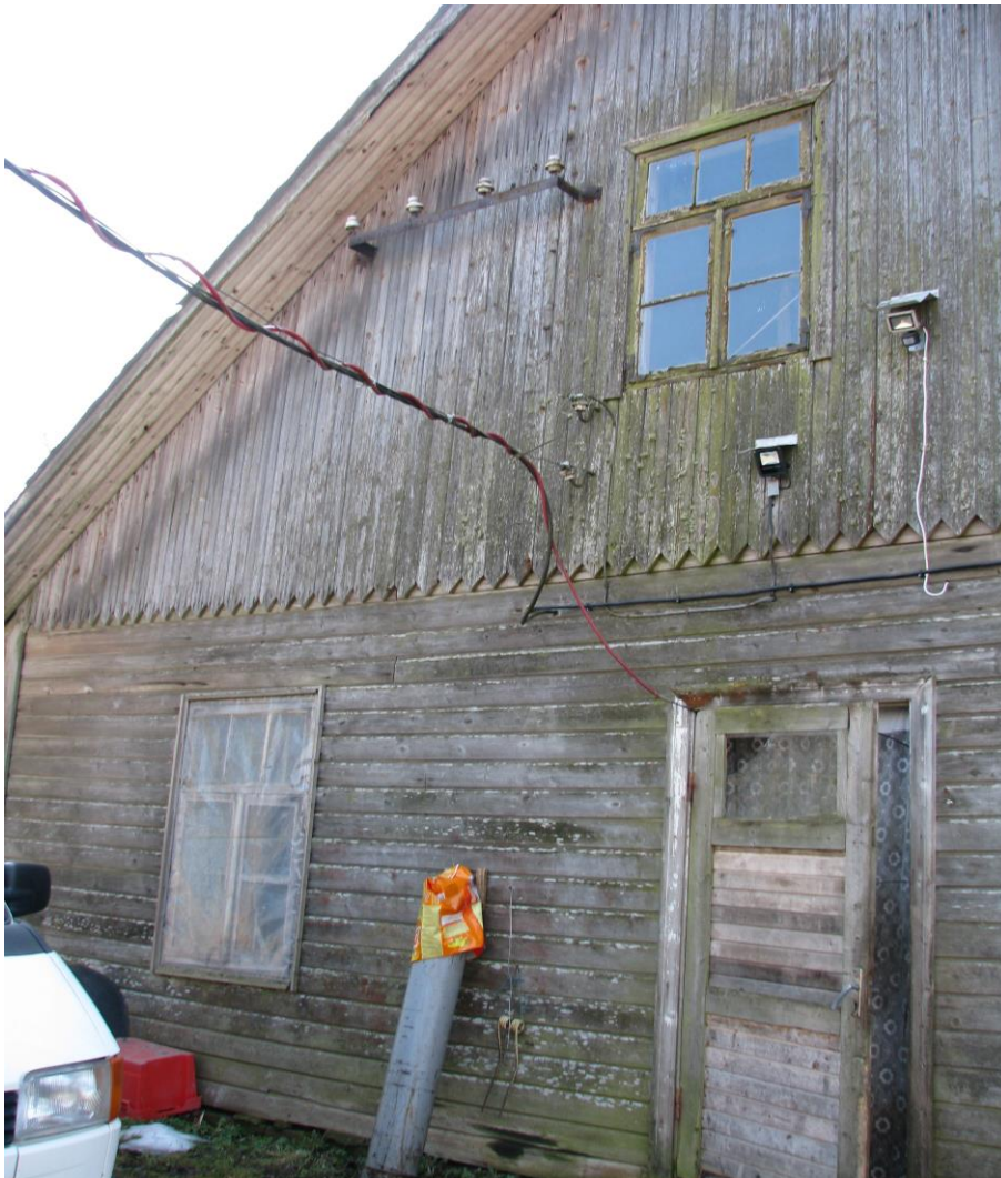
9. Vaade hoone sissepääsule hoone otsas (eestvaates vasakul)
