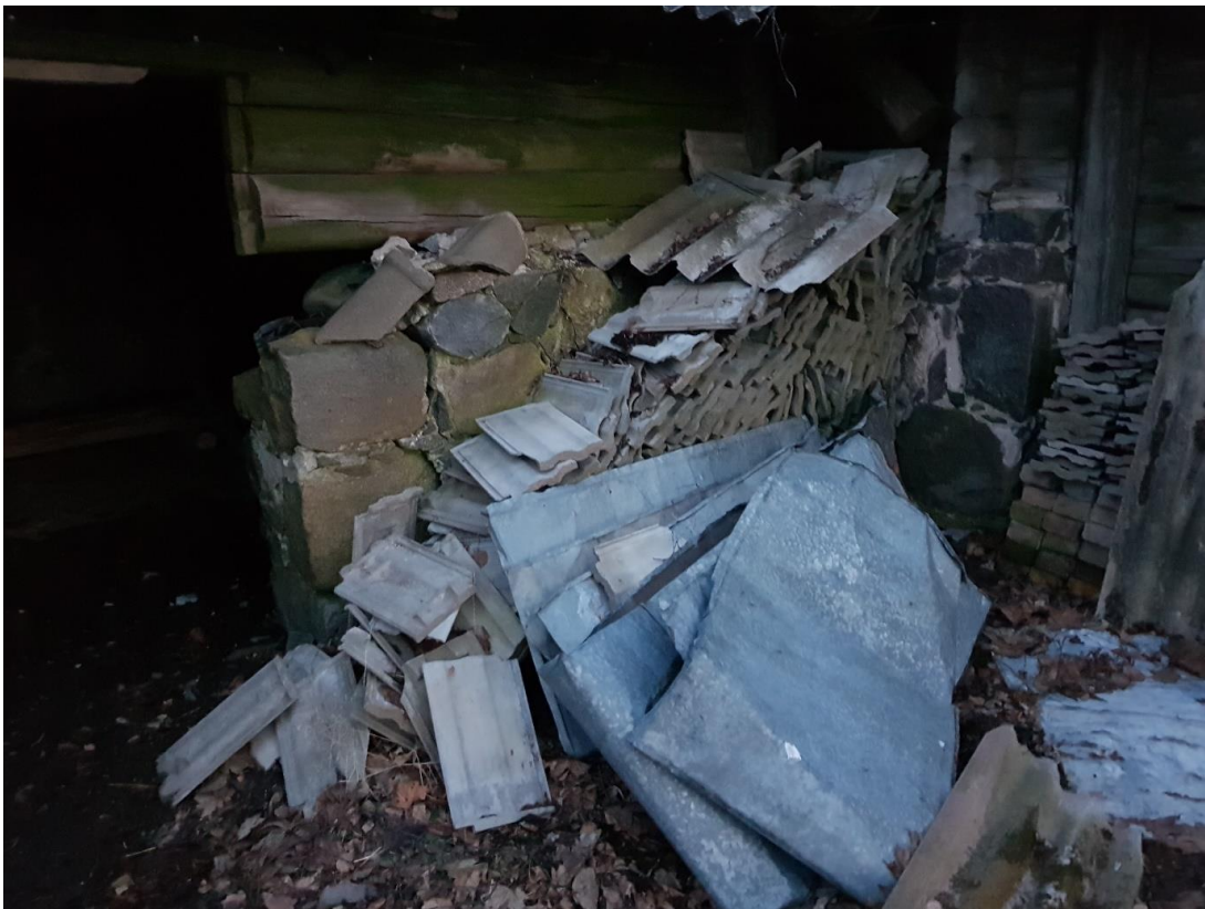
16. Laudahoone räästa all on osaliselt säilinud aidahoone katusekivid, kuid ei piisa terve katuse väljavahetamiseks
