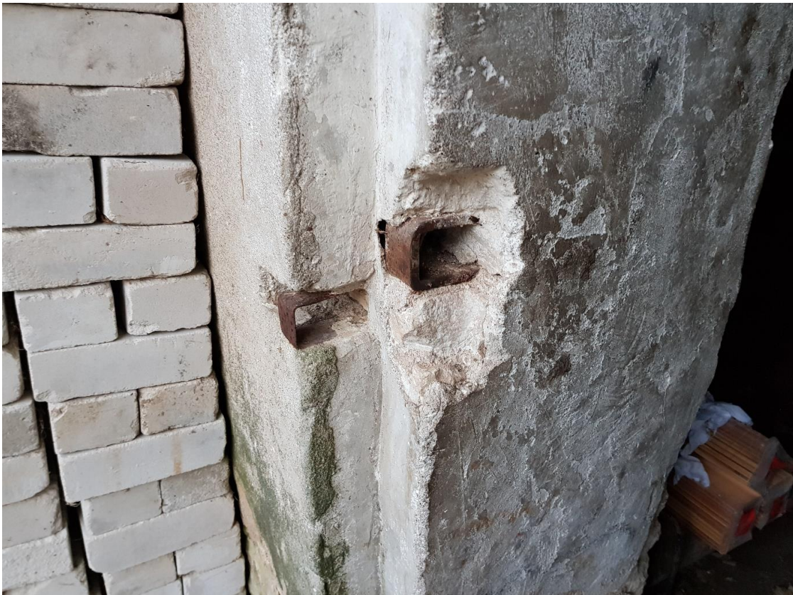
21. Aidahoone ukse lukuvastus vajab puhastamist ja kaitsmist roostetamise eest
