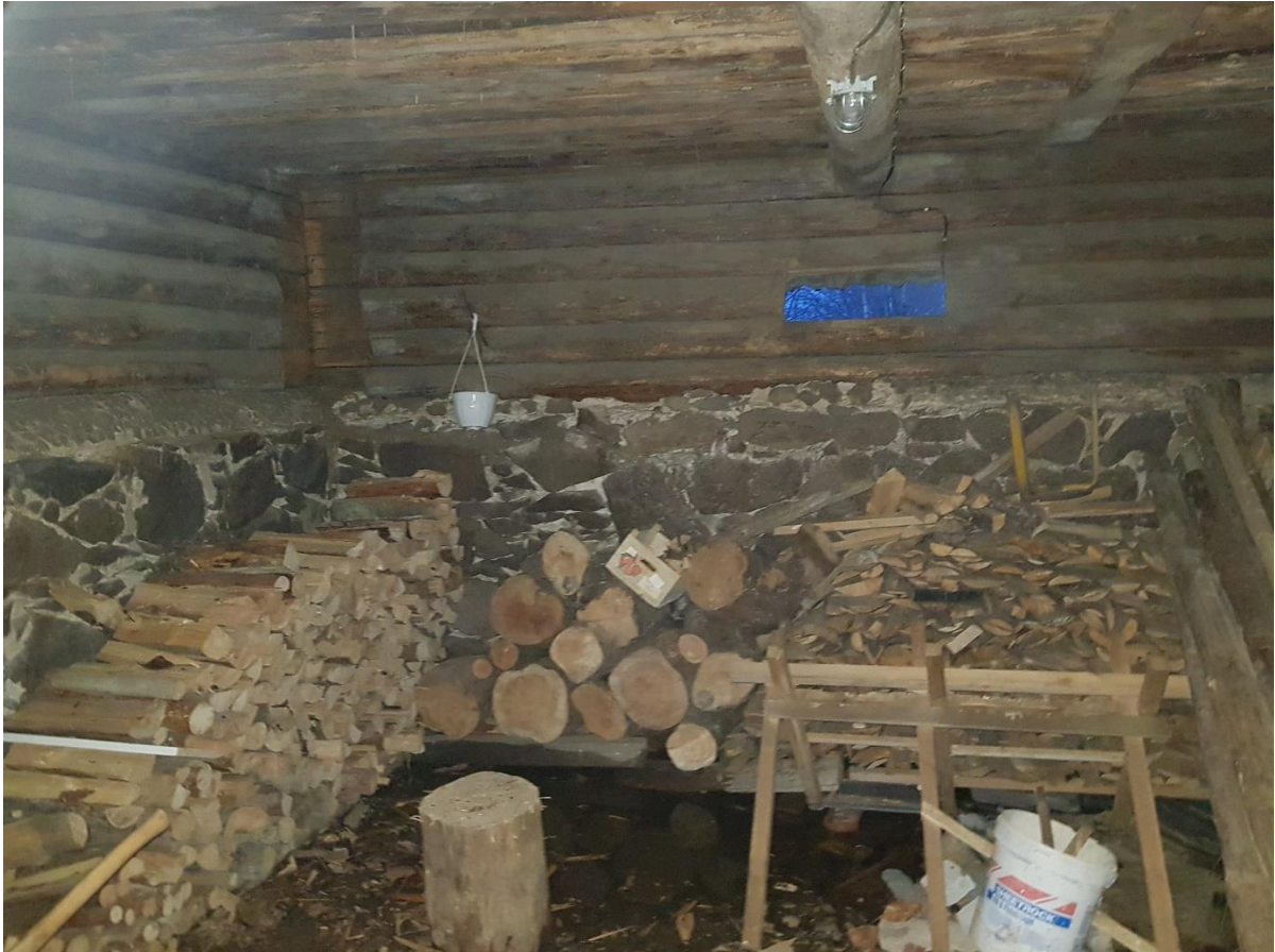
12. Üldiselt on laudahoone maakivimüür ja puitosa rahuldavas korras
