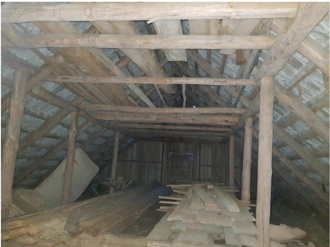
56. Aidahoone katusekonstruksioon ja toolvärk
