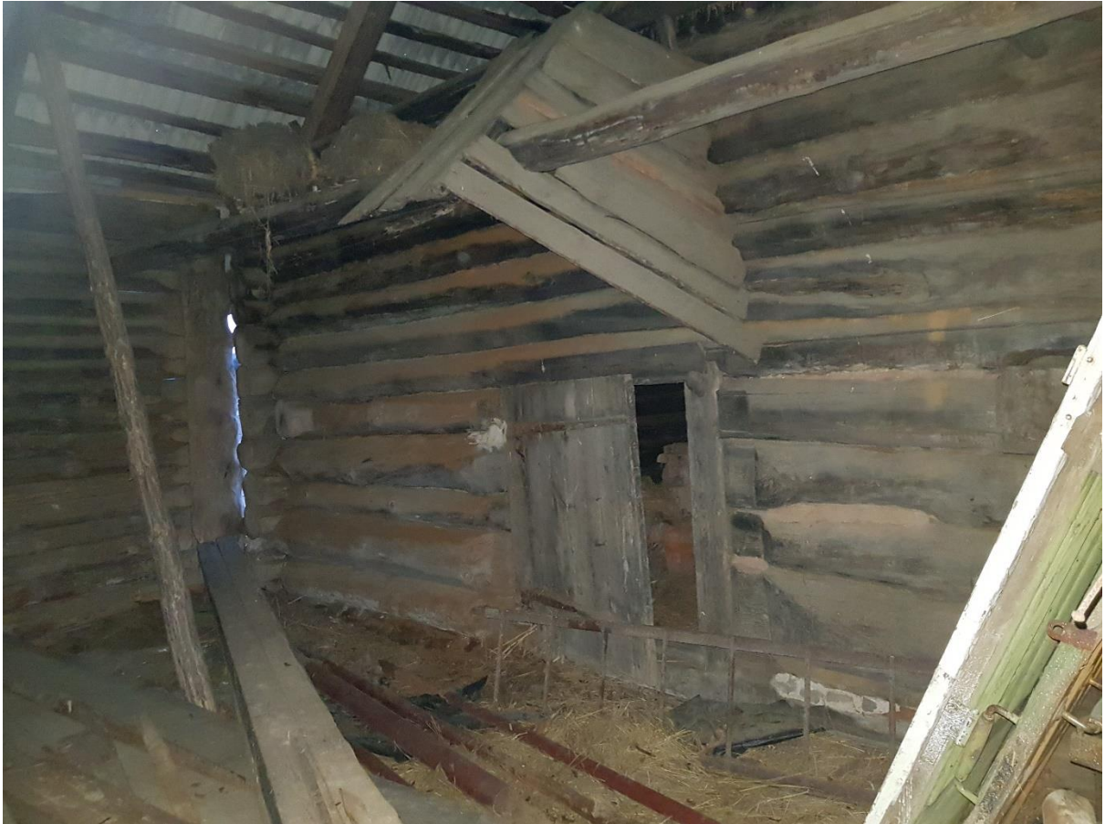
30. Rehihoone on varisemisohtlik ja osaliselt katus toestatud
