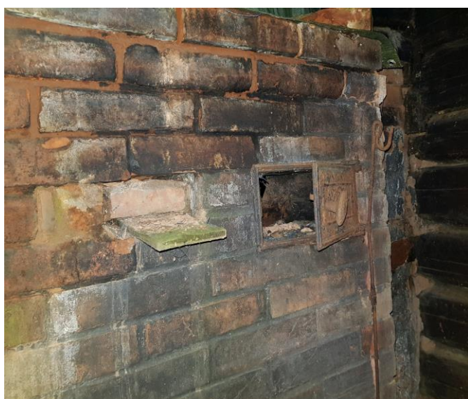
35. Eluhoones 2 asuv puukütte ahju tahmaluuk ja suitsulõõri siiber
