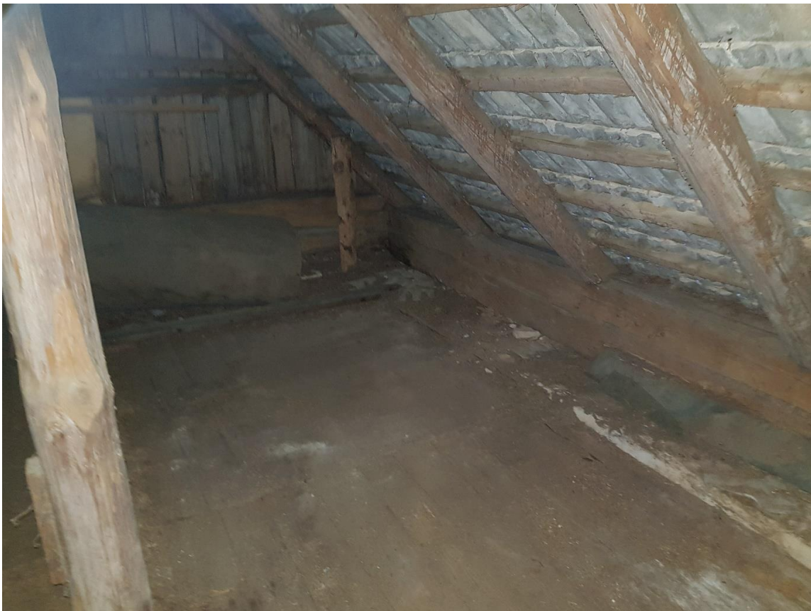
58. Aidahoone katusekonstruktsioon ja toolvärk
