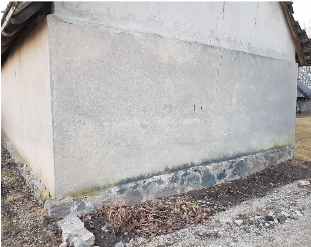
50. Aidahoone vundament on heas korras
