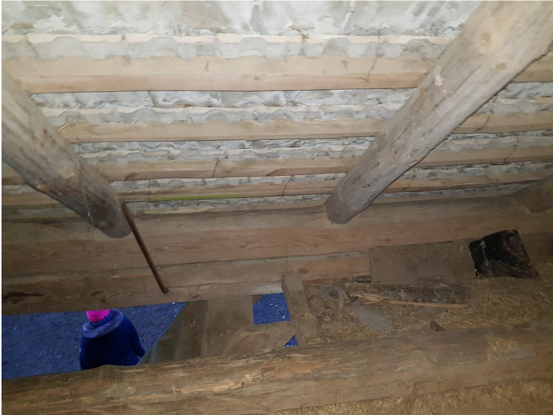
59. Aidahoone katusekonstruktsioon ja toolvärk
