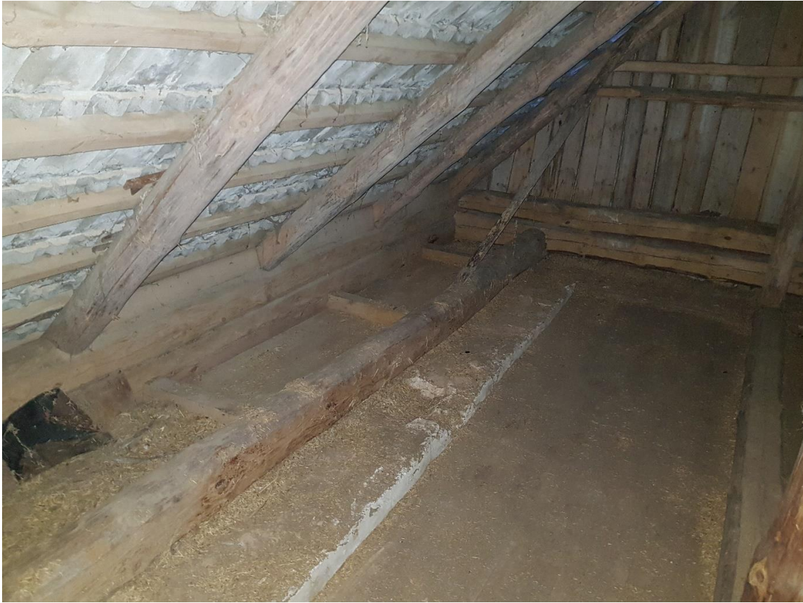
57. Aidahoone katusekonstruktsioon ja toolvärk
