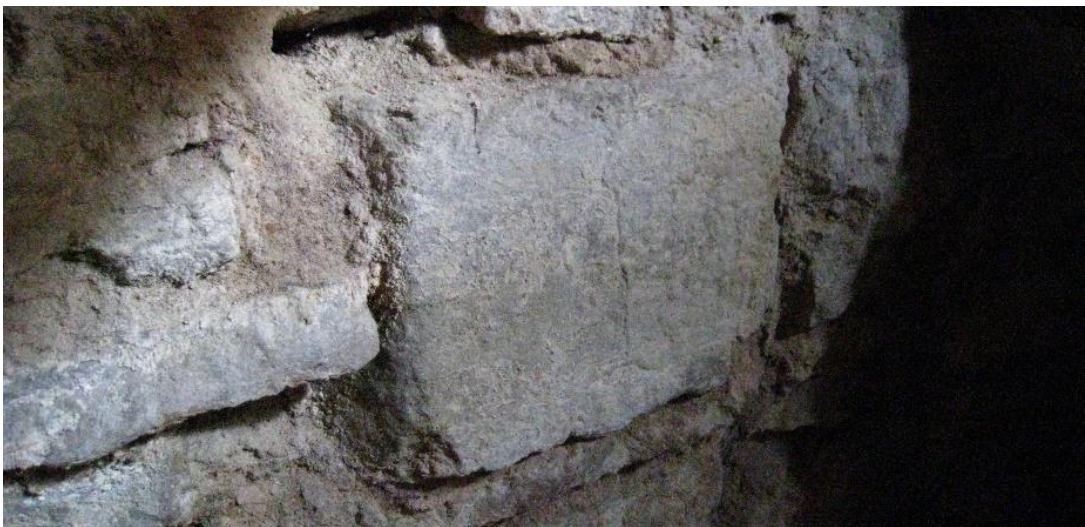
ill 38 – Hoonemahu A välisseintes taaskasutatud raidkividetailid. (Autori foto)
