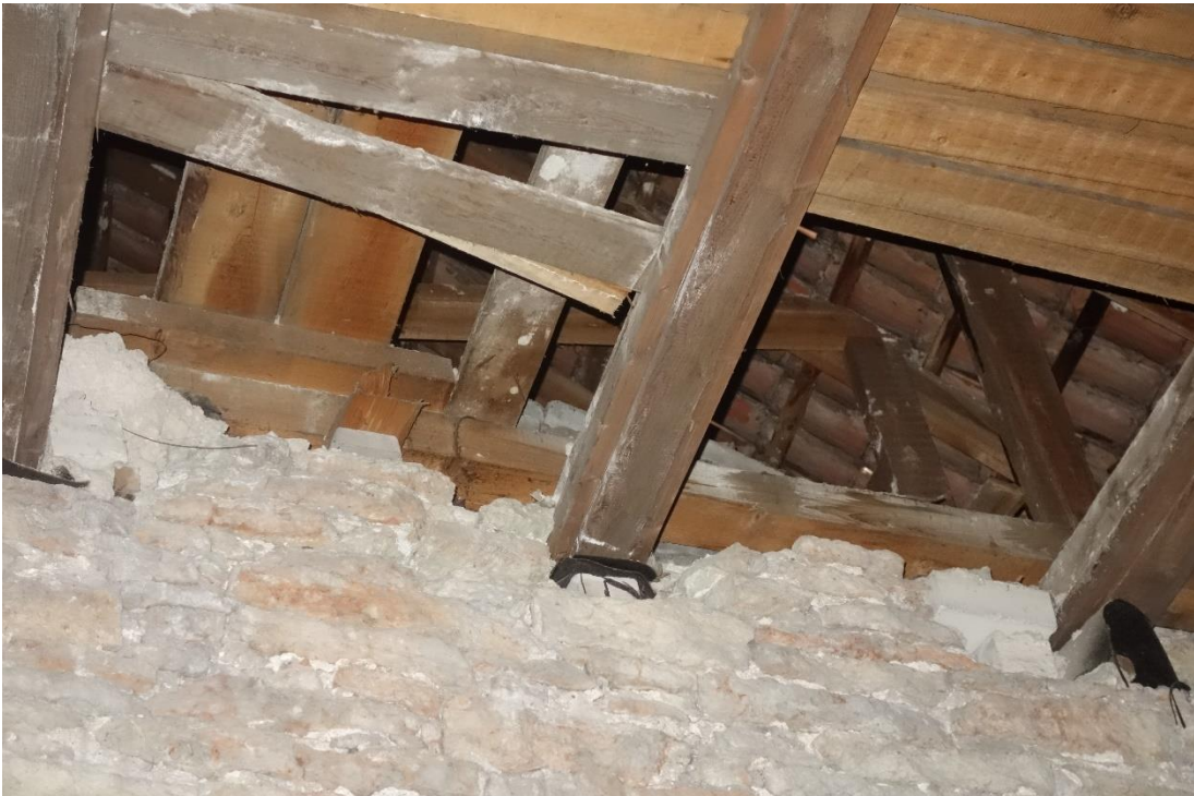
ill 23 – Hooneosa A nähtav katusekonstruktsioon
