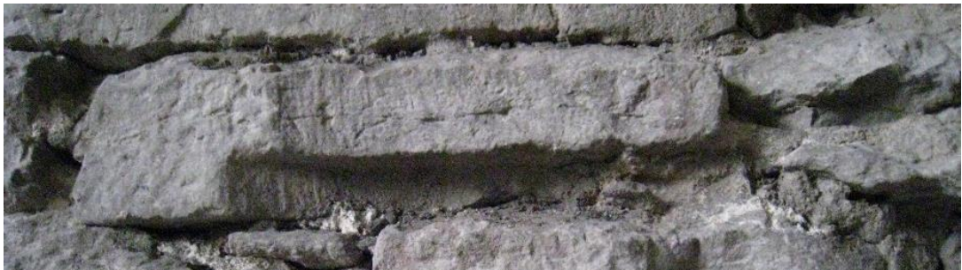
ill 37 – Hoonemahu A välisseintes taaskasutatud raidkividetailid. (Autori foto)
