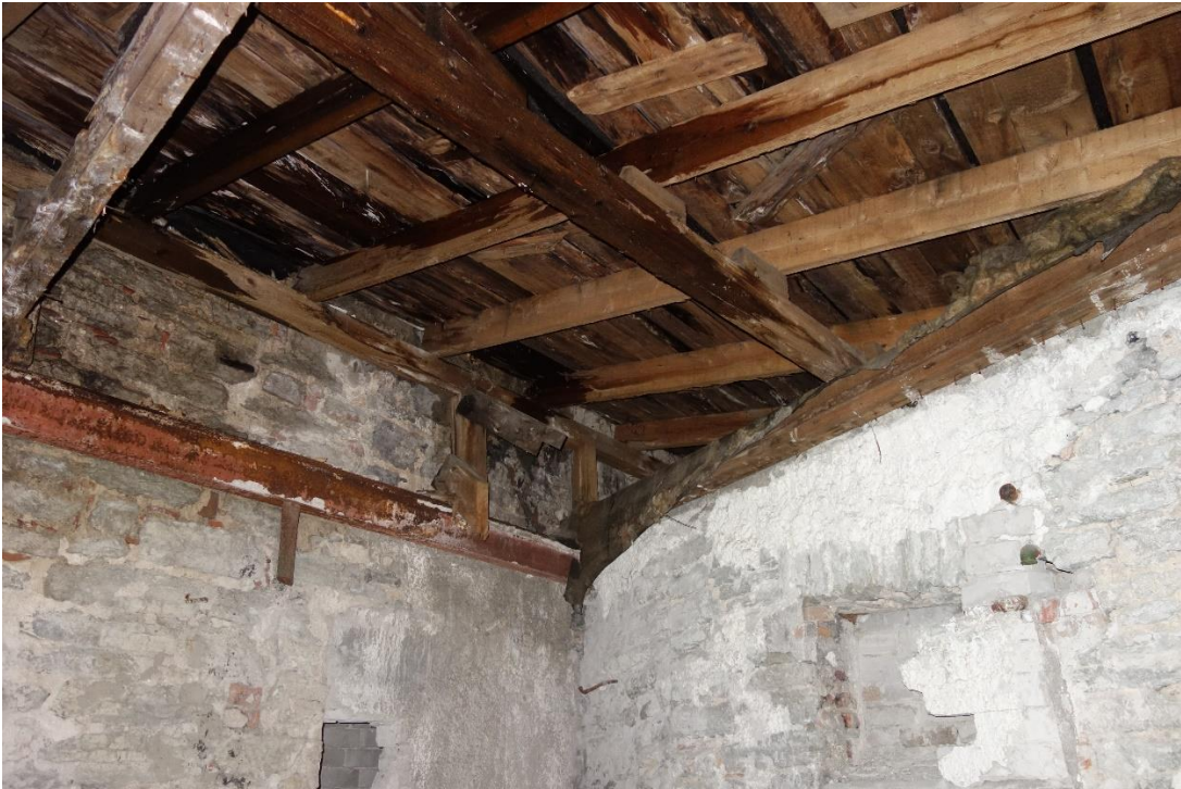
ill 24 – Hooneosa C nähtav katusekonstruktsioon
