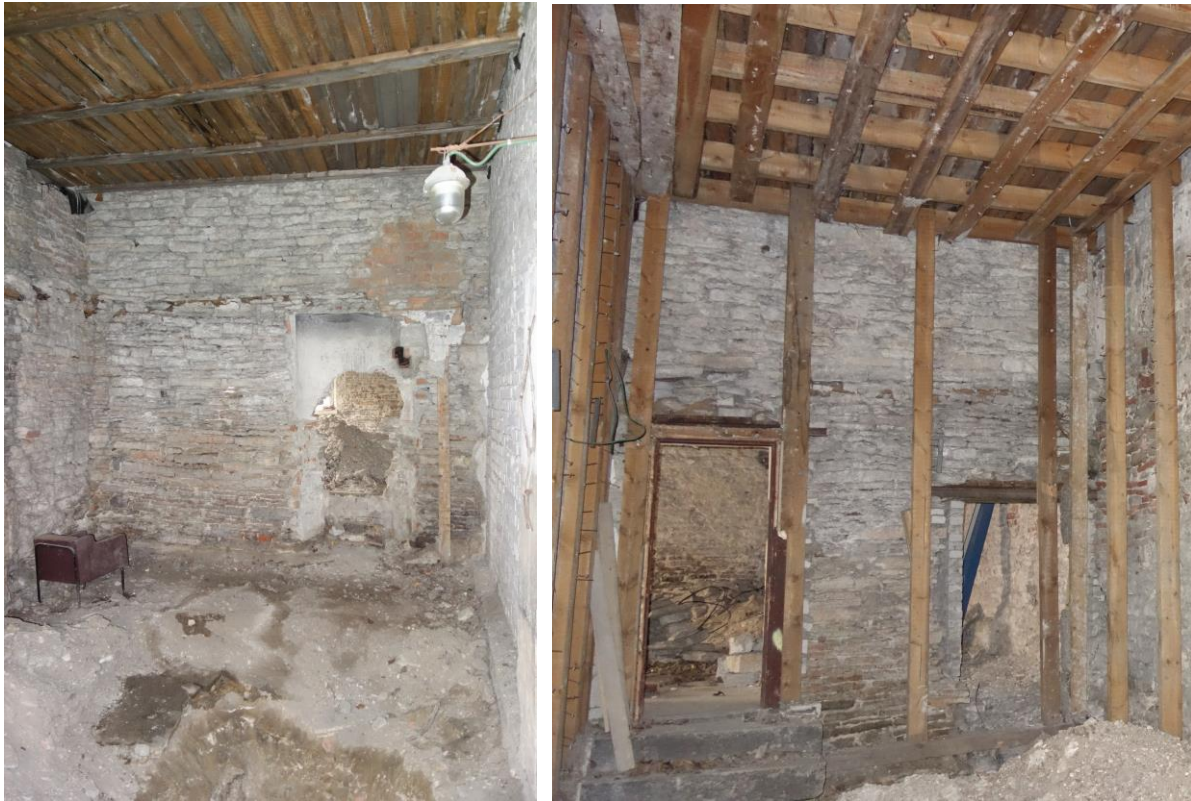
Ill 59– Paekivist vahesein hooneosas A. Nähtav endise vahelae asukoht ning erinevate ajajärkude müürliladu. Vaade ruumist 102. (Autori foto)
