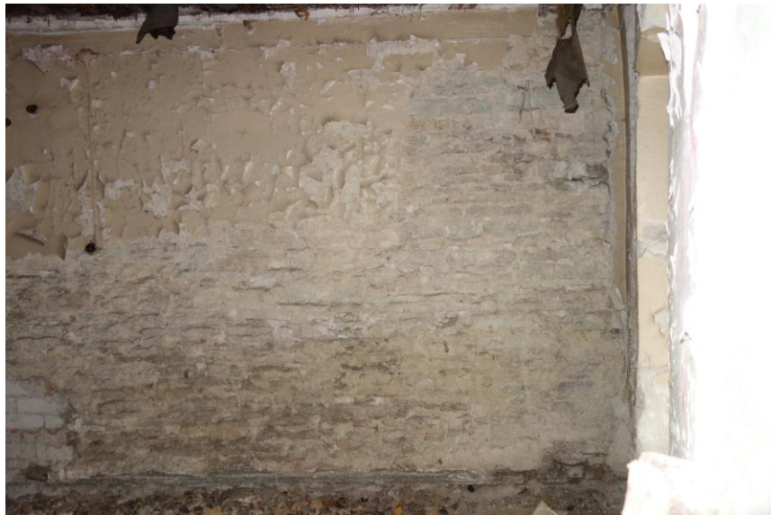
Ill 61– Paekivist vahesein hooneosas C. Seinapeal säilinud krohv ja värv. Vaade ruumist 104. (Autori foto)
