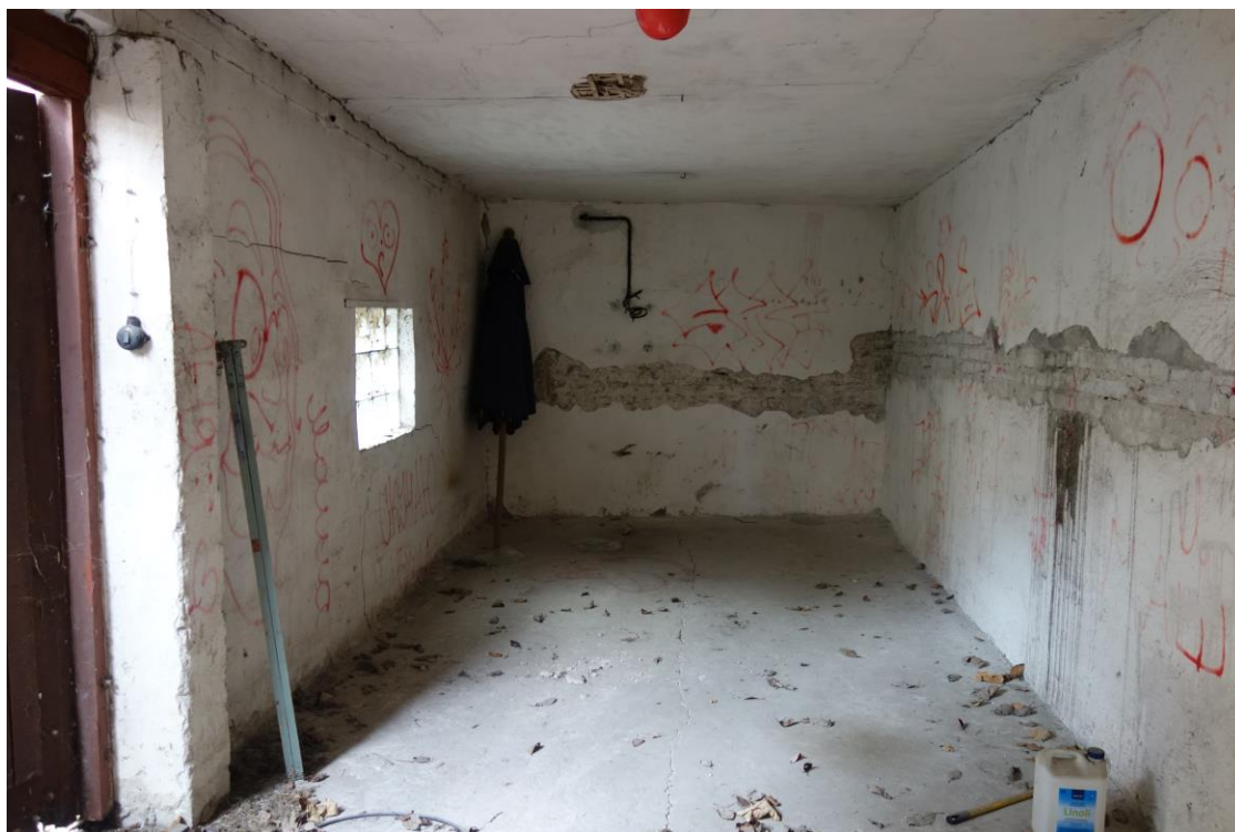
Ill 62– Betoonpõrand ruumis 111. Hooneosa A2. (Autori foto)
