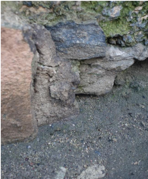
Ill 20 – Krohvi alt välja tulnud vanem krohvikihht (tume sokkel). (Autori foto)
