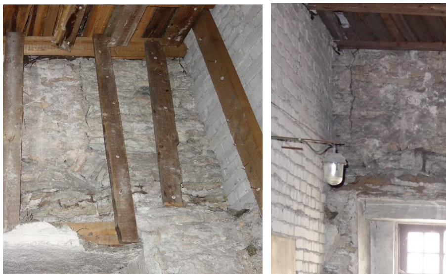
Ill 51 – Kinni müüritud anaava Laia tänava poolses välisseinas. Foro ruumi 106 poolt. (Autori foto)
