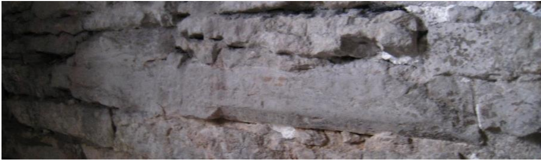
ill 36 – Hoonemahu A välisseintes taaskasutatud raidkividetailid. (Autori foto)
