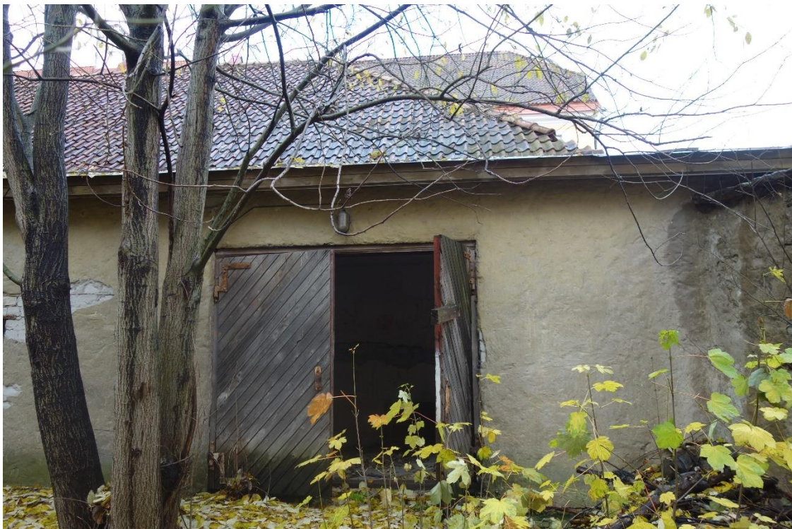
ill 18 – Vaade hooneosa A2 sisehoovipoolsele fassaadile. (Autori foto)
