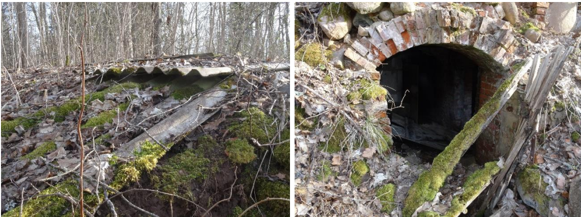
Fotod 100, 101. Keldri katuse eterniitplaadid (vasakul), keldri võlvitud sissepääs (paremal).
