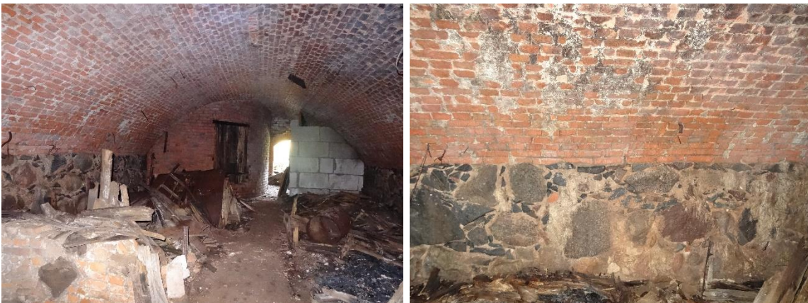
Fotod 102, 103. Keldri võlvitud lagi (vasakul), maakivist soklile laotud seinad (paremal).
