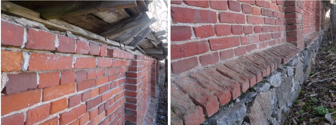
Fotod 94, 95. Kivimüüri laienev ülaosa (vasakul) ja soklile asetuvad faasitud kivid (paremal).
