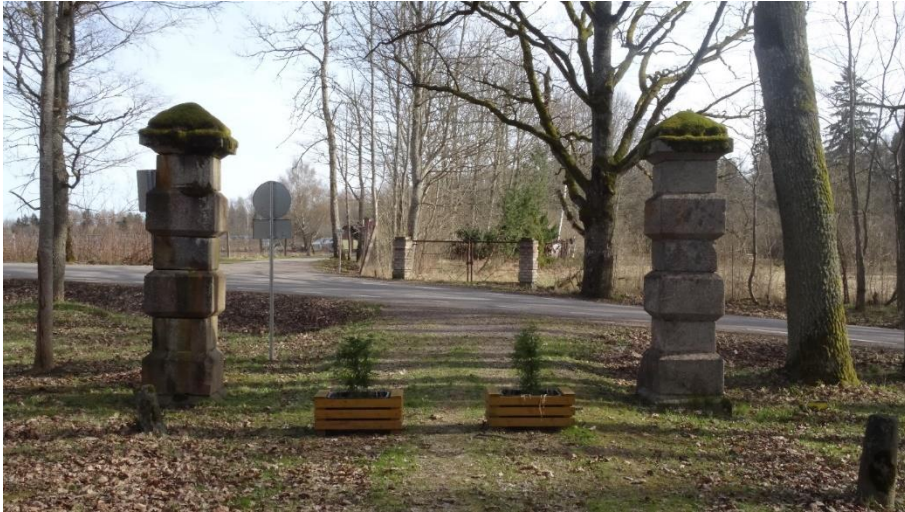
Foto 85. Vaade väravapostidele pargi poolt.
