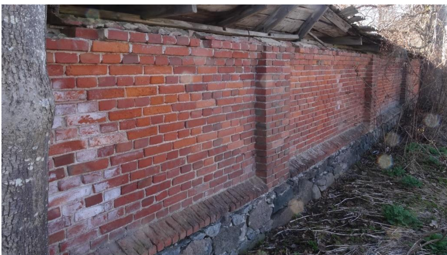
Foto 93. Piirdemüüri paremini säilinud osa. Fotel on näha müüripealset kallet, maakivist sokliosa ja postimotiivi.
