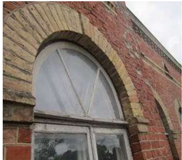
46,47. Vaade rõdult idapoolsele II korruse aknale, niiskusekahjustused lengil, raamil, veeninadel. Fotod T.Rihvk
