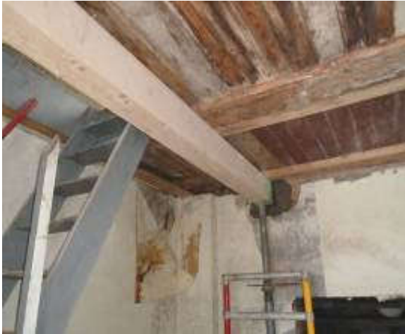
102,103. Vaade läänest ja idast, torni laekonstruktsiooni toestamine. Fotod E.Kurg
