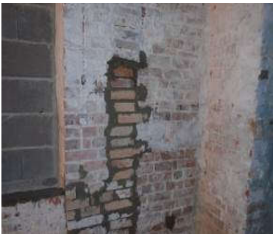
100,101. Siseseinte müüride proteesimine olemasolevate punaste tellistega. Fotod E.Kurg.
