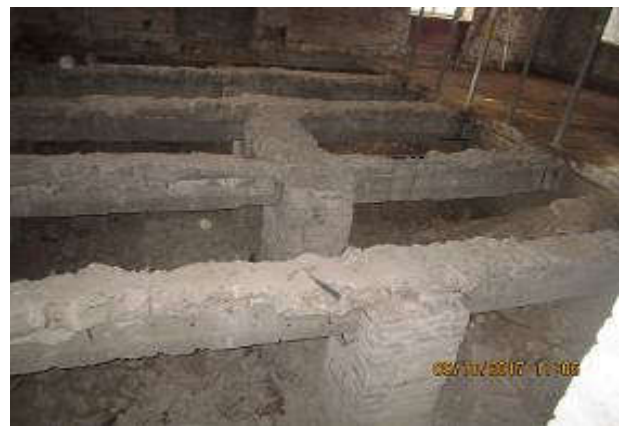
94,95. Vaade loodest ja põhjast, I korruse lõunapoolses osas lae toetus ja betoonpõranda lammutamine. Fotod E.Kurg
