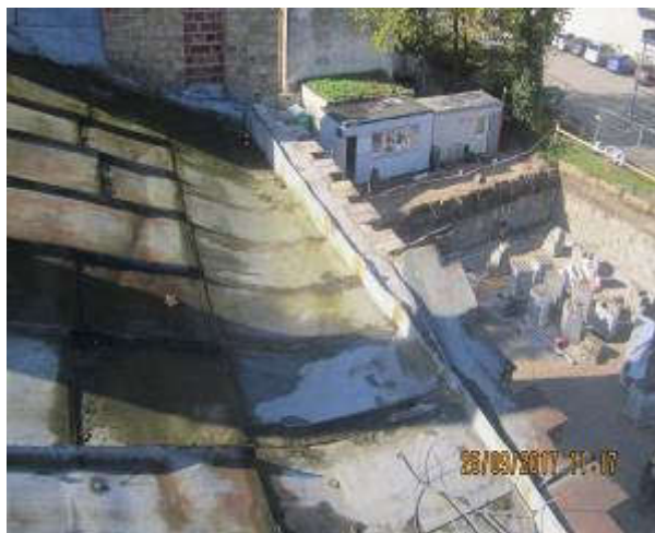
19,20. Hoone põhjapoolne valtsplekist katus, korstnad, plekil läbijooksud, karniisiplekki pole. Fotod T.Rihvk
