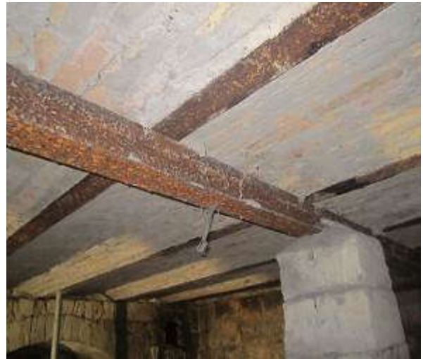
60,61. Vaade kirdest, paekivist müürid, võlvlae kandekonstruktsioon. Fotod E.Kurg
