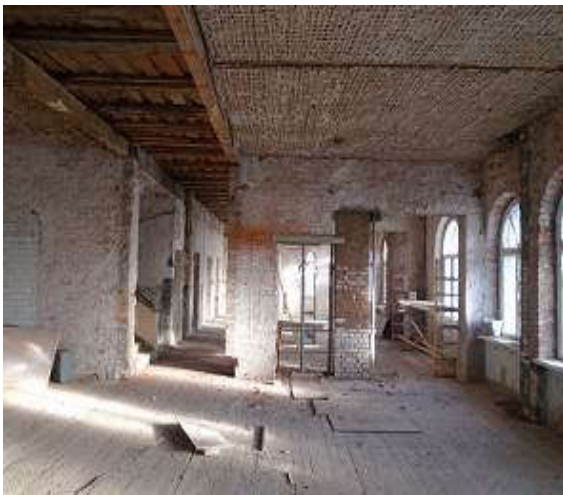
98,99. Vaade lõunast, II korrus avade kinnimüürimine uue ruumikava teostamiseks. Fotod E.Kurg
