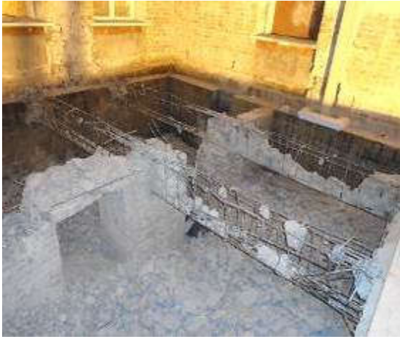
96,97. Vaade edelast, I korrus põranda lammutustööd, liivtäidisega katmine Fotod E.Kurg
