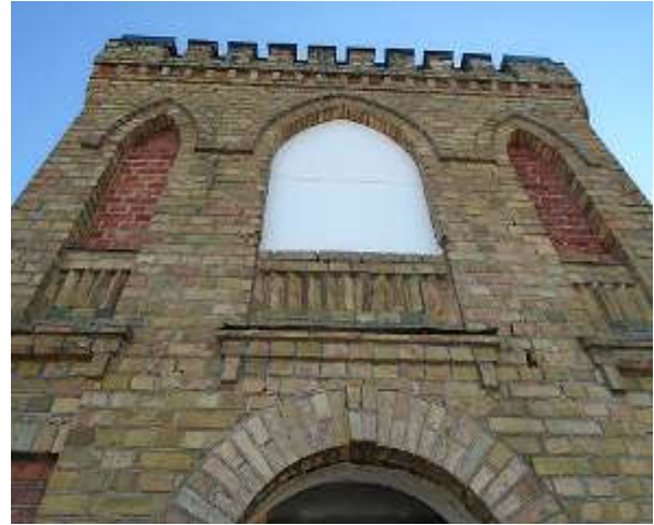
92,93. Vaade kagust ja läänest, torni katusetööd lõpetatud, nurgatippudel mütsid, metallist trepp restaureeritud, aknaavad kaetud, fassaadi parandustöid pole tehtud. Fotod T.Rihvk
