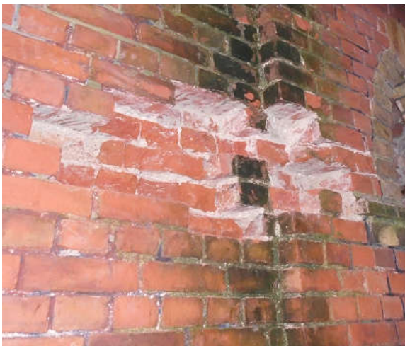
90,91. Vaade läänest, telliste parandustöö, tornil on valtsplekist katus peal, puuduvad nurgatippude mütsid. Fotod T.Rihvk
