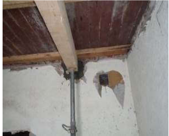
102,103. Vaade läänest ja idast, torni laekonstruktsiooni toestamine. Fotod E.Kurg
