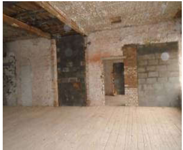
98,99. Vaade lõunast, II korrus avade kinnimüürimine uue ruumikava teostamiseks. Fotod E.Kurg
