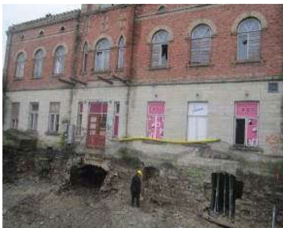
82,83. Vaade edelast ja läänest, puistu ja hoovimaja on likvideeritud. Vundamendis avad keldrisse. Foto E.Kurg
