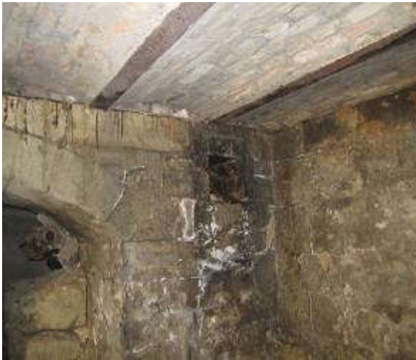
60,61. Vaade kirdest, paekivist müürid, võlvlae kandekonstruktsioon. Fotod E.Kurg
