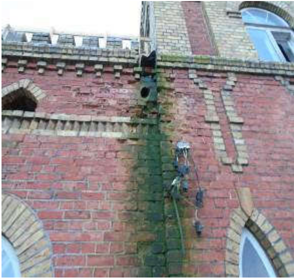
24,25. Vaade lääne- ja idapoolse külje vihmaveesüsteemide põhjustatud kahjustustest. Fotod T.Rihvk
