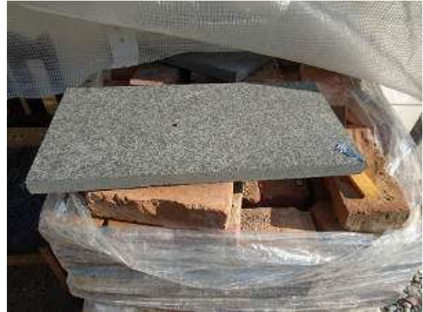
120,121. Säilitatud algsed tellised müüride parandustöödeks. Fotod E.Kurg
