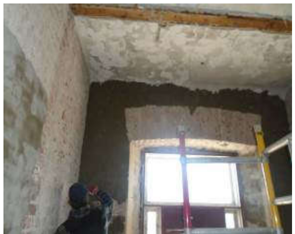
106,107. Vaade põhjast ja idast, I korruse lõunapoolse osa lae kandetalade postid toetuvad vundamendile ja talad ise kandvale vaheseinale ja ripplae karkass, krohvimistöõ. Fotod E.Kurg
