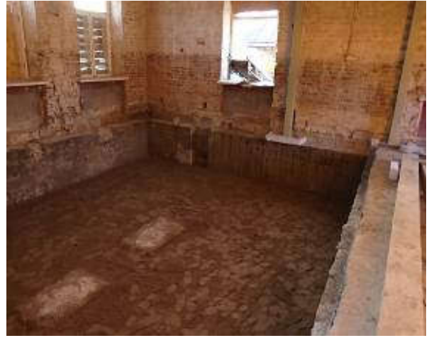
96,97. Vaade edelast, I korrus põranda lammutustööd, liivtäidisega katmine Fotod E.Kurg
