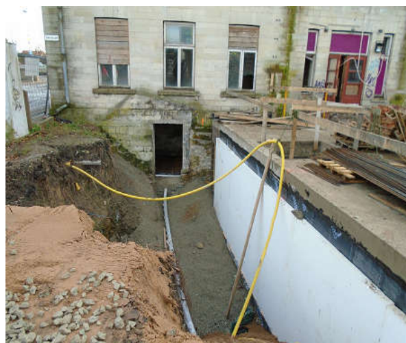
84,85. Vaade läänest, keldri seinte võlvide tugevdamine, hoone põhjapoolse osa ava säilitati. Fotod E.Kurg
