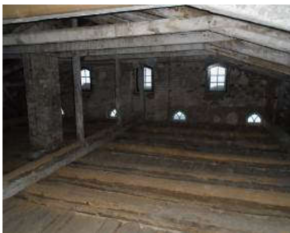
110,111. Vaade lõunast, pööningu aknad on restaureeritud ja tagasi paigaldatud. Fotod E.Kurg
