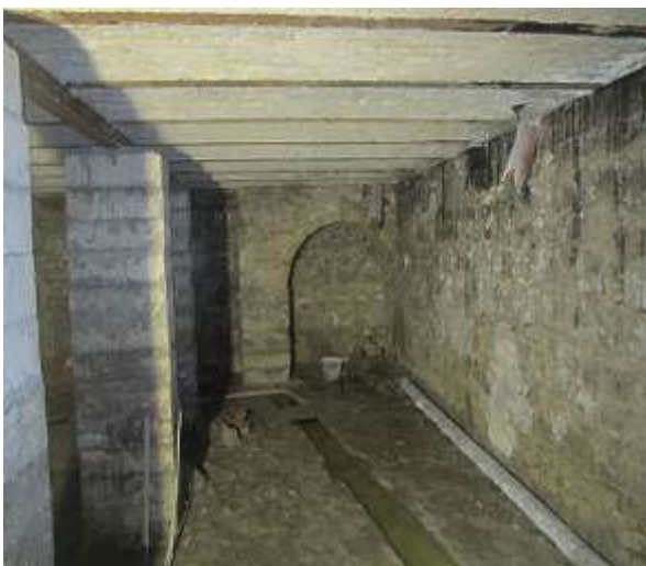
58,59. Vaade lõunast ja läänest paekivist müüridele, tellistest võlvlaele. Fotod E.Kurg
