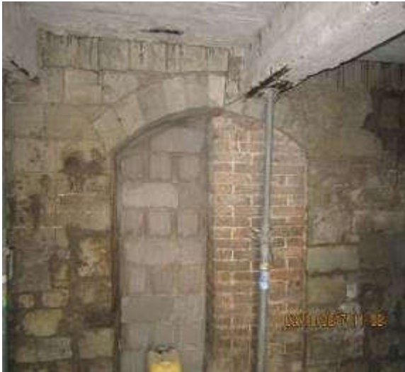
112,113. Kandva seina tugevdamiseks müüriti ukseava täiesti kinni, varasemalt müüritud ava. Fotod E.Kurg
