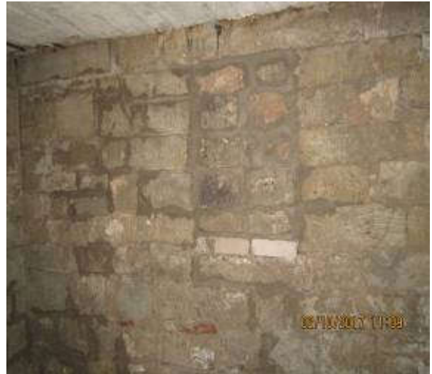
112,113. Kandva seina tugevdamiseks müüriti ukseava täiesti kinni, varasemalt müüritud ava. Fotod E.Kurg
