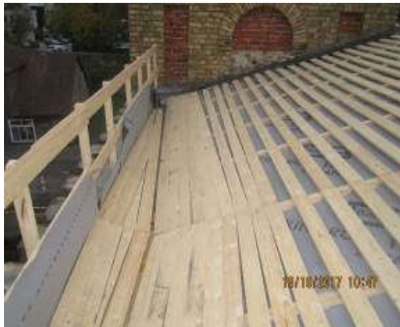
72,73. Vaade lõunast ja läänest, katuselaudis, tuuletõke. Fotod T.Rihvk
