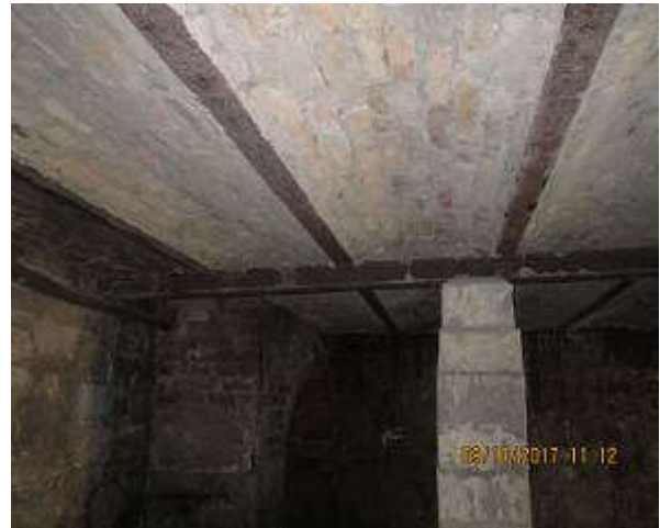
62,63. Vaade kirdest ja põhjast, võlvlagi on toetatud, algne kandekonstruktsioon. Fotod E.Kurg
