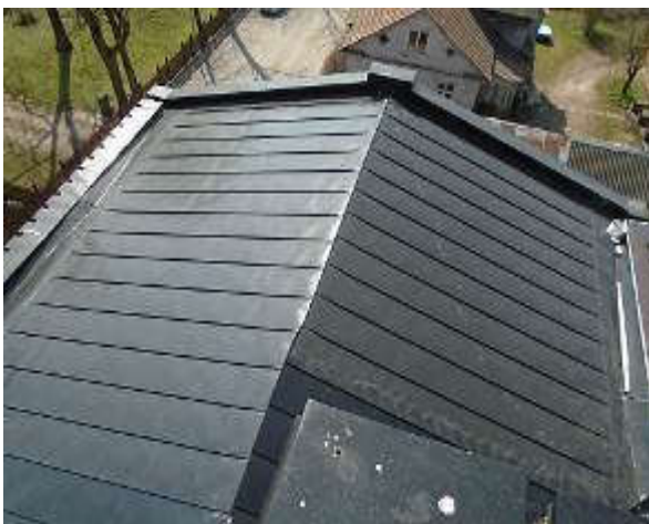
80,81. Vaade põhjast ja lõunast, valtsplekist katus on majal peal. Fotod T.Rihvk
