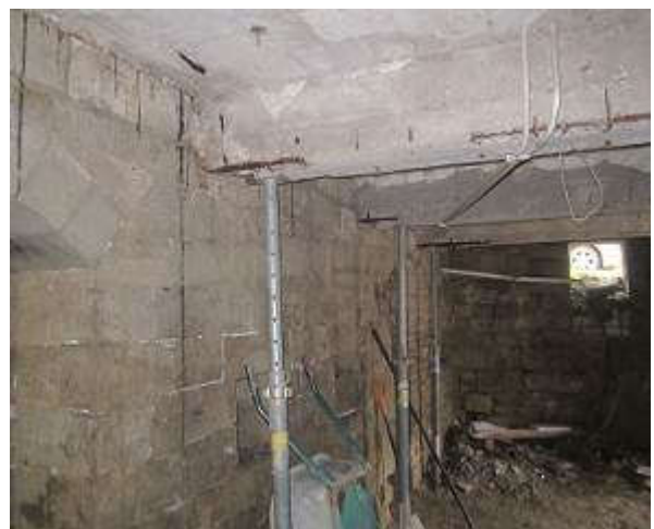
64,65. Hoone lõunapoolse osa valatud raudbetoon vahelaed, kandekonstruktsioonid on toetatud. Fotod E.Kurg
