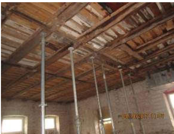
94,95. Vaade loodest ja põhjast, I korruse lõunapoolses osas lae toetus ja betoonpõranda lammutamine. Fotod E.Kurg
