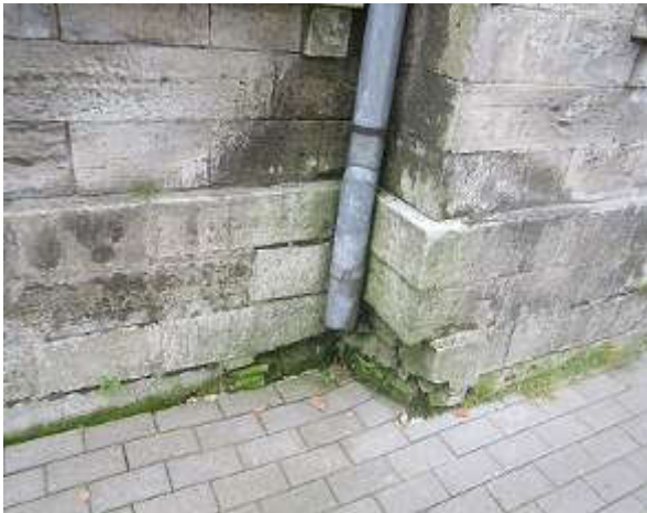
26,27. Vaade idast vihmaveetoru äravoolule vundamendi vahele ja eemaldatud vihmaveetorudele. Fotod T.Rihvk
