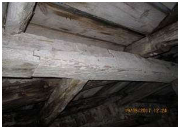
13,14. Vaade läänest, mädanikukahjustustega katusetalad ja laudis. Fotod E.Kurg
