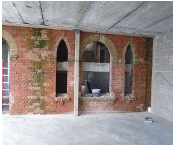
89. Vaade läänest välisseina parandustööd: telliste plommimine, vuukimine. Foto E.Kurg
