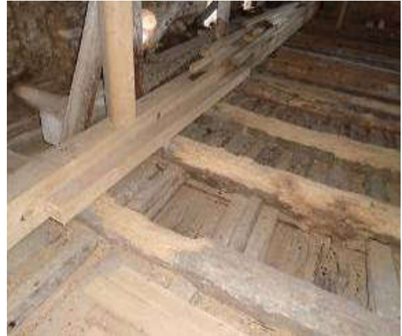
70,71. Pehkinud säsipuit on eemaldatud, toolvärgi talad asendatud, konstruktsiooni tugevdatud. Fotod E.Kurg
