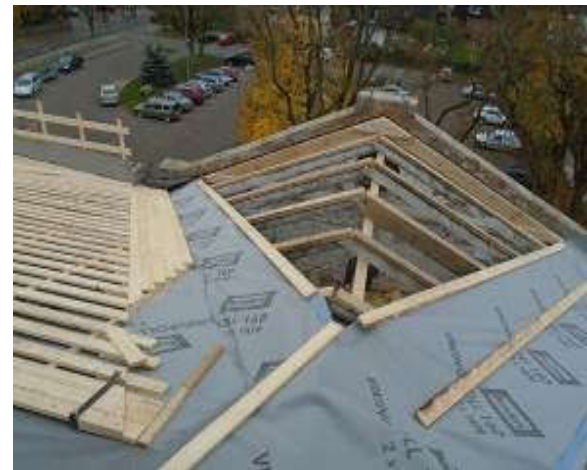
70,71. Pehkinud säsipuit on eemaldatud, toolvärgi talad asendatud, konstruktsiooni tugevdatud. Fotod E.Kurg
