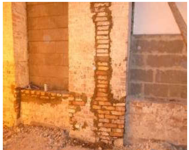
100,101. Siseseinte müüride proteesimine olemasolevate punaste tellistega. Fotod E.Kurg.
