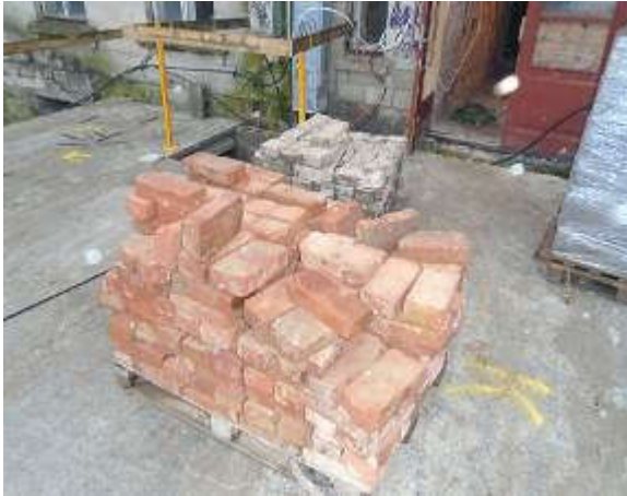
120,121. Säilitatud algsed tellised müüride parandustöödeks. Fotod E.Kurg
