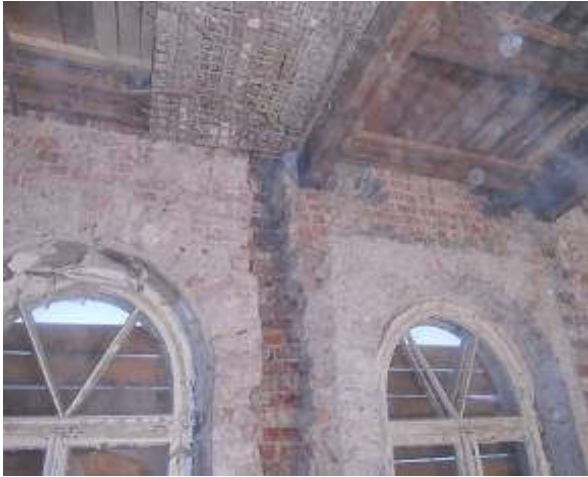
34,35. Vaade põhjast, II korruse lõunapoolne vahelagi ja sein pärast kütetorude eemaldamist. Fotod E.Kurg
