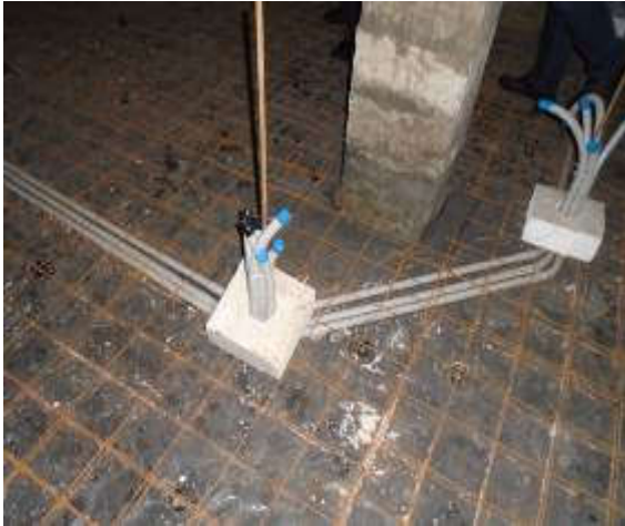
116,117. Keldri põrandakütte paigaldamine. Fotod E.Kurg
