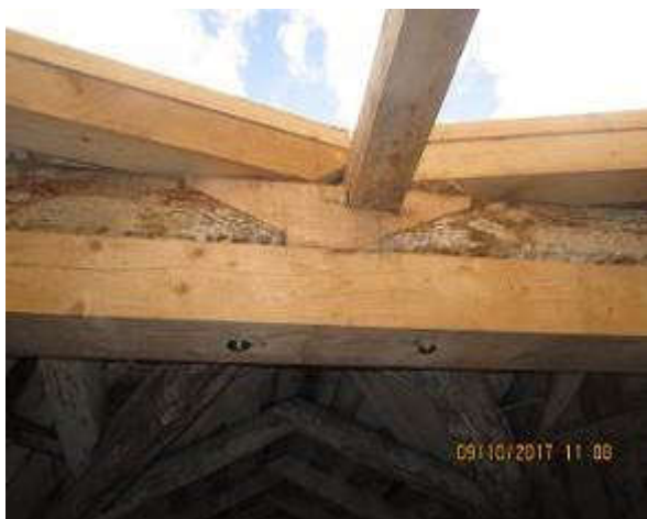
68,69. Katuse puidust kandekonstruktsioonist on pehkinud puit eemaldatud, talad proteesitud ja tugevdatud. Fotod E.Kurg
