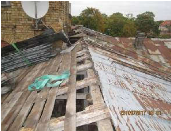
66,67. Vaade lõunast ja edelast, vanade katuseplekkide eemaldamine, pehkinud puitkonstruktsioonid on asendatud. Fotod E.Kurg
