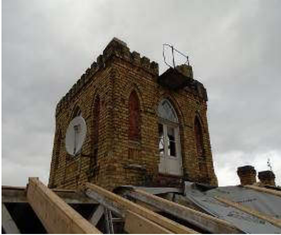
30,31. Vaade kagust torni platvorm on pealt ja külgedelt plekiga üle löödud, laudad mädanenud. Fotod T:Rihvk
