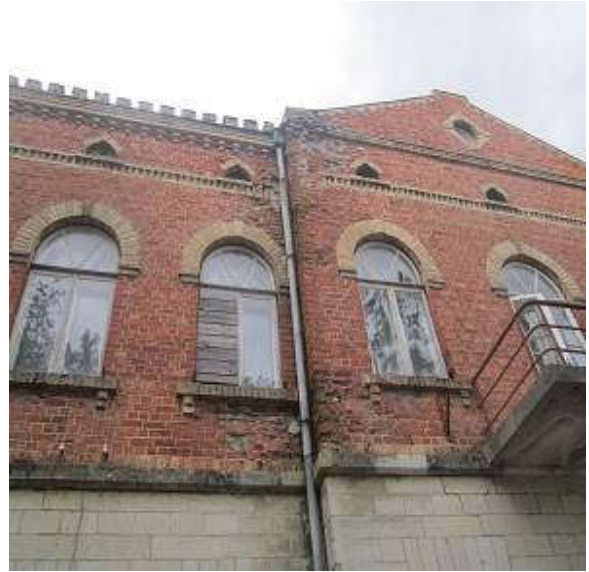
24,25. Vaade lääne- ja idapoolse külje vihmaveesüsteemide põhjustatud kahjustustest. Fotod T.Rihvk
