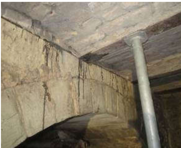
62,63. Vaade kirdest ja põhjast, võlvlagi on toetatud, algne kandekonstruktsioon. Fotod E.Kurg
