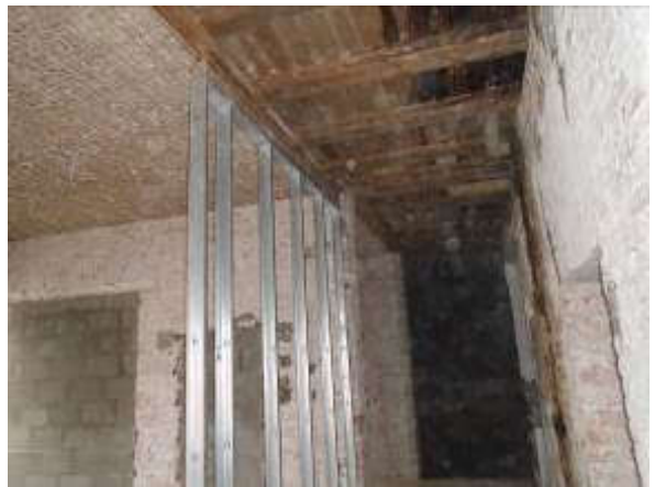
104,105. Vaade põhjast ja lõunast, ripakile vajunud roomatid toestati. Fotod E.Kurg
