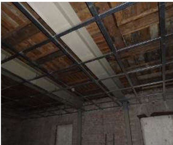
106,107. Vaade põhjast ja idast, I korruse lõunapoolse osa lae kandetalade postid toetuvad vundamendile ja talad ise kandvale vaheseinale ja ripplae karkass, krohvimistöõ. Fotod E.Kurg
