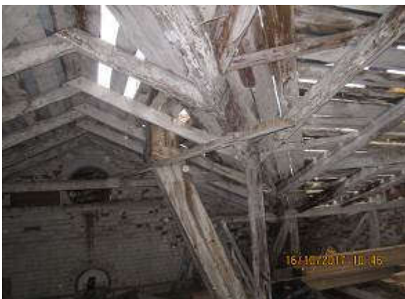
13,14. Vaade läänest, mädanikukahjustustega katusetalad ja laudis. Fotod E.Kurg
