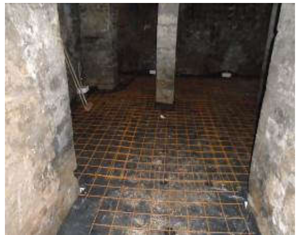
114,115. Trepi käsipuu puitkarkass enne eemaldamist, eeltööd keldri põranda soojustamiseks. Fotod E.Kurg
