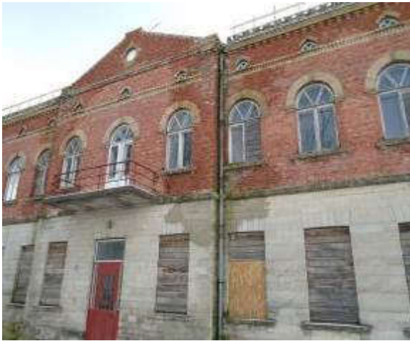
86,87. Vaade idast ja läänest, välisseinad on tugevalt märgunud, hoone nurkades rohkelt vetikaid. Fotod E.Kurg
