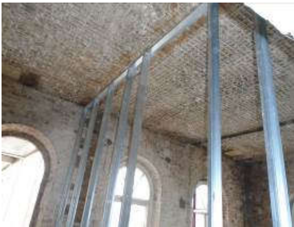
104,105. Vaade põhjast ja lõunast, ripakile vajunud roomatid toestati. Fotod E.Kurg
