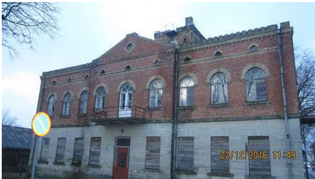
3. Vaade idast administratiivhoone Uue tänava poolsele fassaadile. Foto T.Rihvk
