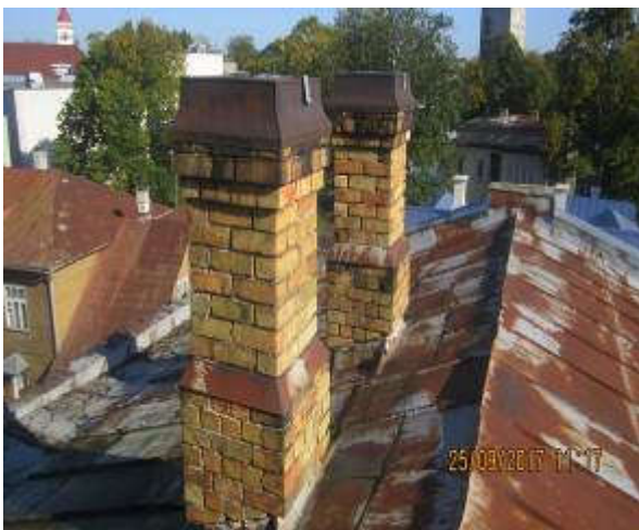
19,20. Hoone põhjapoolne valtsplekist katus, korstnad, plekil läbijooksud, karniisiplekki pole. Fotod T.Rihvk
