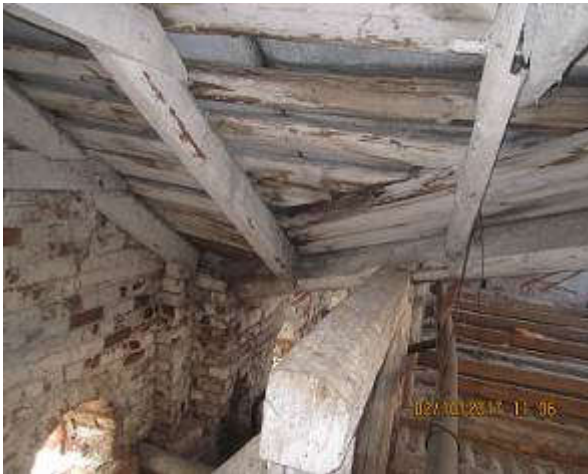
17,18. Vaade kirdest ja loodest, lõunapoolse otsamüüri lähedal sarikaotsad ja laudis pehkinud. Fotod E.Kurg
