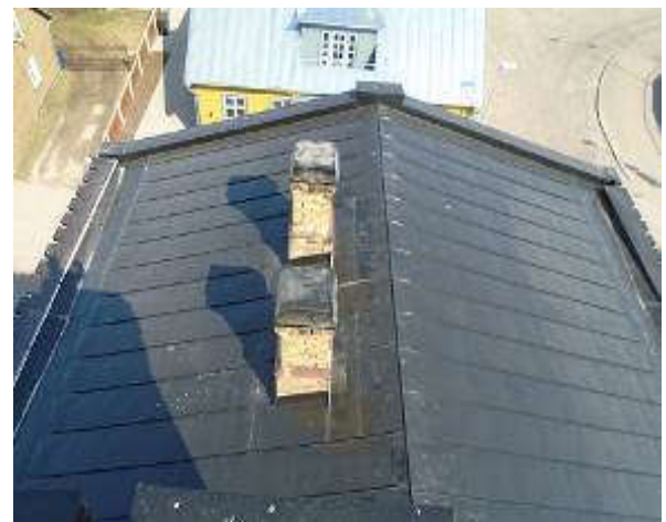
80,81. Vaade põhjast ja lõunast, valtsplekist katus on majal peal. Fotod T.Rihvk
