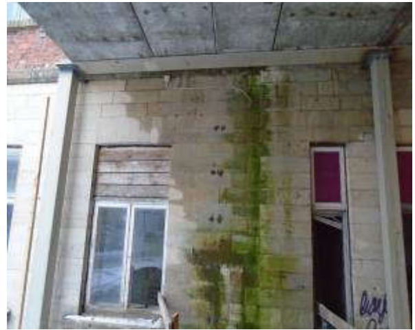
86,87. Vaade idast ja läänest, välisseinad on tugevalt märgunud, hoone nurkades rohkelt vetikaid. Fotod E.Kurg
