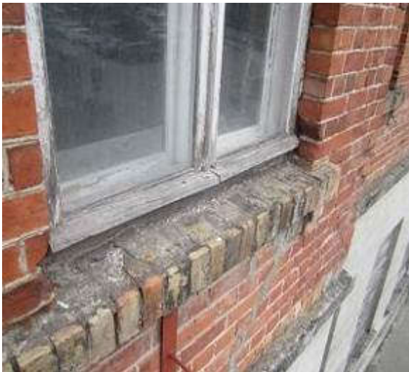
46,47. Vaade rõdult idapoolsele II korruse aknale, niiskusekahjustused lengil, raamil, veeninadel. Fotod T.Rihvk
