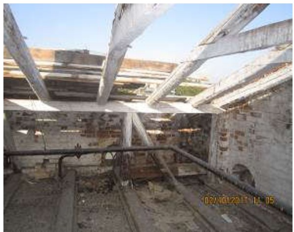
17,18. Vaade kirdest ja loodest, lõunapoolse otsamüüri lähedal sarikaotsad ja laudis pehkinud. Fotod E.Kurg
