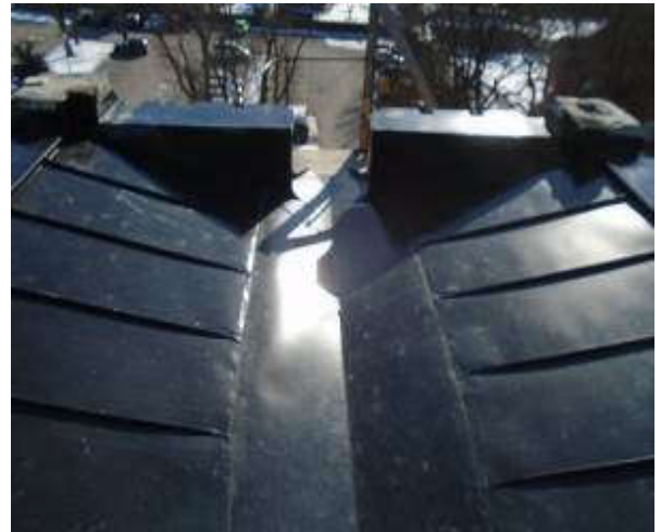
90,91. Vaade läänest, telliste parandustöö, tornil on valtsplekist katus peal, puuduvad nurgatippude mütsid. Fotod T.Rihvk
