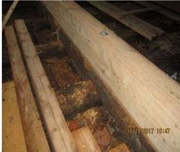
70,71. Pehkinud säsipuit on eemaldatud, toolvärgi talad asendatud, konstruktsiooni tugevdatud. Fotod E.Kurg
