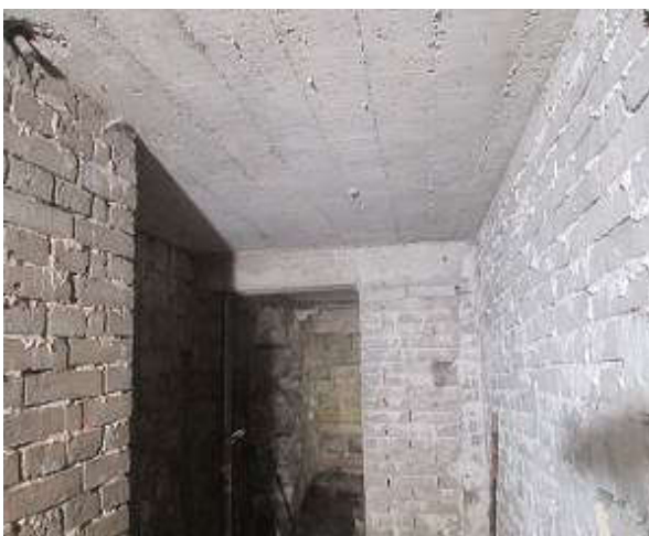
64,65. Hoone lõunapoolse osa valatud raudbetoon vahelaed, kandekonstruktsioonid on toetatud. Fotod E.Kurg
