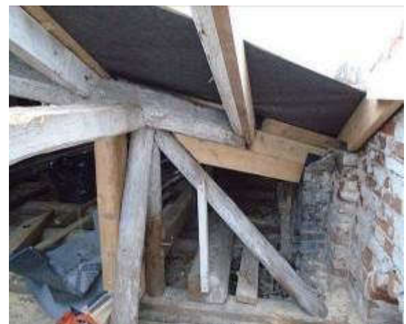
68,69. Katuse puidust kandekonstruktsioonist on pehkinud puit eemaldatud, talad proteesitud ja tugevdatud. Fotod E.Kurg
