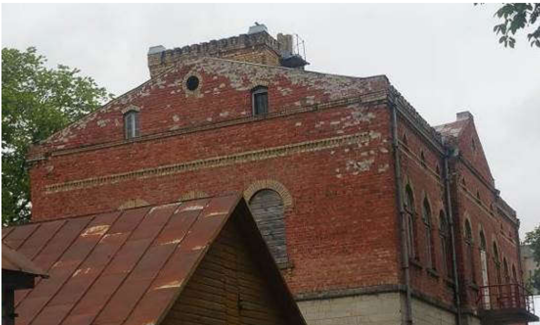
23. Tsementmördiga parandatud klinkertellised lõunapoolsel küljel. Foto E.Kurg
