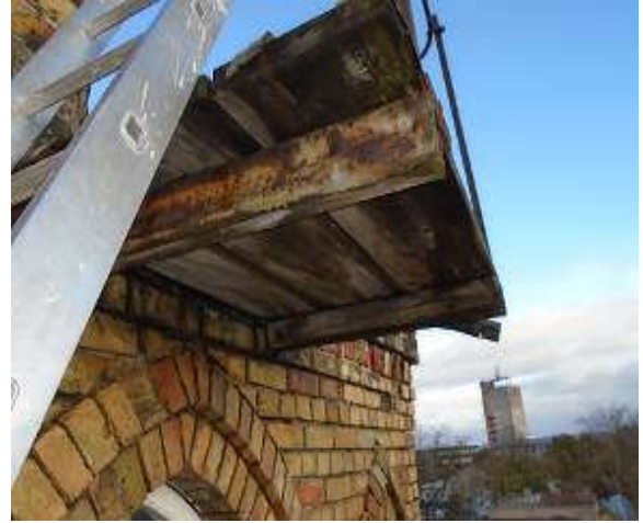
30,31. Vaade kagust torni platvorm on pealt ja külgedelt plekiga üle löödud, laudad mädanenud. Fotod T:Rihvk
