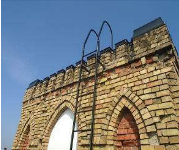
92,93. Vaade kagust ja läänest, torni katusetööd lõpetatud, nurgatippudel mütsid, metallist trepp restaureeritud, aknaavad kaetud, fassaadi parandustöid pole tehtud. Fotod T.Rihvk
