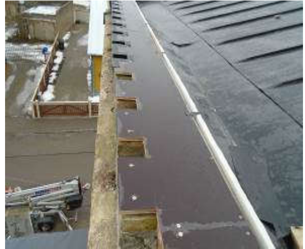
76,77. Vaade lõunast, torni karniis on mördiseguga parandatud, katusekarniis parandatud ja valtsplekiga kaetud. Fotod T.Rihvk
