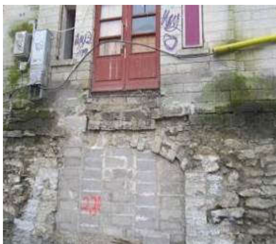
84,85. Vaade läänest, keldri seinte võlvide tugevdamine, hoone põhjapoolse osa ava säilitati. Fotod E.Kurg
