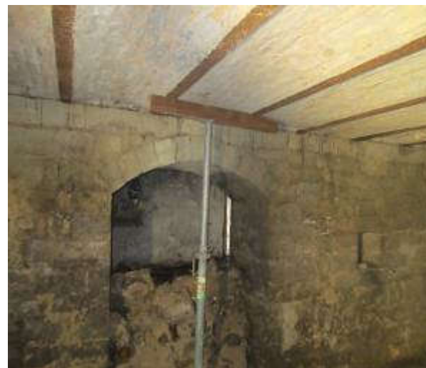
58,59. Vaade lõunast ja läänest paekivist müüridele, tellistest võlvlaele. Fotod E.Kurg
