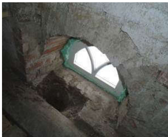
108,109. Vaade läänest, pööninguaknad restaureeriti ja paigaldati tagasi. Fotod E.Kurg
