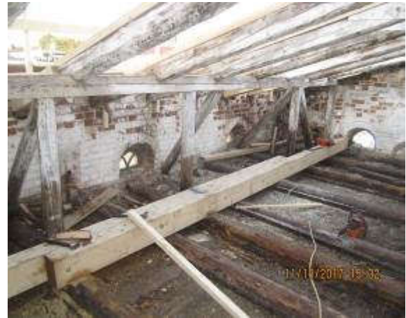
66,67. Vaade lõunast ja edelast, vanade katuseplekkide eemaldamine, pehkinud puitkonstruktsioonid on asendatud. Fotod E.Kurg
