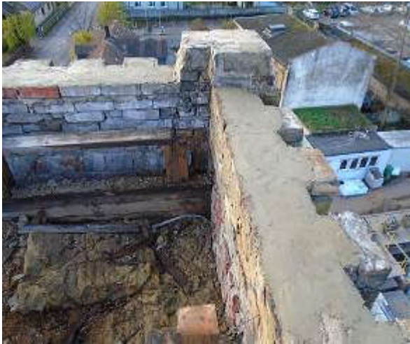
76,77. Vaade lõunast, torni karniis on mördiseguga parandatud, katusekarniis parandatud ja valtsplekiga kaetud. Fotod T.Rihvk
