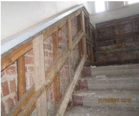
114,115. Trepi käsipuu puitkarkass enne eemaldamist, eeltööd keldri põranda soojustamiseks. Fotod E.Kurg
