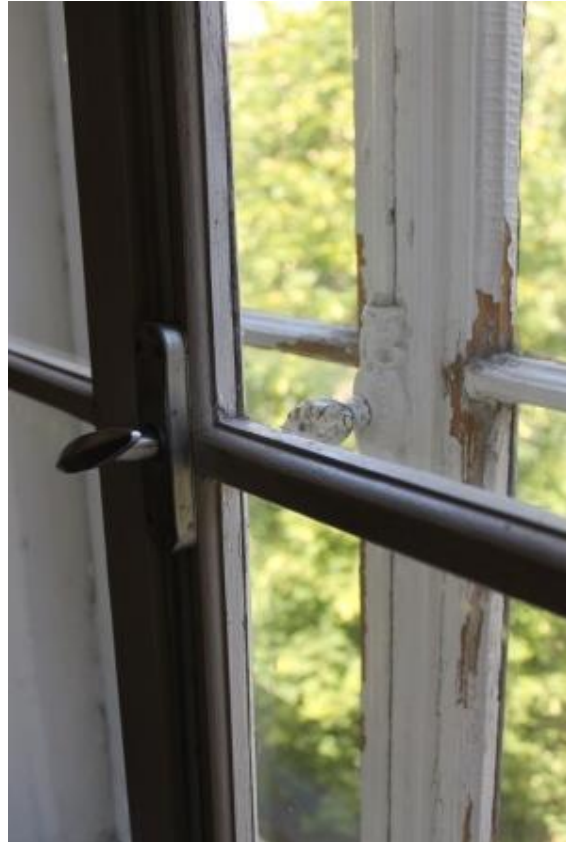
Fotod 24 ja 25. Aken A75, millel on säilinud algupäraseid puitraamid ning välise raami kremoon (sisemine krmoon on uuem).
