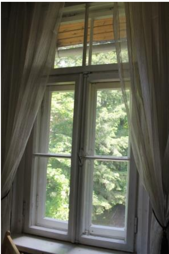
Fotod 24 ja 25. Aken A75, millel on säilinud algupäraseid puitraamid ning välise raami kremoon (sisemine krmoon on uuem).
