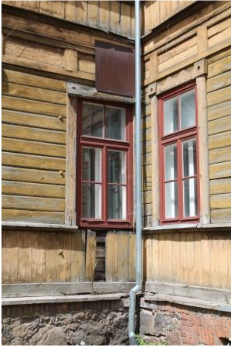
Fotod 11 ja 12. Kahjustused hoone fassaadi laudisel ja vundamendis.
