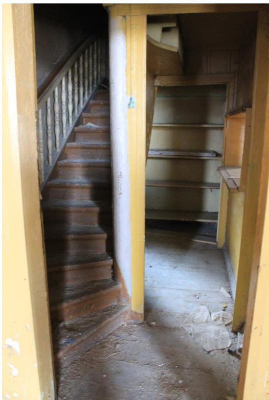
Foto 28. Idatiivas asuv algupärane trepp (ruum 52).
