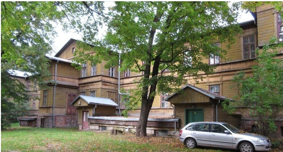
Foto 2. Vaade Staadioni tn 48 tagafassaadile. Esiplaanil näha lammutamisele kuuluv keldri juurde ehitis.
