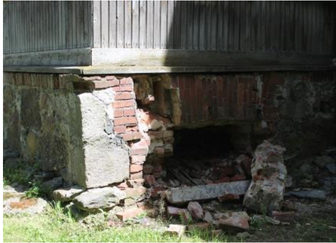
Fotod 11 ja 12. Kahjustused hoone fassaadi laudisel ja vundamendis.
