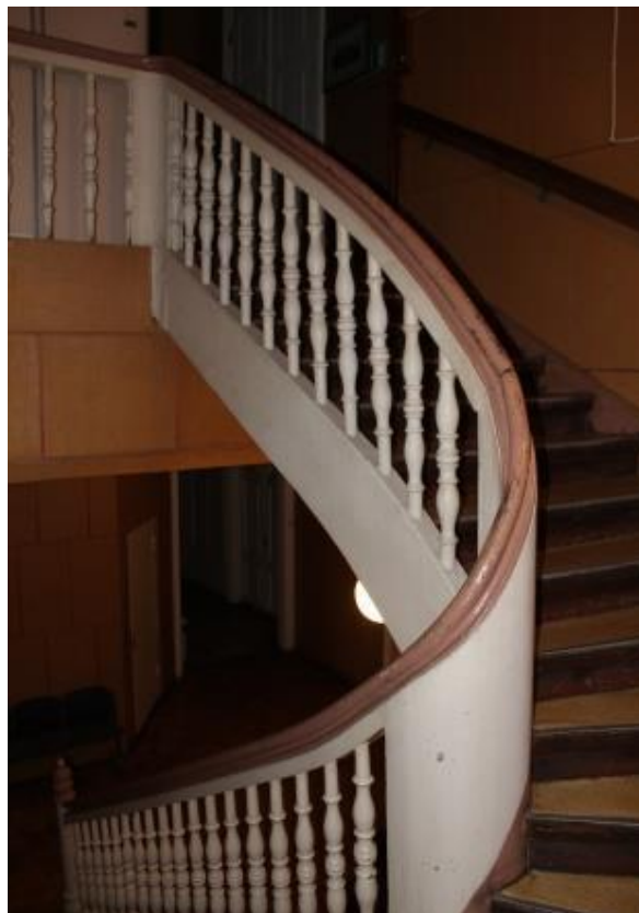
Foto 27. Säilinud algupärane puidust peatrepp
