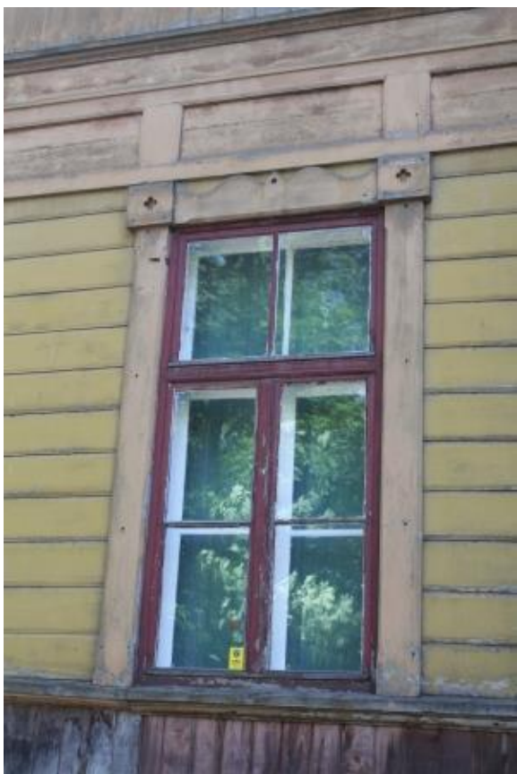
Fotod 14 ja 15. Näited säilinud algupärasest aknaraamist ja piirdeliistust (vasakul, A3) ning välja vahetatud plastikaknast, mis on jäetud piirdeliistuta (paremal, A53).
