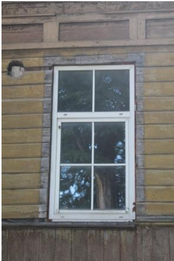
Fotod 14 ja 15. Näited säilinud algupärasest aknaraamist ja piirdeliistust (vasakul, A3) ning välja vahetatud plastikaknast, mis on jäetud piirdeliistuta (paremal, A53).
