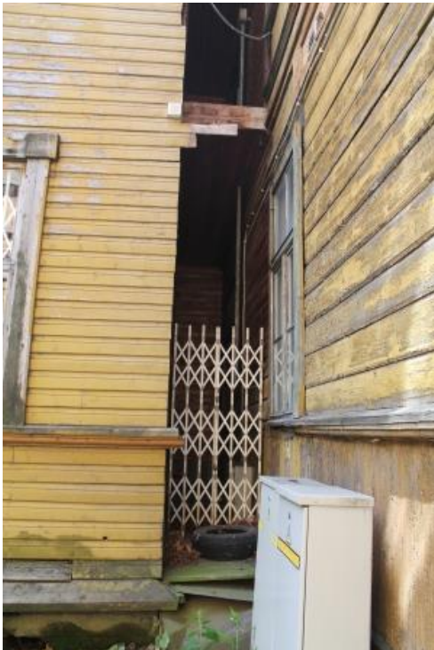
Foto 8. Juurdeehituste käigus tekkinud kummaline majasopp, kus peakorpuse küljeaken on vastasseinaga täiesti ära blokeeritud.
