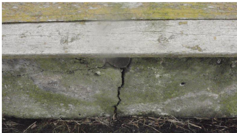
9. Raudtee tn 8 vundament (autori foto 09.03.2018)
