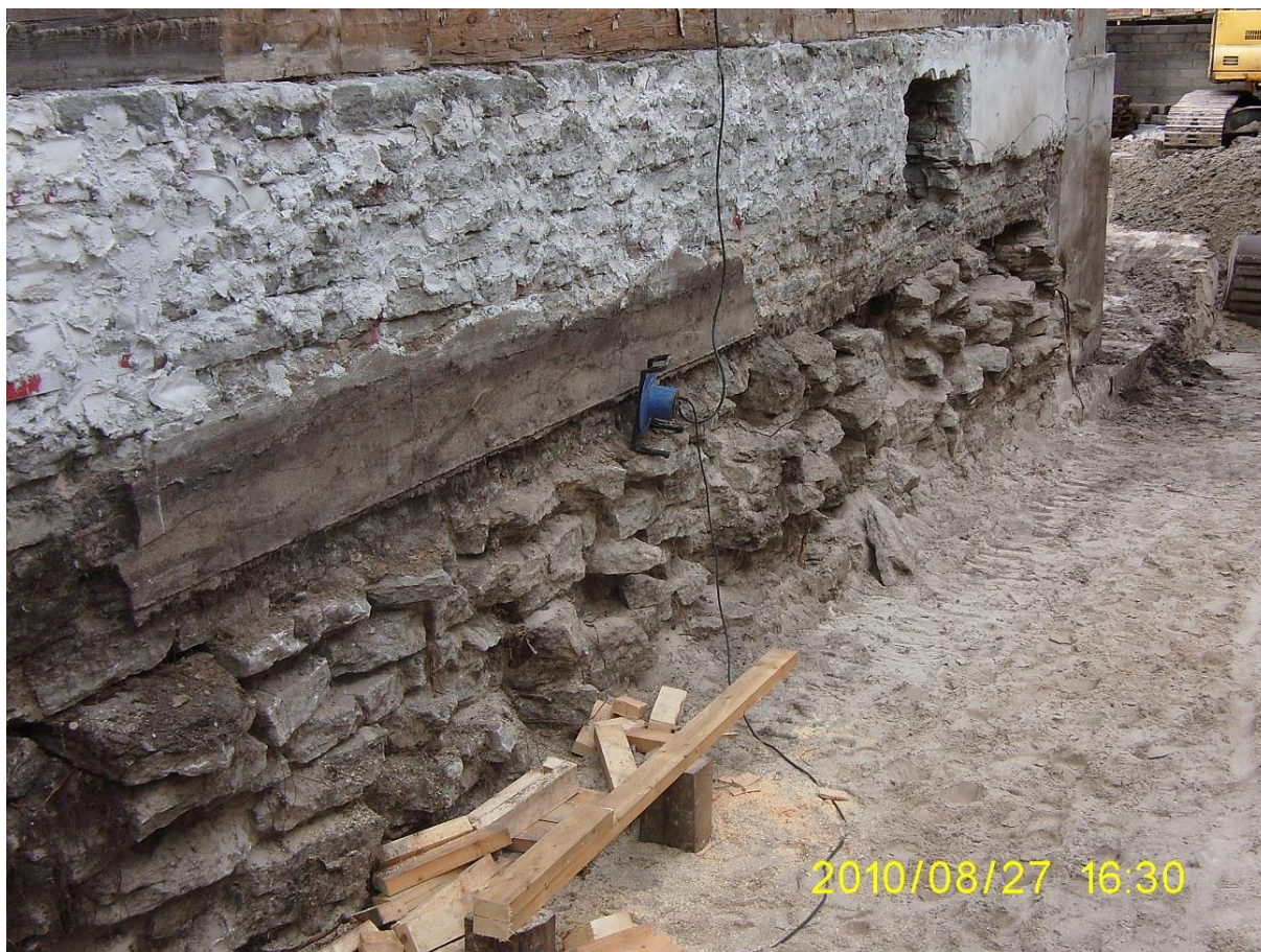
XIV. Vesivärava tn 13 vundament 22
