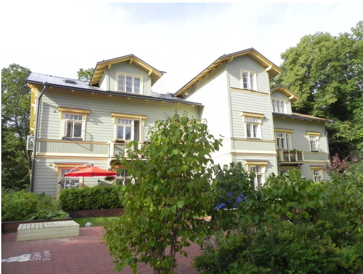
XV. Vesivärava tn 13, hoovi fassaadiosa 23
