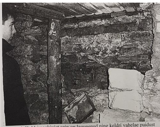
Foto nr.4. Keldri paekivist sein on lagunenu ning keldri vahelae puidust kandetala ei toetu enam keldri seinale, mistõttu vahelae kandetala alla on paigaldatud ajutine ümarpuidust post.
