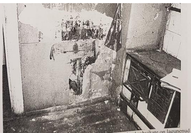
Foto nr.12. Korteris nr.7 köögi ja WC vahelise siseseina krohvikate on lagunened ja sõrestikseina puitlaudis on pehkinud.
