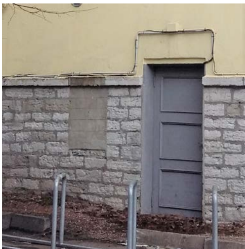
Foto 77. Kinniehitatud aknaava sisehoovi poolt. Autori foto.
