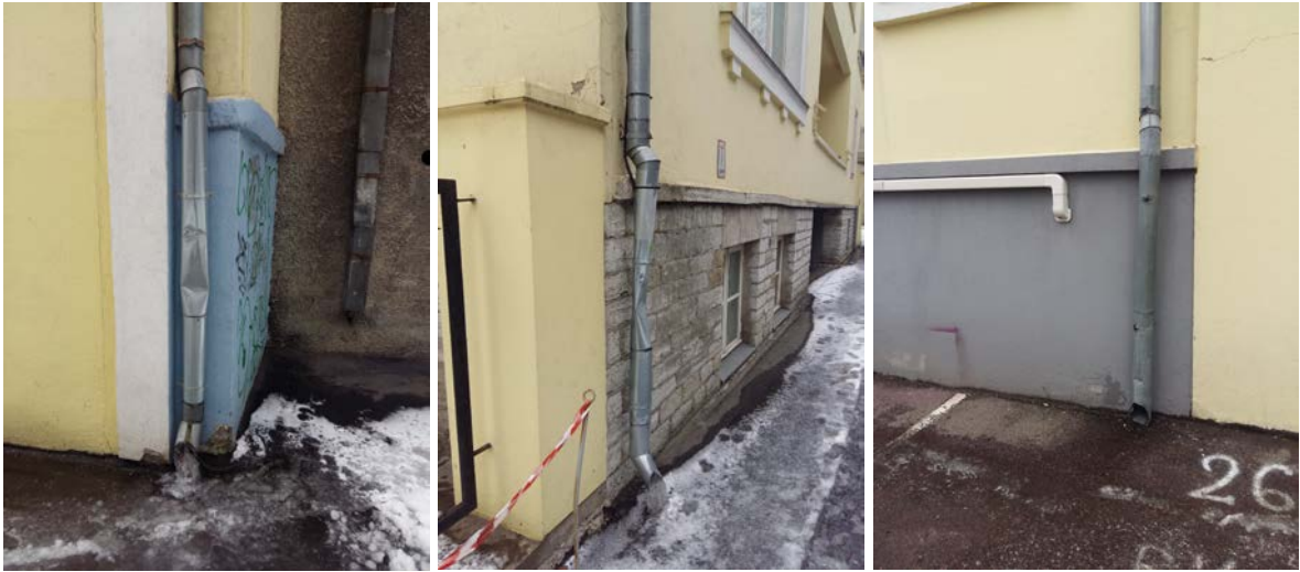
Fotod 45, 46 ja 47. Olemasolevad vihmaveetorud. Autori foto.
