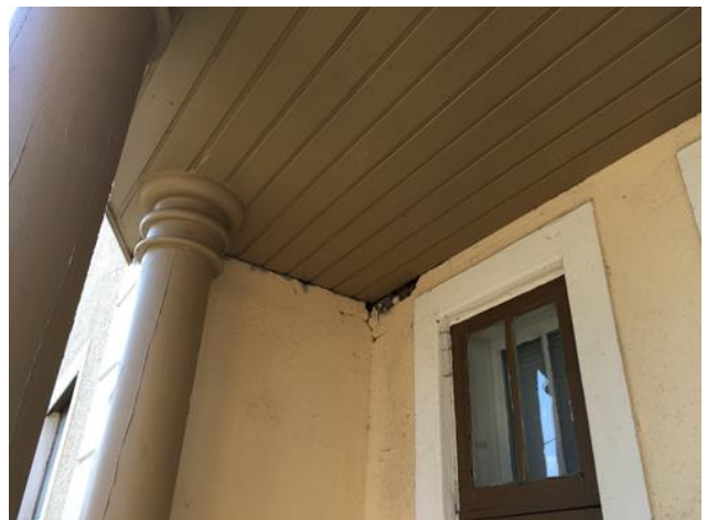
Foto 28. Sambad ja sein pärast remonttöid.
