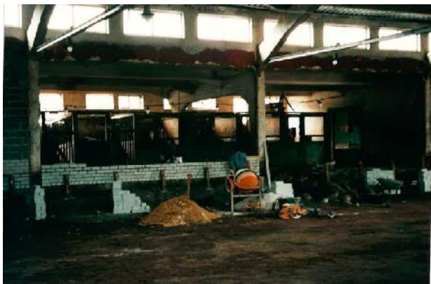
86 Maneeži ja talli vahele uue seina ehitamine (1998). Foto Sirje Argus'e fotokogust
