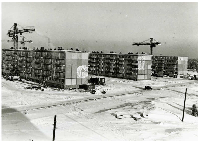
14. Otsaseinte pannood valmimisjärgus Mustamäel. 15. Akadeemia tee 6 otsaseina monteerimine.
