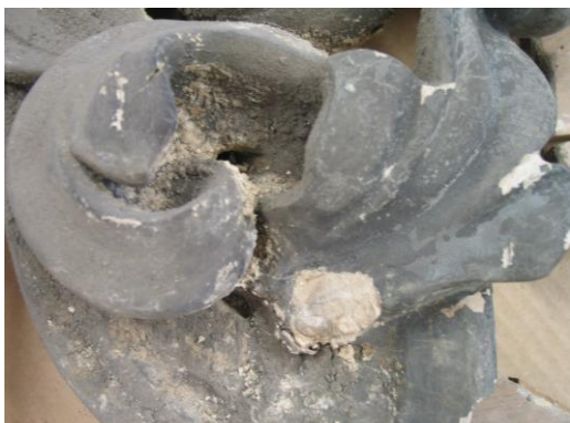
23. Vapp-epitaafi detail enne kuivpuhastust
