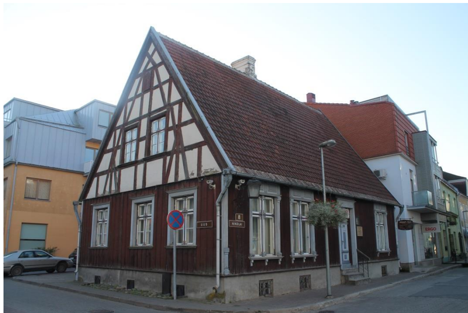
40. Restaureerimisjärgne hoone 2017. aastal.
