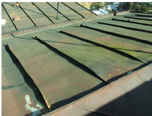
Ill. 15: Käitsi valtsitud tsink-plekk katus. Foto: Sandra Mälk. Kevad 2009.
