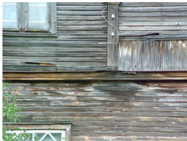
Ill. 13: Lõunaküljel on laudis lõhki kuivanud, on ka seenkahjustusi ja pehkimist. Foto: Sandra Mälk. Sügis 2008.
