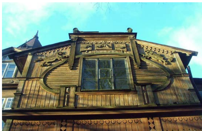
Ill. 23: Saelõiketehnikas dekoorielemendid ja figuurid II korruse veranda akna ümber. Foto: Sandra Mälk. Sügis 2008.
