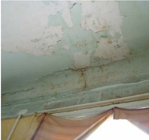
Ill. 24: Veeavariist põhjustatud kahjustus I korrusel korter 3-s. Foto: Sandra Mälk. Aprill 2009.
