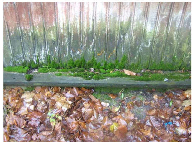
Ill. 11: Sokkel põhjaküljel, veelaud on sammaldunud. Foto: Sandra Mälk. Sügis 2008.
