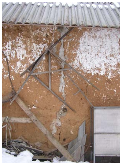
Foto 25: Seinaparandus tsementmördiga
